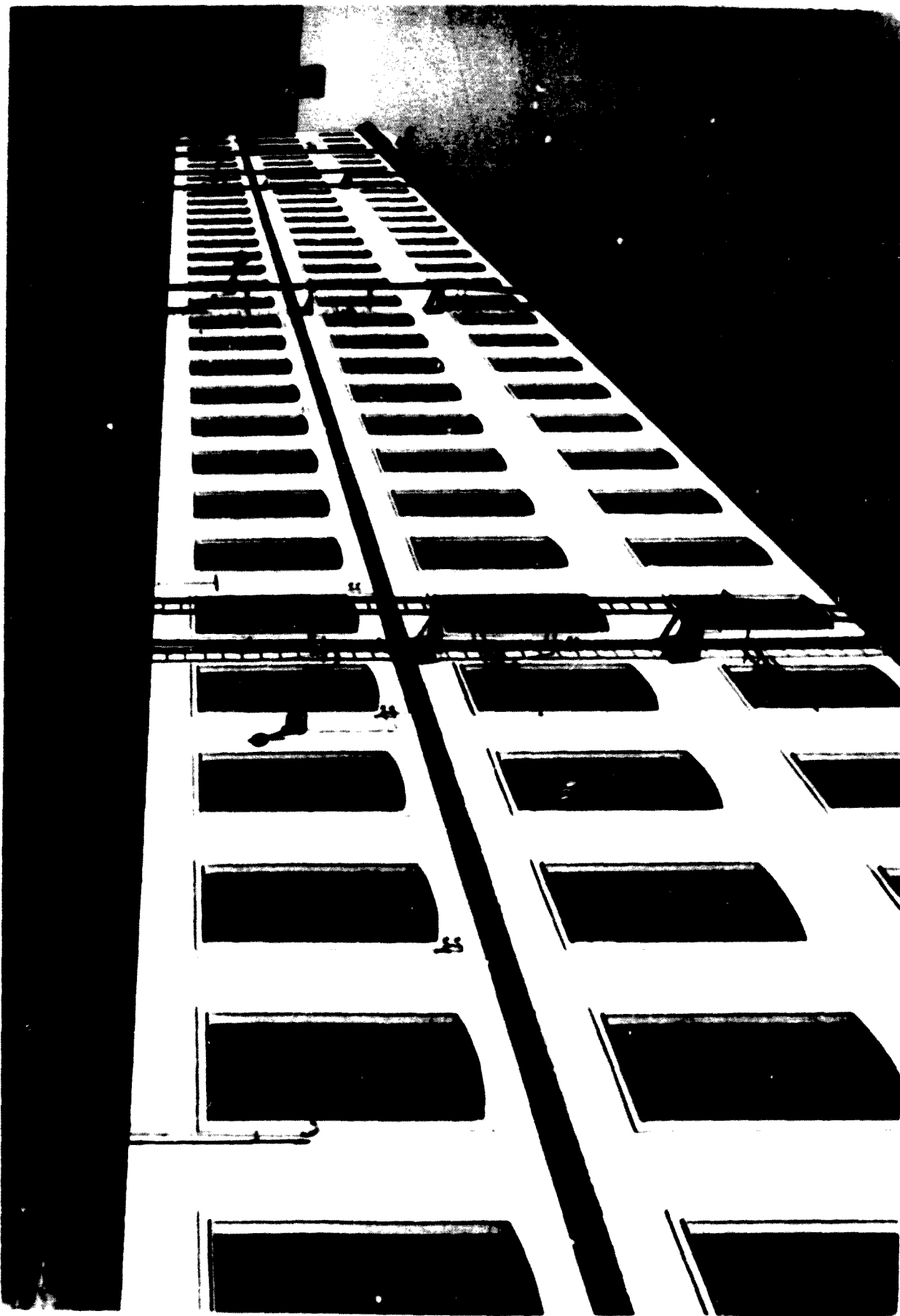
Edificio de Hietara
