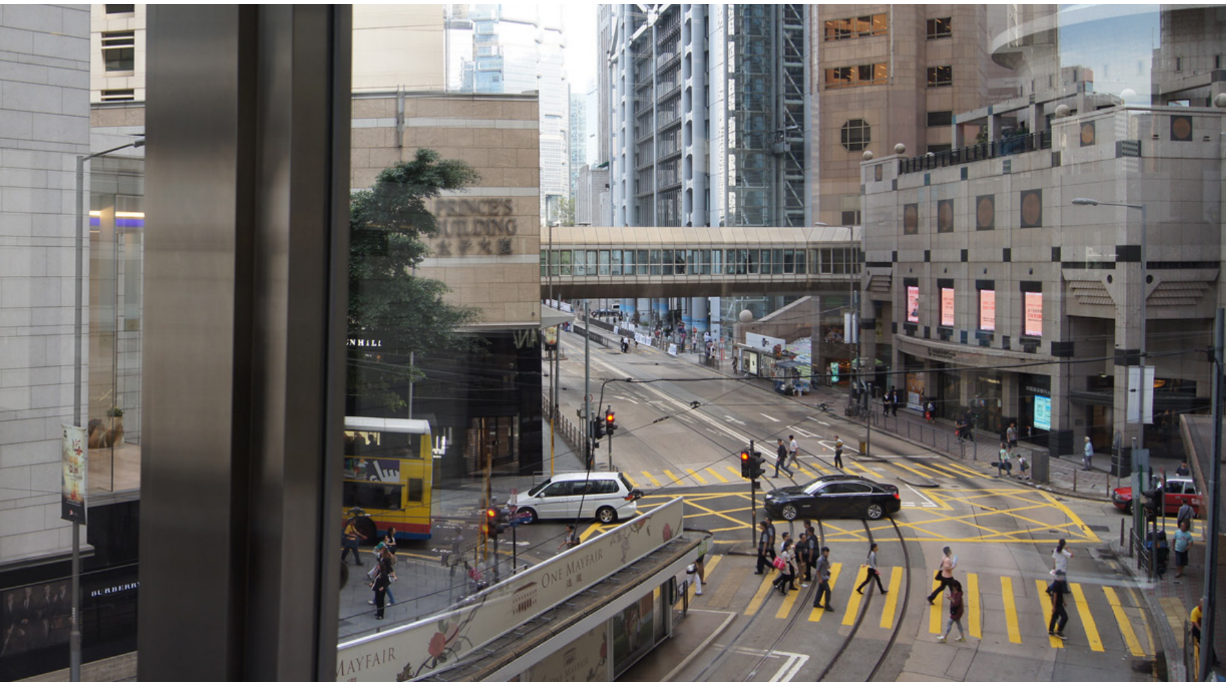
fig. 5.64 La conexión entre Alexandra House y The Lanmark Building.
