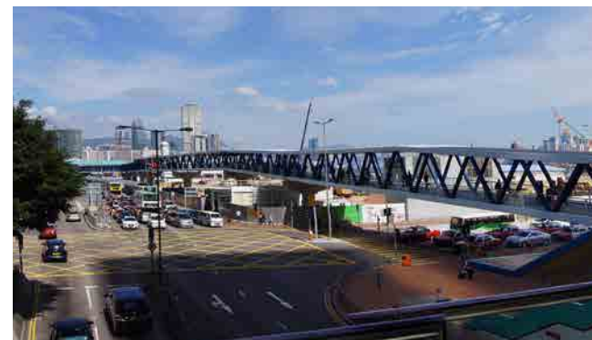
fig. 5.62 La pasarela de conexión hacia el Central Ferry Pier
