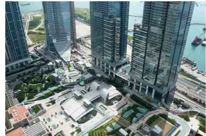
fig. 5.13 Una imagen aérea que muestra la estación de Union Square.
