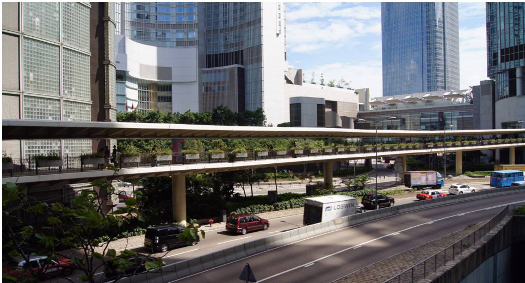
fig. 5.60 El skyway de conexión entre Sheung Wan y Central a lado de Connaught Road.
