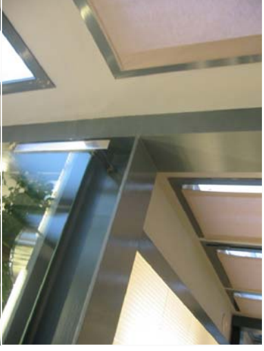
Detalle de encuentro de nueva estructura metálica
