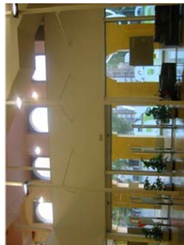
Vestíbulo de doble altura, donde se ha creado un vano en la planta de entresuelo de la planta primera
