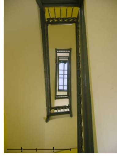
Se mantiene la escalera y se utiliza como núcleo de comunicaciones.
