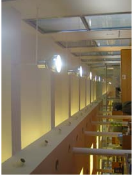
Uso de ciéferes rectos para dar un nivel de climatización alineados longitudinalmente con las aberturas originales
