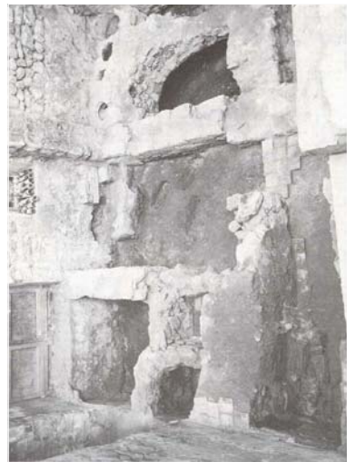
Excavaciones cimientos y restos arqueológicos del interior de la rectoría.
