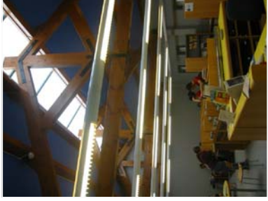
Claraboya y estructura de cubierta de Planta Tercera
