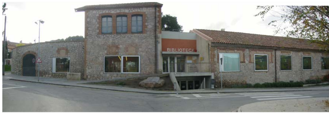
Fachada actual de la edificación
