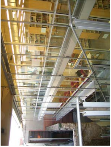
Vista de la fachada interna de la edificación
