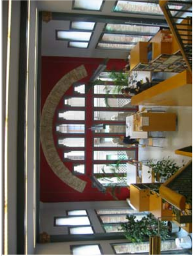
Interior del área de Planta Primera, se mantienen malduras de pilastras, se deja el arco a la vista y se incorpora un altillo
