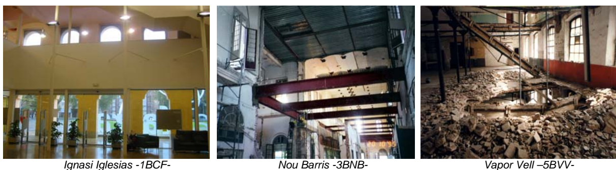
Figura 70. Remoción parcial o total de forjados
