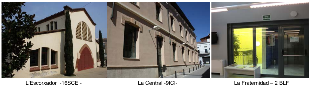
Figura 83. Salidas de emergencia – vías de evacuación
