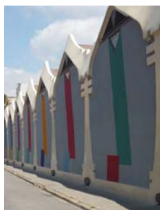
Figura 32. Biblioteca pública Cancasacoberta.
