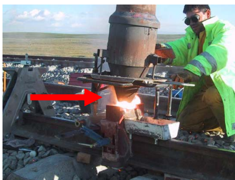
Fig. 6.9. Soldadura de vía 29
