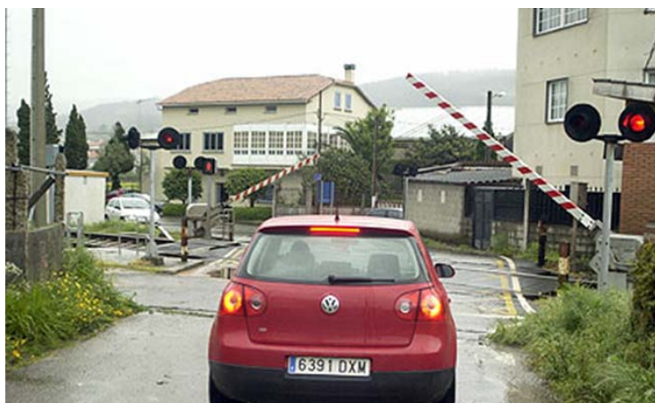
Paso a nivel protegido por semibarreras enclavadas con las señales y paso peatonal señalizado.
