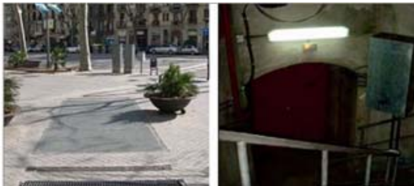
Fig. 7.15 Salida de emergencia, exterior la calle e interior
