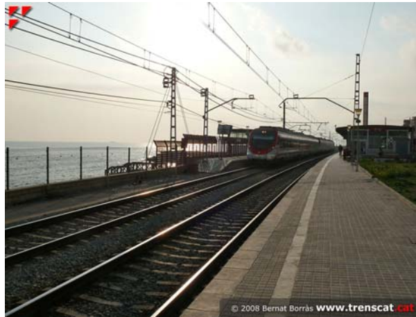
Fig. 12.2. Cerramiento a lo largo de la vía
