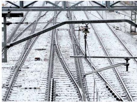
Fig. 13.5 Conservación de vía Fuente: Declaración de Red ADIF. 2009
