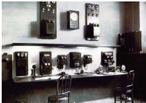
Gabinete telefónico de la estación de Lleida
