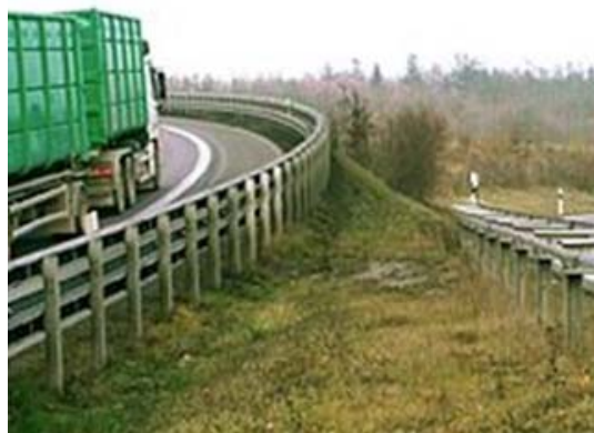
Fig. 8.3 Guardarrail para protección de salidas de la carretera
