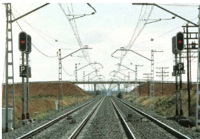
Vista de un de trayecto con bloqueo automático banalizado 64
