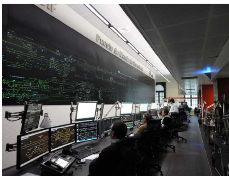
Sala de CTC (Puesto de Mando de Barcelona).
