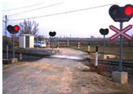
Fig. 4.6 Paso a nivel, clase B. Protección con, señales fijas, luminosas y acústicas
