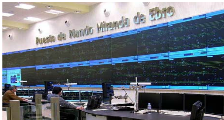
Fig. 3.5 Puesto de Mando de Miranda de Ebro
