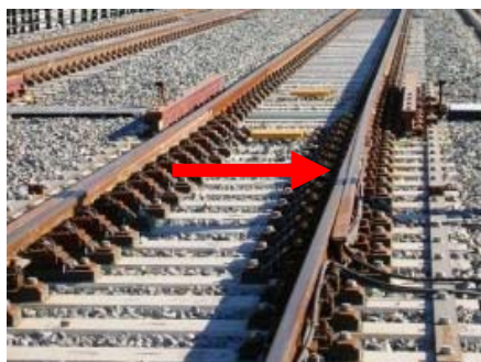
Fig. 6.10 Aparato de dilatación.
