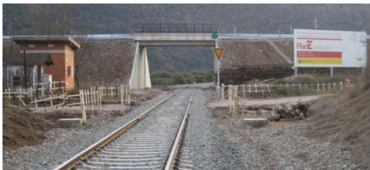
Paso elevado en la carretera de La Peña a Jaca para supresión de un paso a nivel
