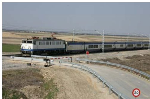
Fig. 4.9 Paso a nivel, clase E. Protección con personal a pie del paso Fuente: RENFE Internet. Pasos a nivel
