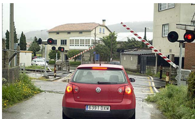
Fig. 4.13 Paso a nivel protegido por semibarreras enclavadas con las señales y paso de peatones anejo. Fuente: Internet pasos a nivel.
