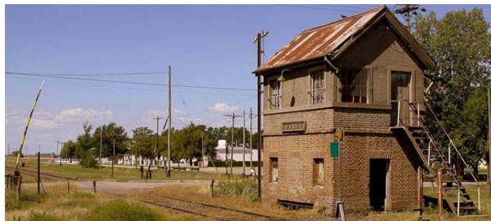
Antiguo paso a nivel de barreras levadizas accionado con transmisión alámbrica
