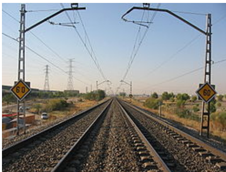
Figura 11.7 Doble vía electrificada sin compensar. Tipo RENFE. Años 1950-60
