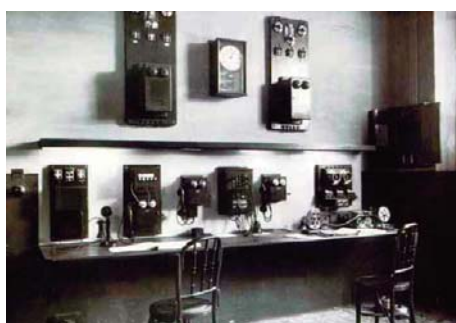
Fig. 5.3 Gabinete telefónico de la estación de Lleida
