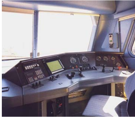
Fig. 5.29 Cabina de conducción de locomotora serie 252 con sus indicadores y registradores
