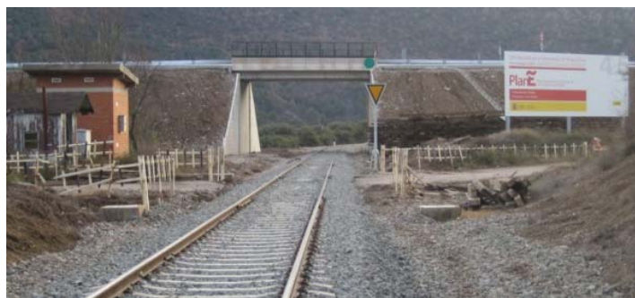
Fig.4.12 Paso elevado en la carretera de La Peña a Jaca para supresión de un paso a nivel.
