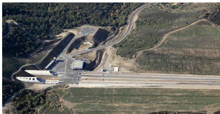
Fig. 13.2 Bis Túneles de El Perthus en bitubo cruzando los Pirineos. Fuente: Internet. Inauguración AVE Barcelona-Figueras 8-1-2013
