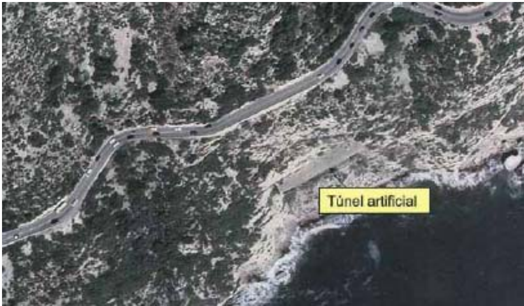
Fig. 8.5 Costas del Garraf. Zona del accidente y túnel artificial construido posteriormente Fuente: Elaboración propia del autor que tuvo encargada la investigación del accidente
