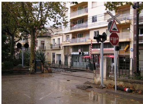
Fig. 4.11 Pasos a nivel protegidos de las clases C. Semibarreras enclavadas con las señales de la estación. Fuente: archivos del Autor en visita de inspección a pasos a nivel. Calella
