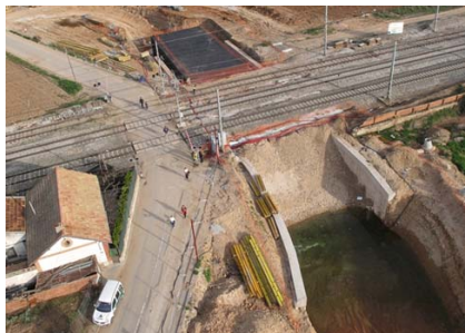
Supresión de un paso a nivel y construcción de un paso inferior al lado
