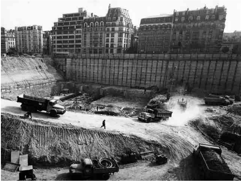
Excavación para la construcción del Centro George Pompidou, 1972. París
