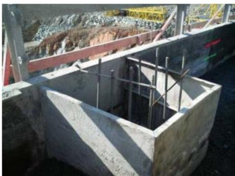
**Figura 206. Armaduras de arranque en el encofrado del paramento.**
