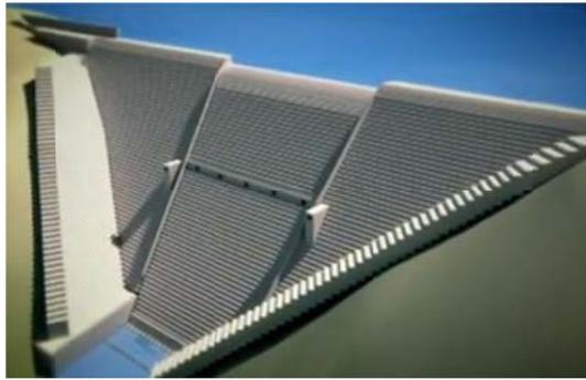
**Figura 14. Esquema de ampliación de la presa Cotter.**
