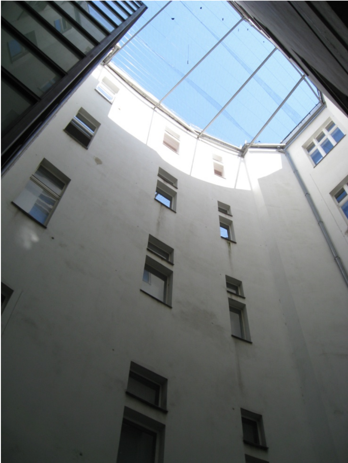
4.38 PATIO INTERIOR DEL EDIFICIO DE VIVIENDAS Y OFICINAS EN NEU-TEMPELHOF. HOHEN-ZOLLERN-CORSO 1 DREIBUNDSTRASSE . 1912-1913 (FOTOGRAFIA 2009)
