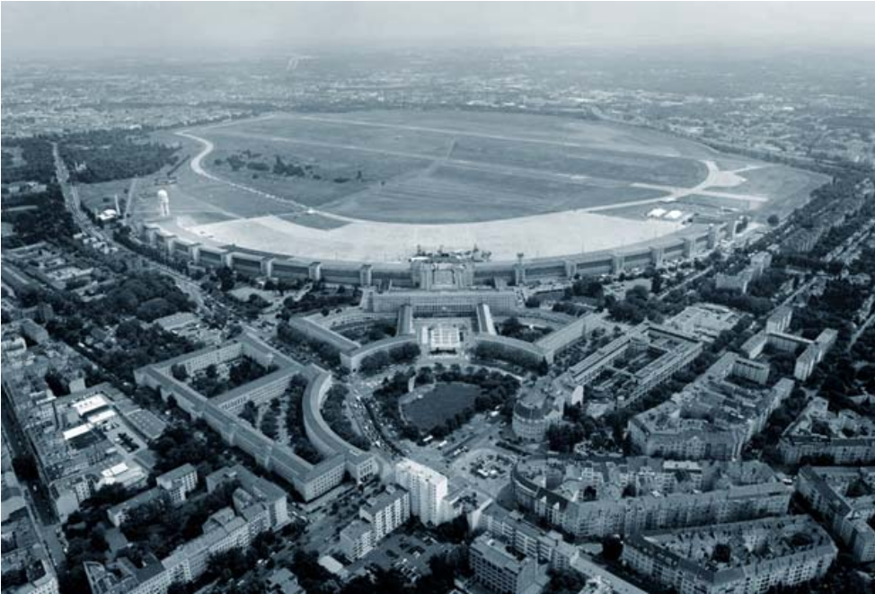
4.29 EM PLAZAMIENTO DEL AEROPUERTO DE TEMPELHOF
