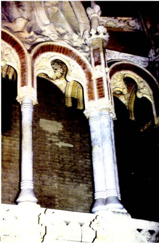
Foto 30 Vista de la part frontal de la sala d'actes al primer pis del cos central del pavelló d'Administració.
