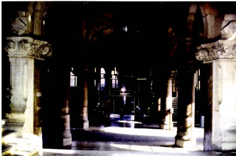
Foto 24 Vista del vestíbul central de la planta baixa del pavelló d'Administració des de l'escala principal, concebut com una zona de pas suportat sobre robustes columnes.
