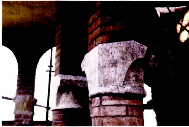
Foto 37 Capitells enguixats de les columnes de maó de la torre del rellotge que corona l'edifici del pavelló d'Administració.
