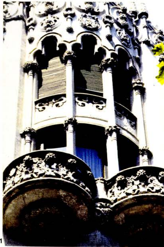
Foto 10 Estat actual del temple de coronament de la cantonada de la façana de la Casa Lleó Morera, després de la seva reelaboració, doncs havia estat destruït durant la guerra civil. Els elements de la seva decoració no corresponen exactament a l'original, encara que també hi havia gran profusió ornamental.
