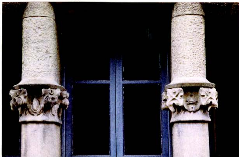
Foto 20 Detall de les columnes de la planta semisoterrani a la façana posterior del pavelló d'Administració amb capitells d'inspiració gòtica evolucionats.
