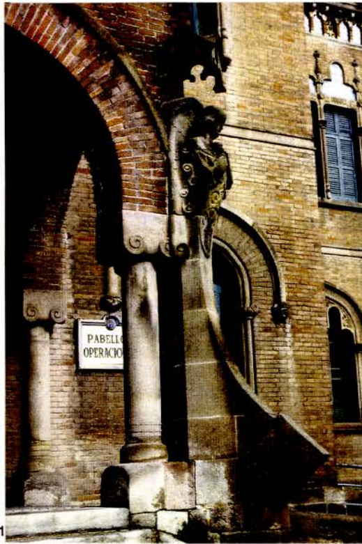
Foto 50 Detall de l'angle de la façana posterior del pavelló de Sta. Apolònia. La columna és d'inspiració gòtica i el seu capitell es reproduïx a les pilastres de maó que emmarquen les obertures.
