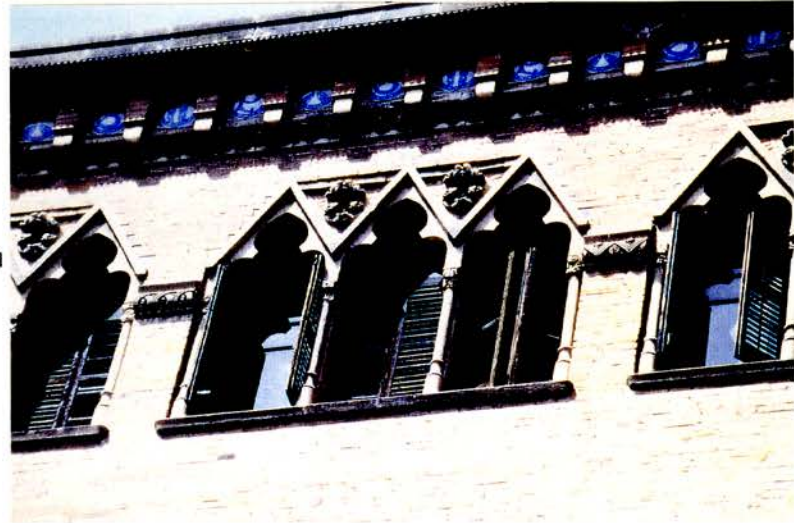
Foto 11 Detall de la sèrie de finestres corregudes del segon pis a les ales de la façana principal del Pavelló d'Administració, sobre les quals hi ha un fris amb botons de ceràmica que recorre el llarg de tot l'edifici.
