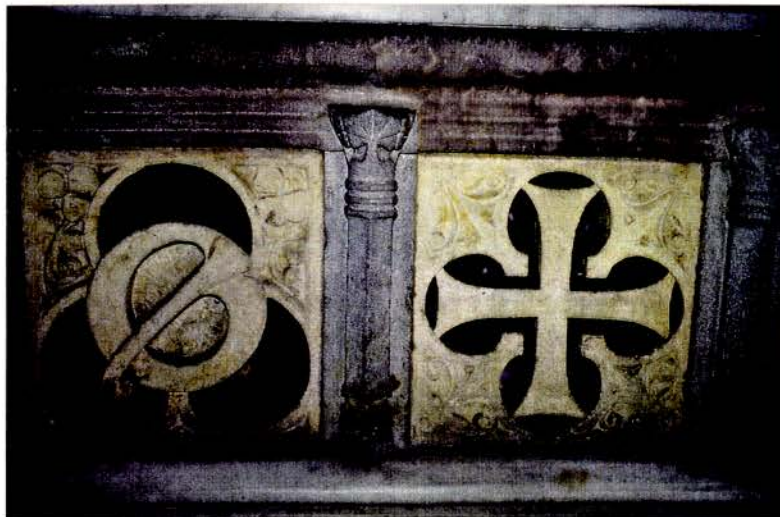
Foto 40 Detall de la balustrada de l'escala principal del pavelló d'Administració amb els anagrames de l'Hospital (G de Gil i creu petada) separats per columnetes de pedra girades amb capitell coronat.
