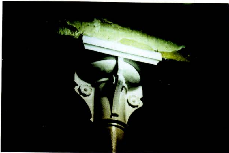
Foto 8 Detall de capitell de columnade fosa amb quatre cartelles decorades amb flors individualitzades, situada a l'interior de la planta baixa del Gran Hotel de Palma.
