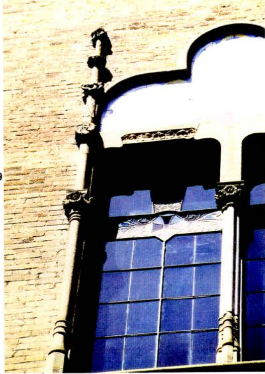
Foto 9 Detall d'una de les finestres del primer pis de les tres ales del pavelló d'Administració a la façana principal, amb columnetes adossades amb decoració d'inspiració gòtica.
