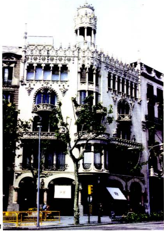
Foto 1 Vista general de la façana de la Casa Lleó Morera, composta de planta baixa i quatre plantes pis. La cantonada queda accentuada per una terrassa al coronament. Tot el conjunt està molt ornamentat.
