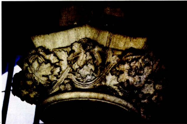
Foto 23 Detall d'un dels capitells de les columnes del vestíbul central de la planta baixa del pavelló d'Administració amb àbac octogonal sobre pitell amb motius vegetals
