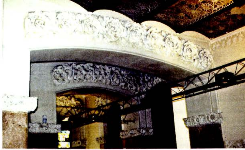
Foto 13 Arcs corresponents al rebedor interior del quart pis, amb decoració consistent en garlandes florals a la part frontal dels arcs. Les mènsules sobre les pilastres estan nues, però es revestiran al pis inferior amb rams.
