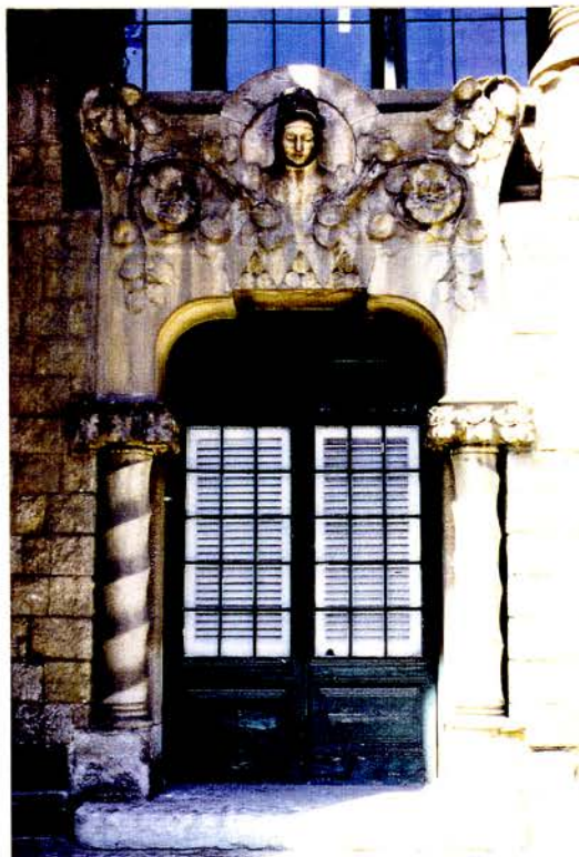
Foto 12 Porta d'accés de l'ala oest a la façana principal del pavelló d'Administració amb columnes salomòniques coronades per ornamentació floral centrada per un bust.
