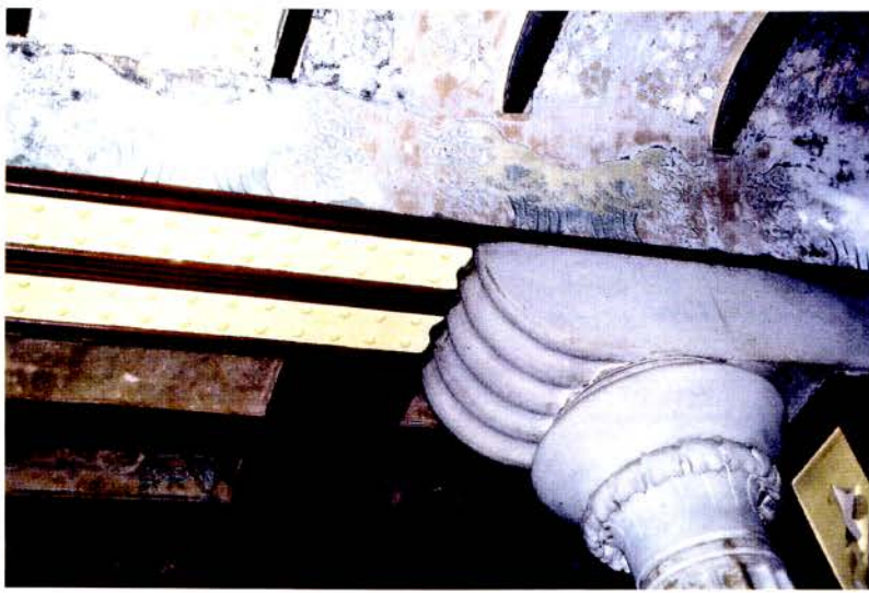
Foto 9 Part superior de columna en pedra del menjador d'hostes de la Fonda Es- panya, amb capitell sem- blant al palmiforme egipci, sota mènula que su- porta jàssera metàl·lica.
