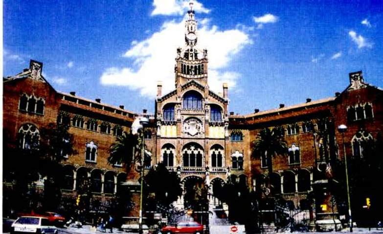
Foto 1 Vista de l'entrada de l'hospital de Sant Pau, amb façana principal del pavelló d'Administració.
