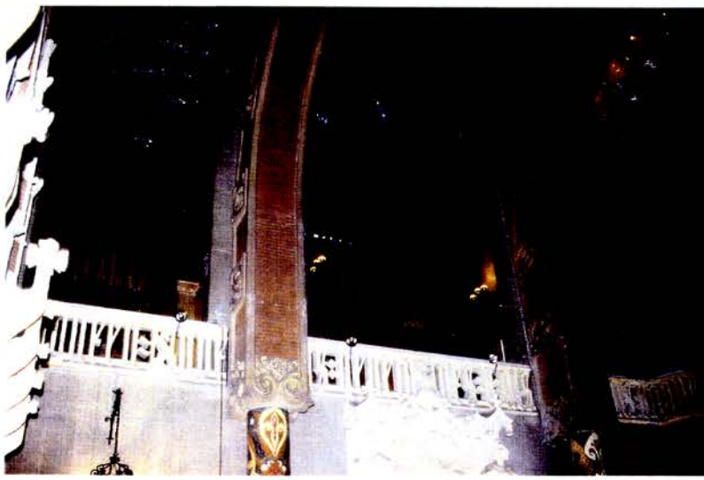
Foto 29 Sostre de la sala d'actes que es recolza sobre grans arcs de maó suportats per columnes de capitell cúbic i fust de mosaic policrom, a la planta primera del cos central del pavelló d'Administració.
