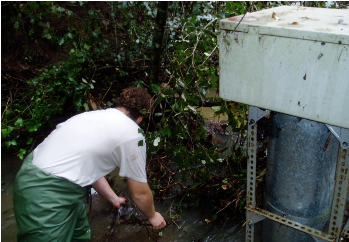
Figura 9. Trabajos de limpieza en la estación de aforo de Bosc después de la crecida de octubre 2005.
