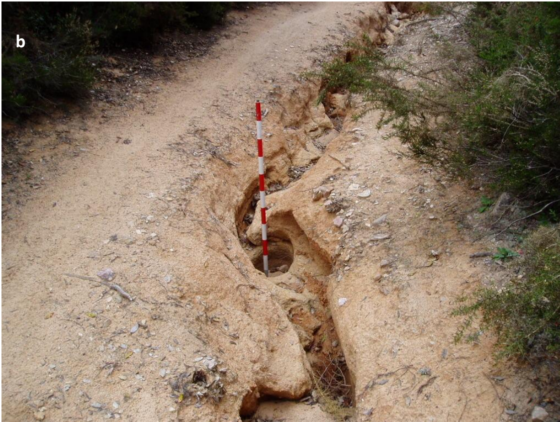
Figura 12. a. Estudio sobre la jerarquización de los caminos forestales en la cuenca de Vernegà. b. En la fotografía puede observarse como se ve la roca madre desnuda lo que facilita que el agua de escorrentía circule con mucha facilidad en estos caminos forestales.
