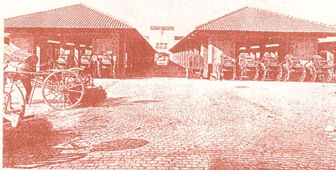
Cotxeres del servei de neteja, situades a la carretera del Port.
