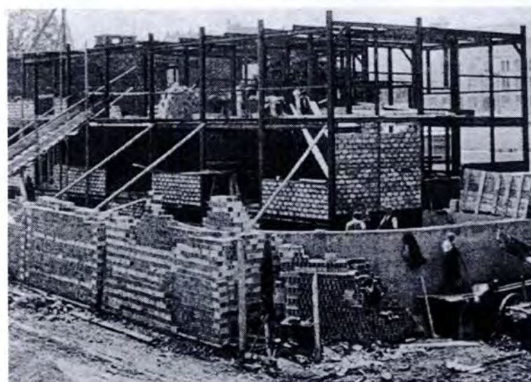
35. Colonia Weissenhof en construcción, 1927.
