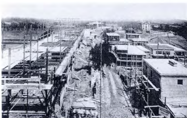
33. Colonia Weissenhof en construcción, 1927.
