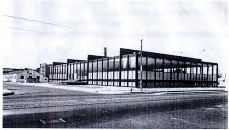
56. Mies van der Rohe. Campus del IIT, exterior del Crown Hall en construcción.
