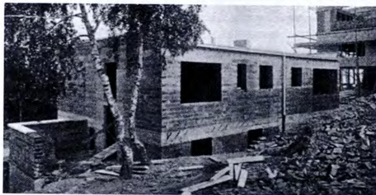
32. Colonia Weissenhof . Vivienda de Hilberseimer en construcción, 1927.
