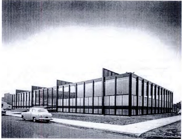
57. Mies van der Rohe. Campus del IIT, exterior del Crown Hall en construcción.
