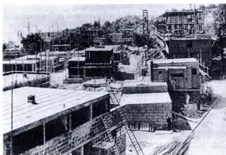
34. Colonia Weissenhof en construcción, 1927.
