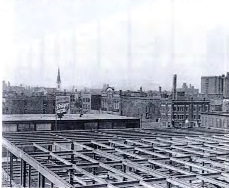
53. Mies van der Rohe. Campus del IIT, estructura del Perlstein Hall en construcción.
