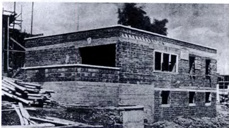
31. Colonia Weissenhof . Vivienda de Hilberseimer en construcción, 1927.
