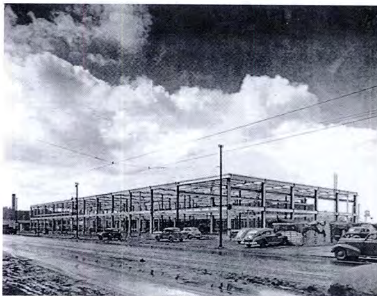
52. Mies van der Rohe. Campus del IIT, estructura del Perlstein Hall en construcción.
