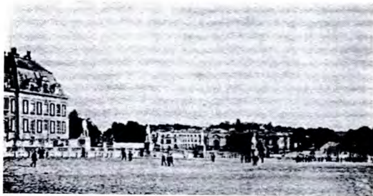
67. Vista del palacio desde la ciudad de Versalles.
