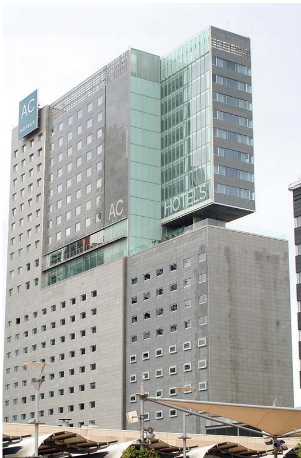
Fig. Ejemplo de fachada trasventilada de piedra colgada del Hotel AC, de Josep Lluís Mateo. (Barcelona, 2004, 88 m. de altura).
