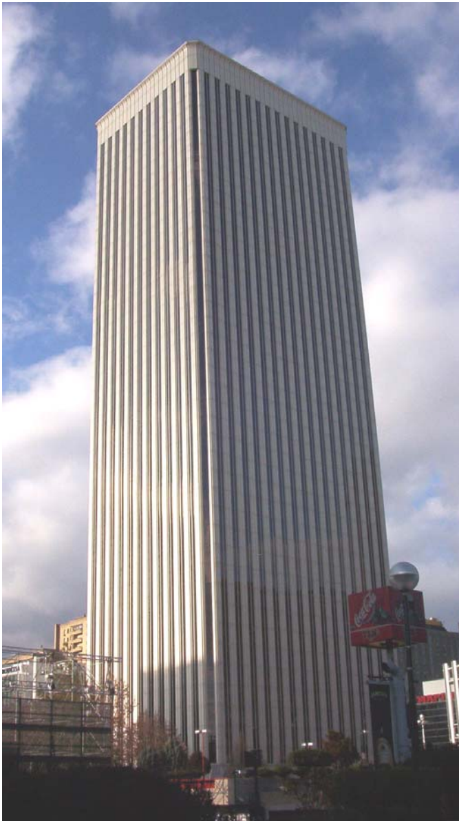
Fig. Fachada combinada con muro cortina de vidrio y paneles sándwich de aluminio en la Torre Picasso, de Minoru Yamasaki. (Madrid, 1988, 157 m. de altura)
