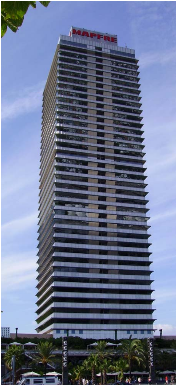
Fig. Ejemplo de muro cortina en la Torre Mapfre, de los arquitectos Ortiz y León. (Barcelona, 1992, 154 m. de altura)
