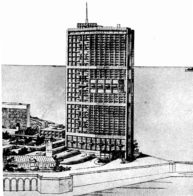
Protecciones exteriores mediante brise-soleils en el rascacielos del barrio de la Marina en Argel. Le Corbusier. 1938-42. Fuente: Boesiger 41 .
