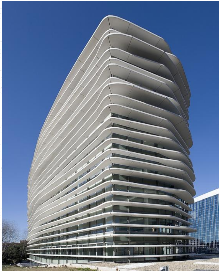
Ejemplo de utilización de iluminación natural con lamas de luz. Edificio de oficinas en Madrid. Junquera Arquitectos, 2007.
