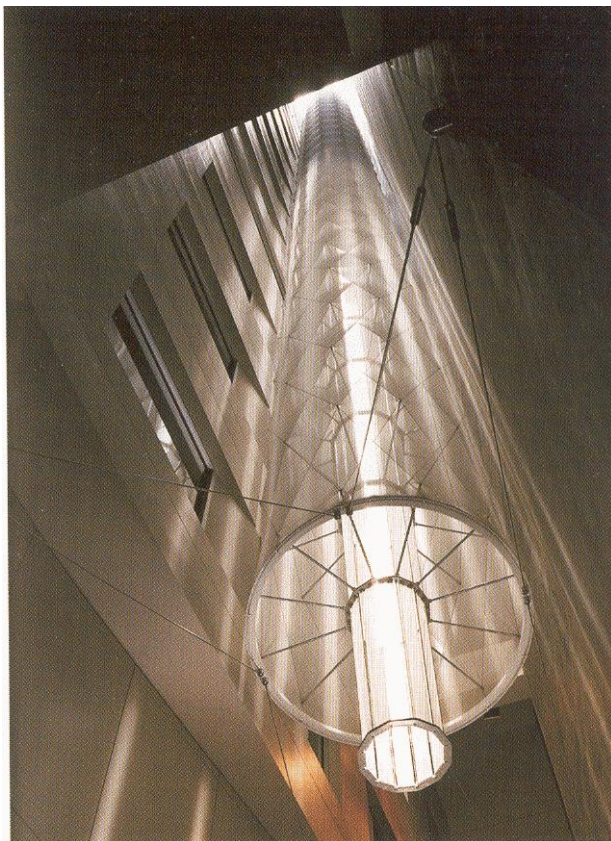
Conducto de luz solar de 36 m. de longitud constituido por una capa difusora exterior de tejido de lycra y núcleo de prismas de vidrio. Un heliostato en cubierta suministra la luz solar.
