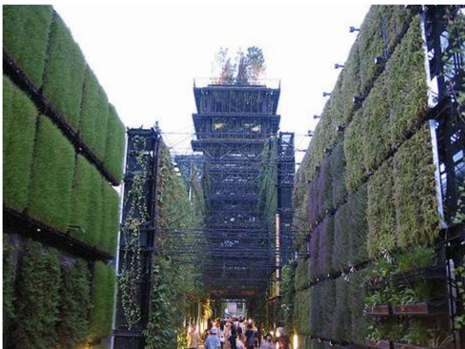
Fachada vegetal con un sistema de contenedores modulares en la exposición Bio-Lung en Aichi, Japón.
