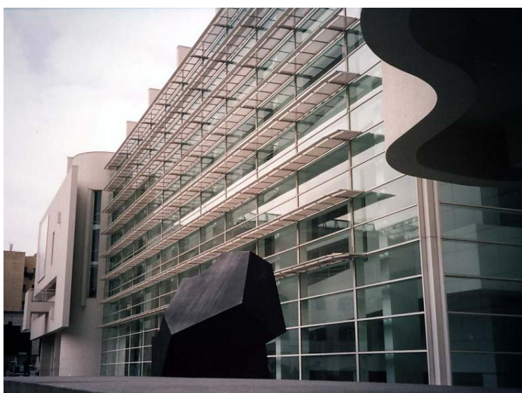
Protecciones solares fijas en el MACBA, Barcelona. Richard Meier y Fernando Ramos.
