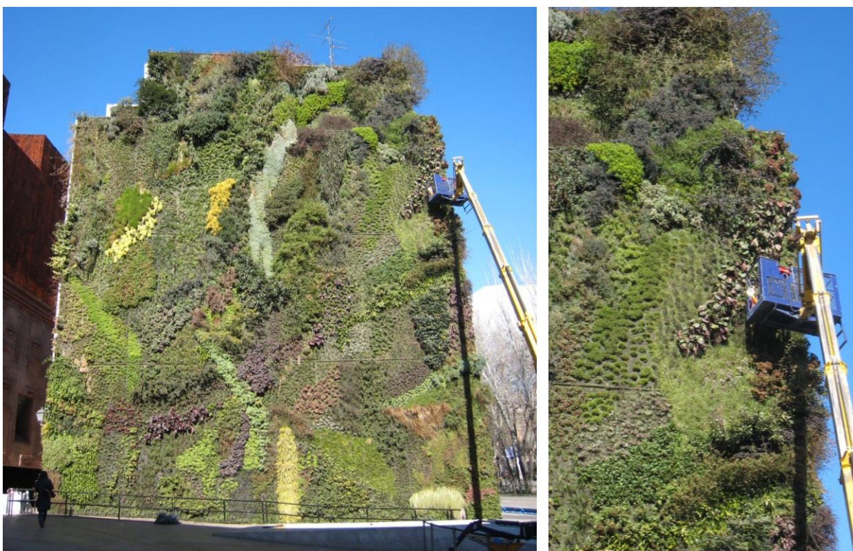
Fachada vegetal con sistema hidropónico en una medianera situada junto al edificio Caixaforum de Madrid, de Herzog & De Meuron. (Foto del autor).
