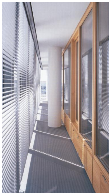
Vista exterior del edificio DMAG (izquierda) y de la cámara de aire entre las dos fachadas (derecha)
