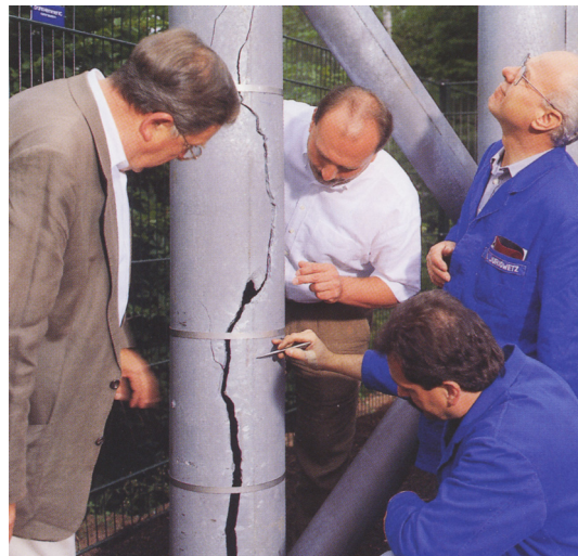
Figura 1.2. Ejemplo de grieta surgida durante la galvanización en una estructura y no detectada hasta la primera inspección rutinaria (imagen facilitada por la Universidad de Kaiserslautern, Alemania) [7].
