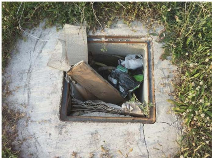
Figura núm. 8-11: Arqueta de alumbrado sin la tapa<sup>19</sup>.
