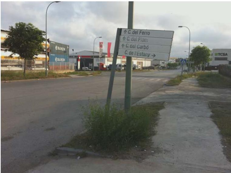
Figura núm. 8-9: Señalización vertical en mal estado<sup>19</sup>.
