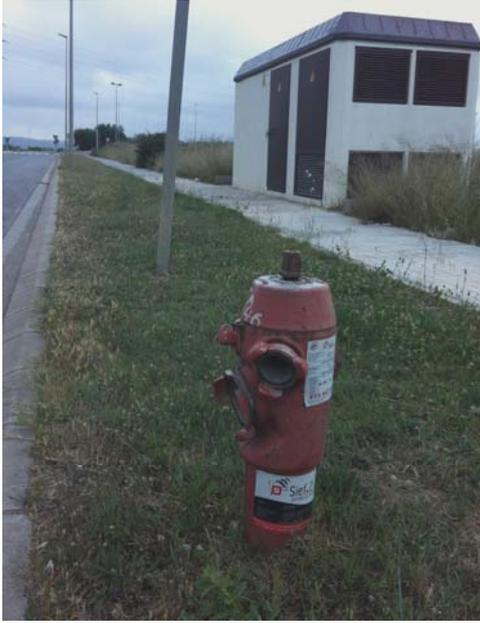
**Figura núm. 8-12:** Hidrante con bocas sin tapa<sup>20</sup>.
