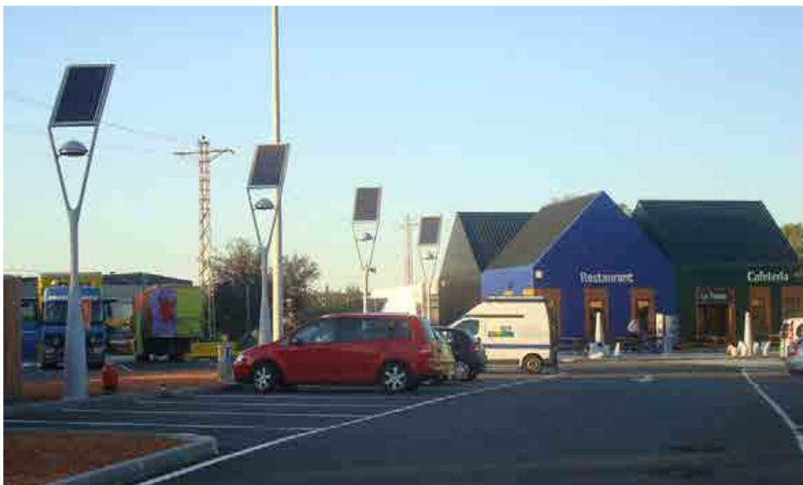
**Figura núm. 6-11:** Proyecto diseñado por SIARC, con instalación de farolas fotovoltaicas, de 30 leds de alta potencia cada una, en el área de Servicio La Pausa de Montcada i Reixach, Barcelona. Aportan un ahorro energético de 255,5 kWh/año.
