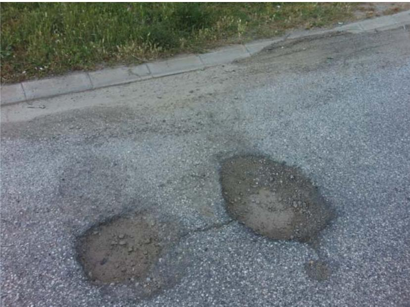
**Figura núm. 8-18:** Pavimento hundido y con baches<sup>21</sup>.
