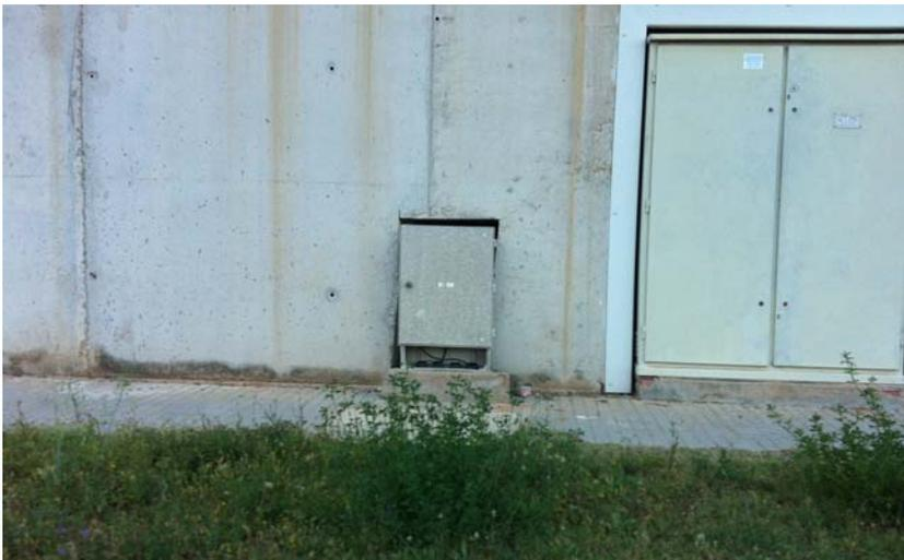
**Figura núm. 8-15:** Armario de distribución de telecomunicaciones sin tapa en zócalo<sup>20</sup>.
