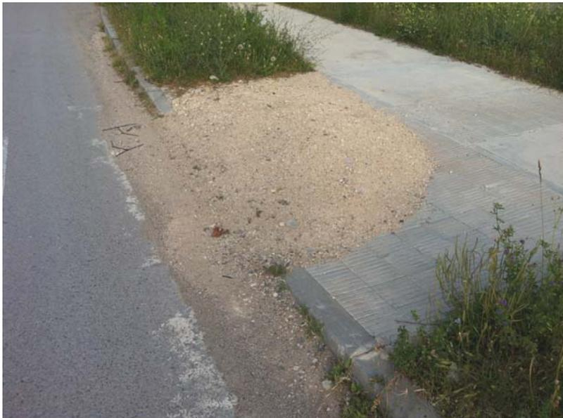
*Figura núm. 8-5: Arenas arrastradas por el efecto de la lluvia, en un paso de peatones<sup>17</sup>.*
