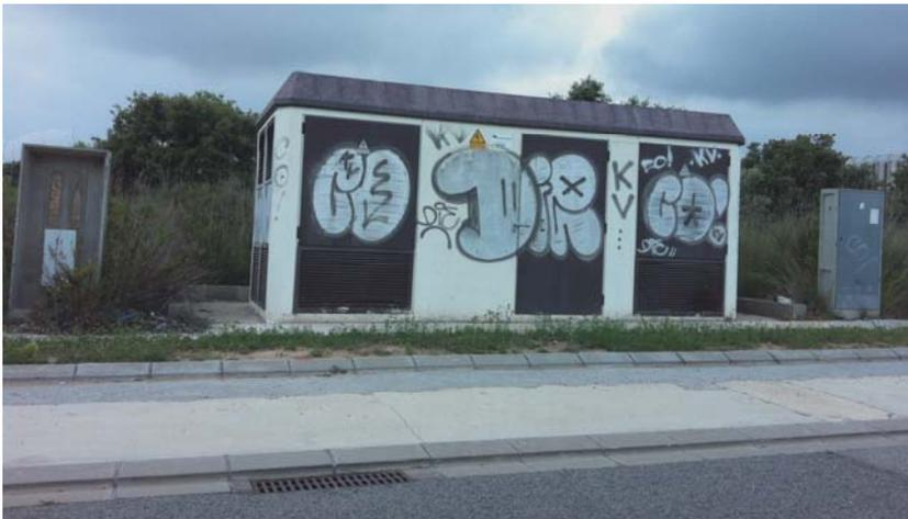
**Figura núm. 8-14:** Grafitis en estación transformadora y armario de distribución eléctrica sin puerta<sup>20</sup>.
