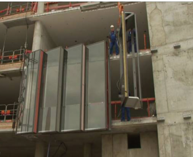
Fig.D3.30- Colocación de un componente en fachada
