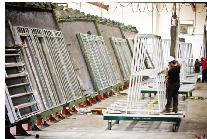
Fig.6.17. Bastidores preparados para fijar sobre la mesa de hormigonado. Empresa Ecoliteconcrete
