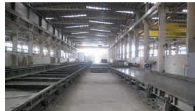
Fig.2.31. Instalación para producción manual en mesas continuas de la empresa Precon
