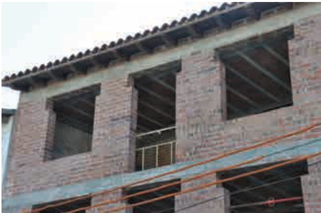
Fig.4.9. Una vez realizados los huecos se tomaran las dimensiones exactas para la conformación de las carpinterías
