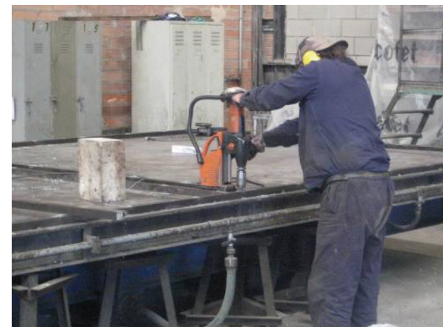
Fig.D4.8. Perforación del perfil perimetral y de la mesa para fijaciones las mecánicas. Empresa Escofet
