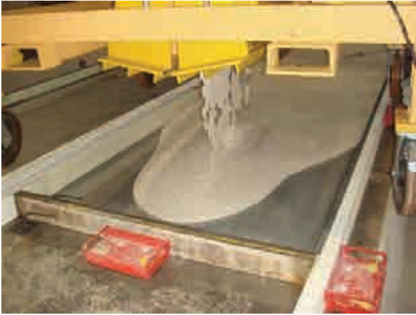
Fig.2.7. Técnica de vertido de hormigón sobre molde horizontal.
