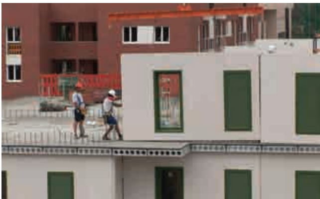
Fig.3.30. Montaje de un panel 'ligero' sobre las placas alveolares. 54 viviendas en Albacete
