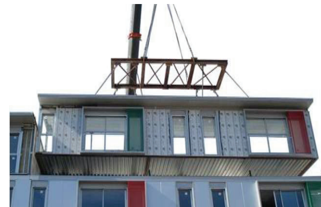
Fig.1.26. Módulo tridimensional fabricado por Modultec para un conjunto de viviendas en Torelló. TAC Arquitectes.
