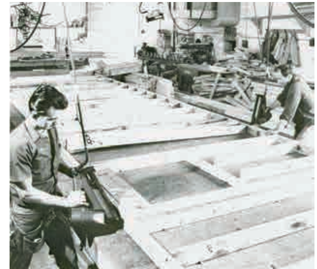
Fig.4.2. Fabricación de bastidores de madera. SENDECO Products, Inc.
