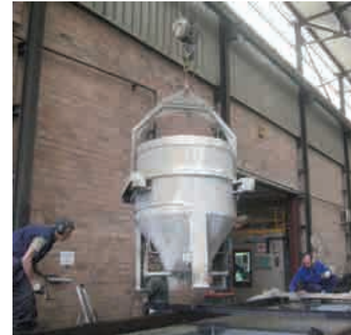
Fig.D1.21. Vertido del hormigón mediante cubilote. Empresa Escofet
