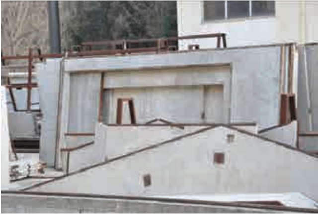
Fig.3.62. Acopio de paneles conformados mediante perfiles laminados como molde perdido en las instalaciones de Tagamanen.
