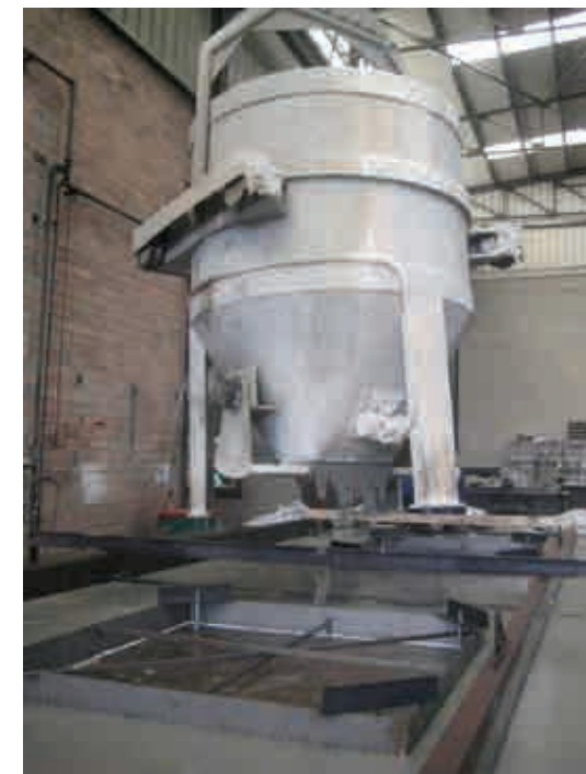
Fig.D4.12. Vertido del hormigón sobre el molde mediante cubilote móvil
