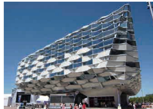
Fig.3.41b. Paneles de GRC Aluminium en la fachada del Pabellón de Aragón. Exposición Zaragoza 2008
