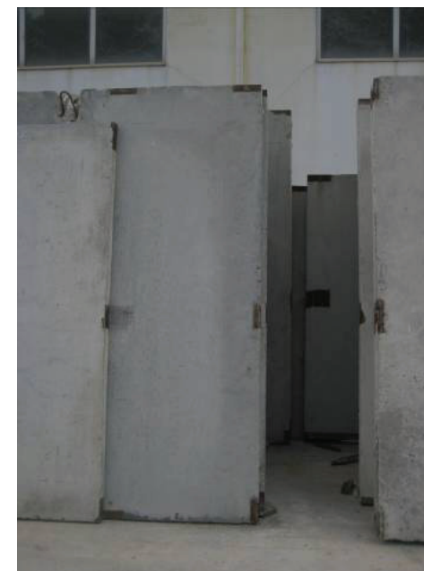
Fig.3.61. Tramos de perfiles UPN de 10cm situados cada 150cm
