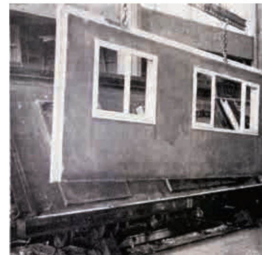
Fig.3.5. Paneles finalizados de hormigón con la ventana incorporada. Sistema de prefabricación Coignet. Anterior a 1960 Francia
