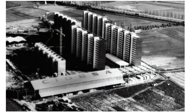
Fig.3.11. Instalación de nave de CIDESA para la fabricación a pie de obra de los elementos prefabricados de hormigón (1968)
