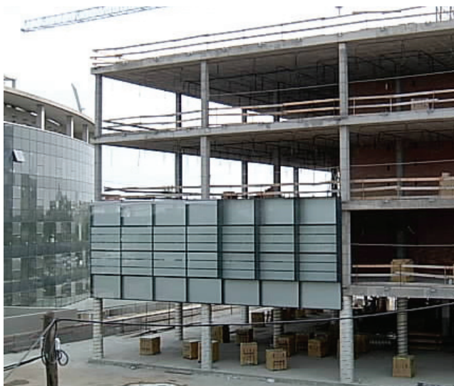
Fig.D3.9- Módulos de fachada con subdivisión de tres perfiles intermedios. Sede MRW Barcelona. Empresa Technocladd
