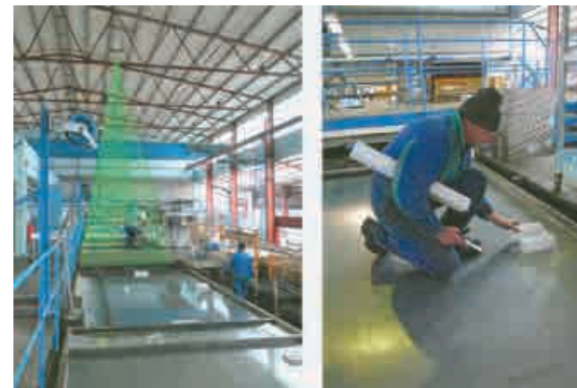
Fig.D4.4.Replanteo manual con ayuda laser para el posicionamiento
