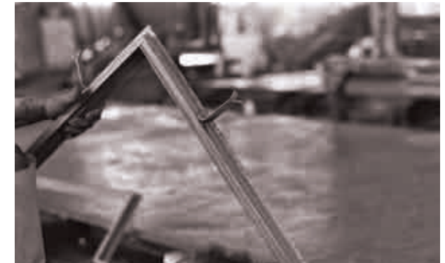
Fig.3.12. Marco de carpintería con flejes preparado para utilizarlo como parte del molde perimetral interior (1969)
