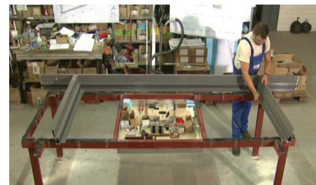
Fig.D3.19- Montaje de perfiles intermedios del módulo
