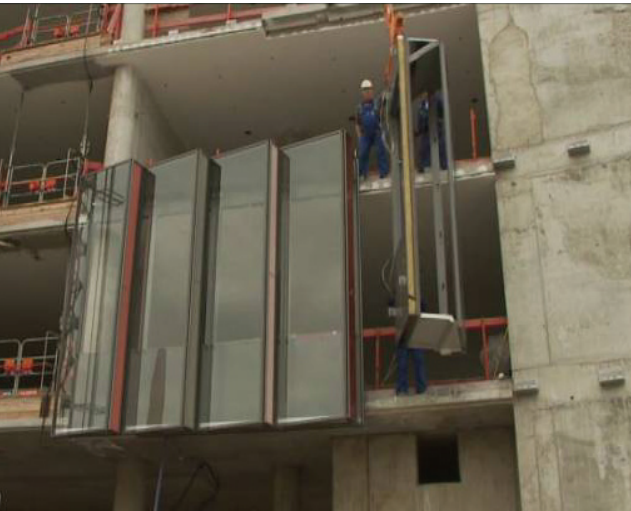
Fig.D3.30- Colocación de un componente en fachada
