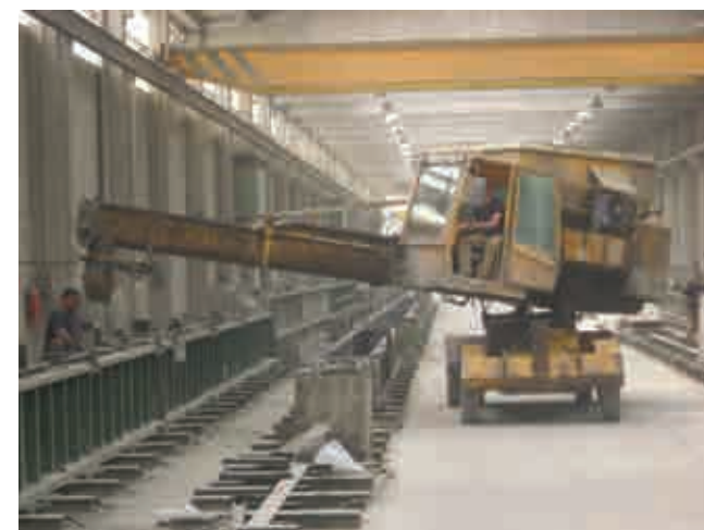
Fig.D1.22. Vertido del hormigón mediante tornillo sinfín. Empresa Tecnyconta
