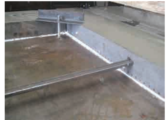
Fig.D1.14. Arriba: espuma adhesiva colocada entre perfiles y la mesa de hormigonado.
