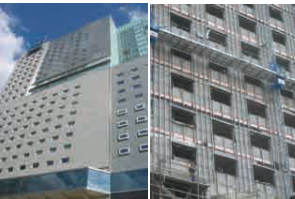
Fig.1.30. Montaje de la fachada del Hotel AC de Barcelona basada en los semiproductos . MAP Arquitectos
