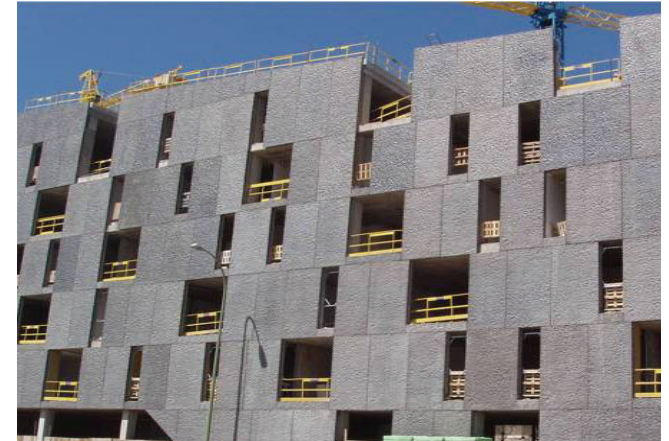
Fig.1.36a. Edificio Inakasa, Las Palmas de Gran Canaria. Arq: Alexis Lopez Acosta
