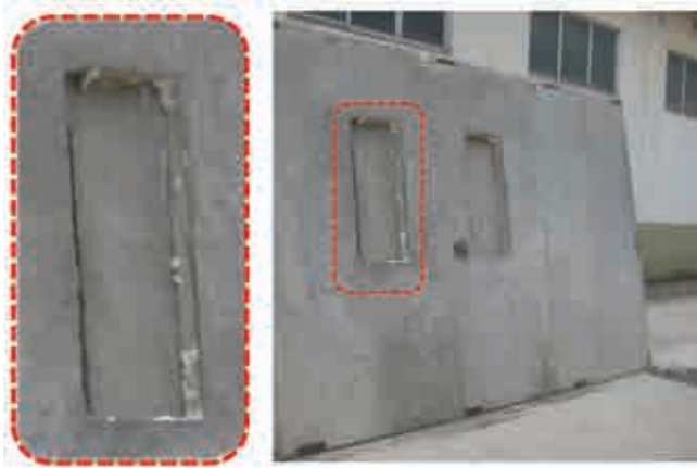
Fig.3.55. Huecos desarrollados con moldes de EPS
