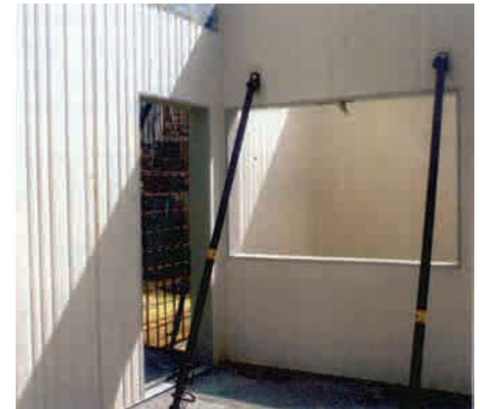
Fig.3.32. Premarcos de los huecos montados en obra. 54 viviendas en Albacete. Arquitectura Vertida.
