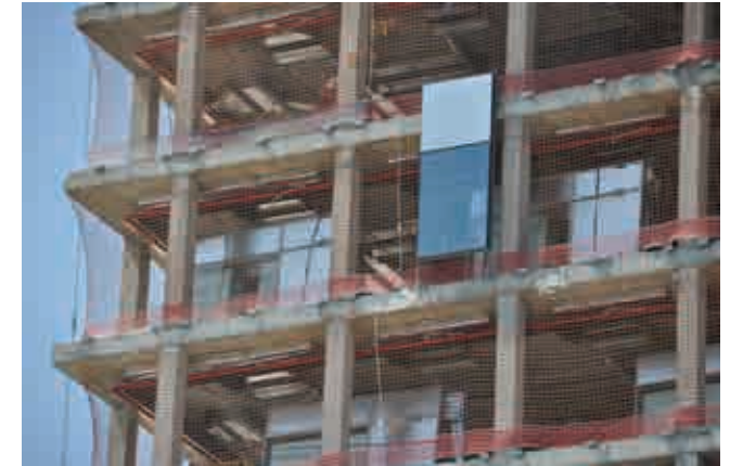
Fig.D3.31- Acopio en planta de los componentes Unitized. Porta Firal de Barcelona. Arq.Oscar Tusquets 2012
