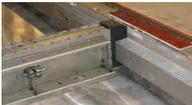
Fig.D1.11. Cabezas especiales de perfiles para resolución de esquina de la empresa Weckenmann
