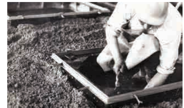
Fig.3.13. Fijación del marco de la ventana al molde perimetral interior (1969)
