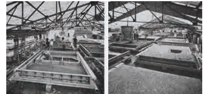
Fig.2.1. Conformación de paneles sobre mesas individuales.
