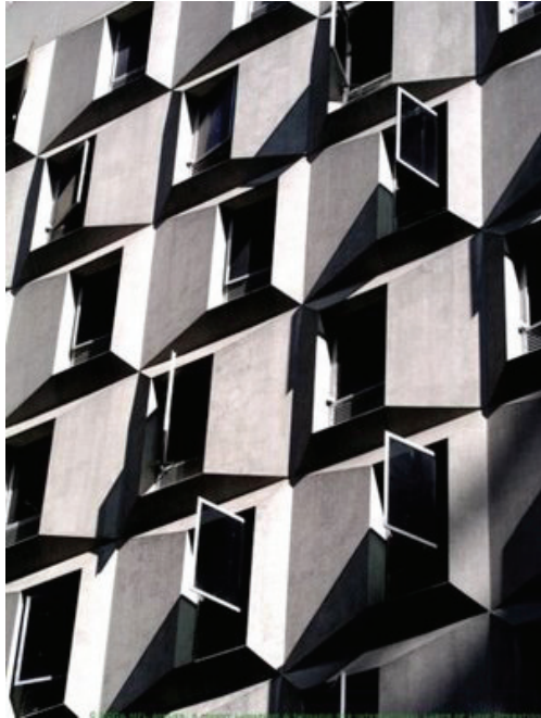
Fig.2.37. Componentes tridimensionales. Edificio en West 55th av. New York
