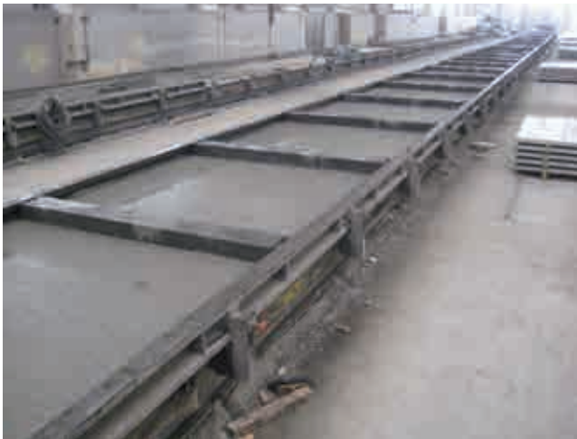
Fig.1.47. Instalaciones de la empresa Precon en Cervera. Lleida.
