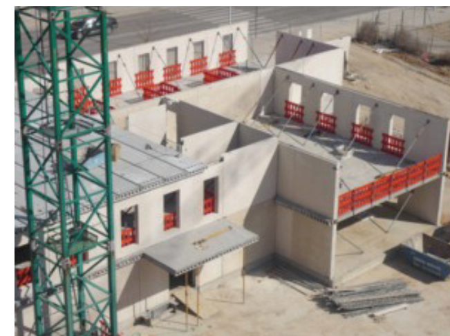
Fig.3.28. Proceso de construcción del sistema 'Arquitectura Vertida'. 54 viviendas en Albacete
