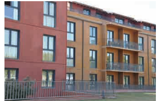
Fig.3.50. Edificio construido con el sistema Leiro. Hotel 'El Muntanyà'. Seva (Barcelona)
