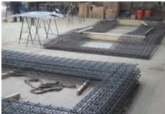
Fig.D1.19. Conformación del armado del panel
