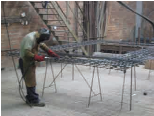
Fig.D4.11. Conformación manual del armado del panel
