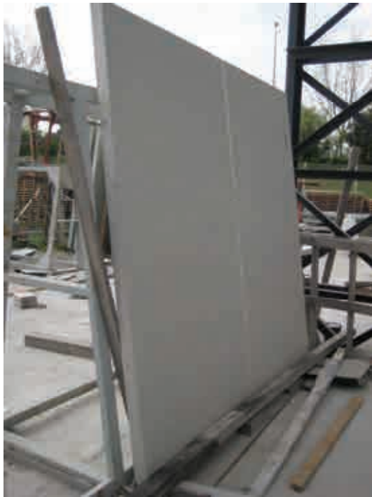
Fig.D4.14. Desmontaje de tres de los molde perimetrales para permitir el desmoldeo del panel de hormigón
