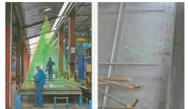
Fig.2.19. Sistema de replanteo mediante proyección laser
