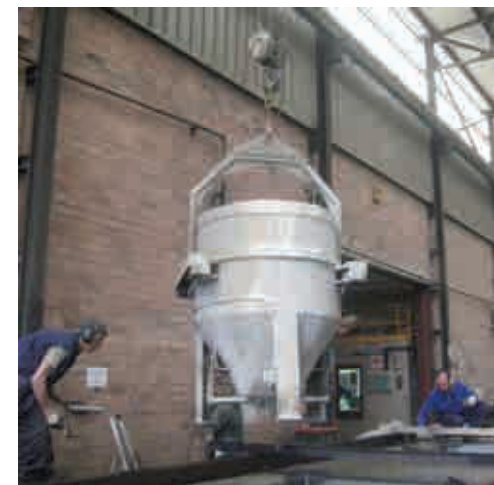
Fig.D1.21. Vertido del hormigón mediante cubilote. Empresa Escofet
