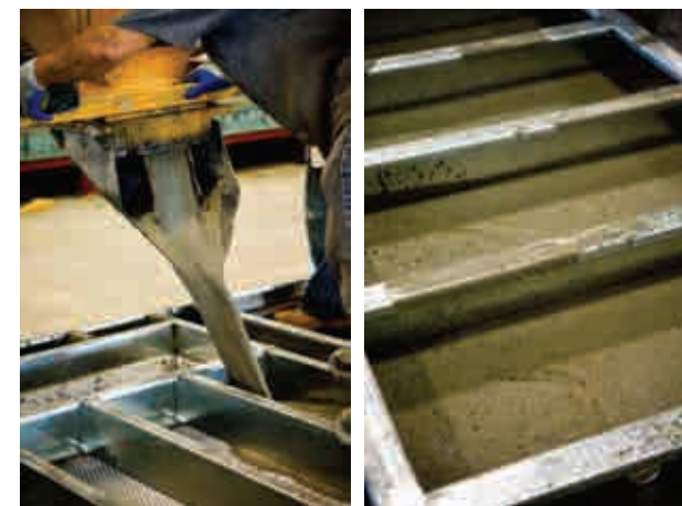
Fig.3.45. Operaciones de vertido del hormigón aireado entre los perfiles plegados del bastidor de acero galvanizado
