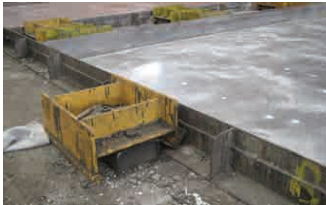
Fig.D1.15- Fijación de tabicas laterales con imanes
