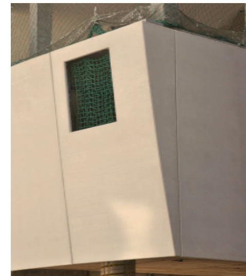
Fig.1.19. Componente tridimensional de GRC. Viviendas Torre Baró. Arq. J. MIAS
