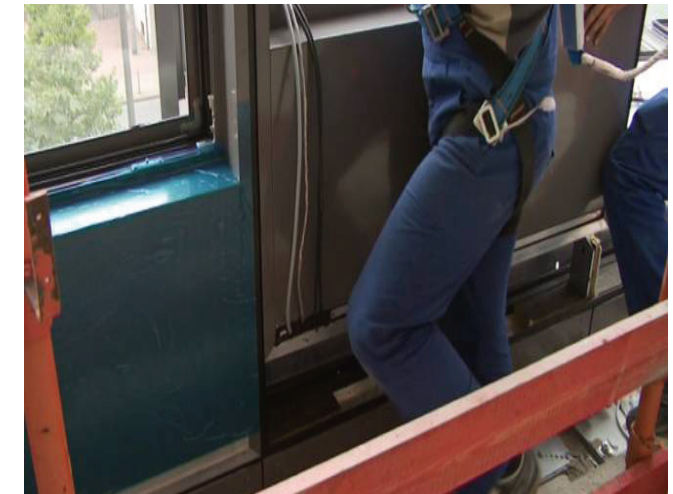
Fig.D3.32- Movimiento vertical de ensamble entre componentes previo engrasado de gomas
