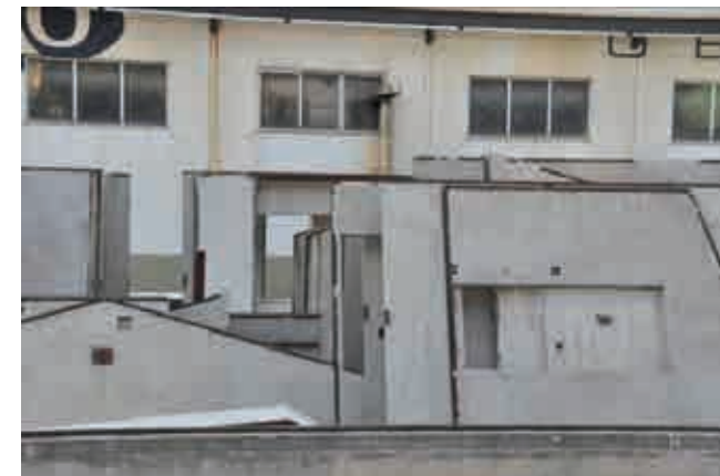
Fig.3.60. Acopio de paneles conformados mediante perfiles laminados como molde perdido en las instalaciones de Tagamanen.
