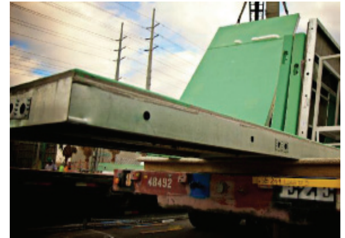
Fig.3.49. Panel finalizado donde se observa con claridad parte de la capa de hormigón sobresaliendo del perfil perimetral
