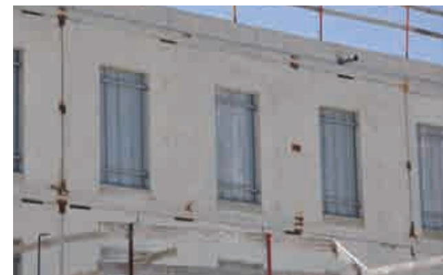
Fig.3.58. Paneles con tramos de perfil UPN estratégicamente colocados en las zonas de conexión entre paneles. Viviendas en Vilanova del Vallès (2012)
