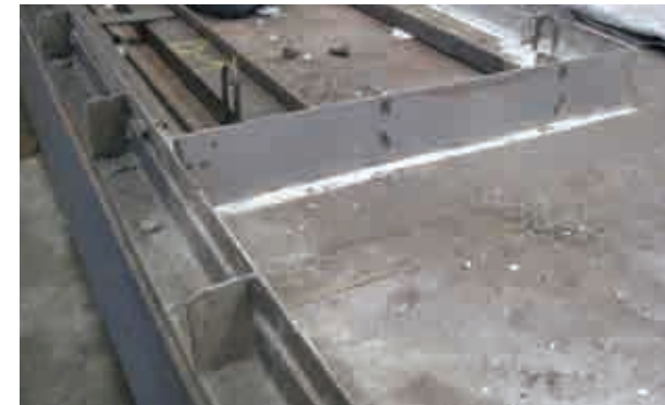
Fig.2.9. Conformación de moldes perimetrales de forma artesanal
