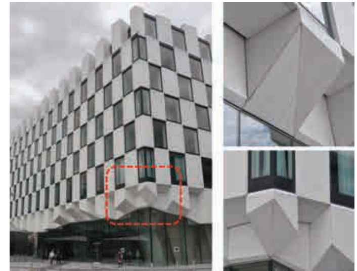
Fig.1.18. La repetición de componentes como estrategia para la composición. Conformación de geometrías tridimensionales con componentes planos en los puntos singulares. Estudio Aires Mateus. Dublin
