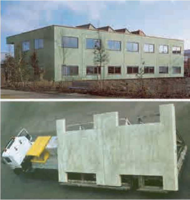
Fig.1.34. Panel sándwich para una Agencia de publicidad en Reim. Arq. Amann & Gittel Architekten (Munich)
