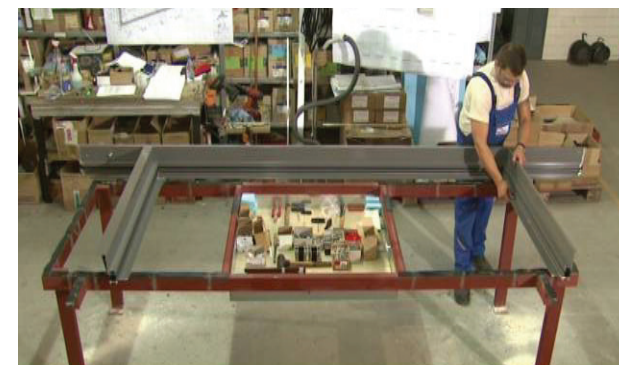
Fig.D3.19- Montaje de perfiles intermedios del módulo
