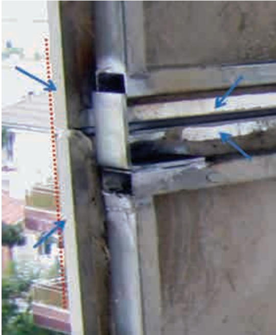
Fig.3.40. Perfil de aluminio en los paneles de GRC desarrollados con el sistema GRC Aluminium.
