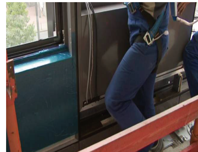
Fig.D3.32- Movimiento vertical de ensamble entre componentes previo engrasado de gomas
