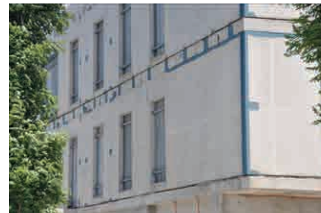
Fig.3.57. Perfil continuo en las esquinas para facilitar la estabilización del edificio. Viviendas en Vilanova del Vallès (2012)
