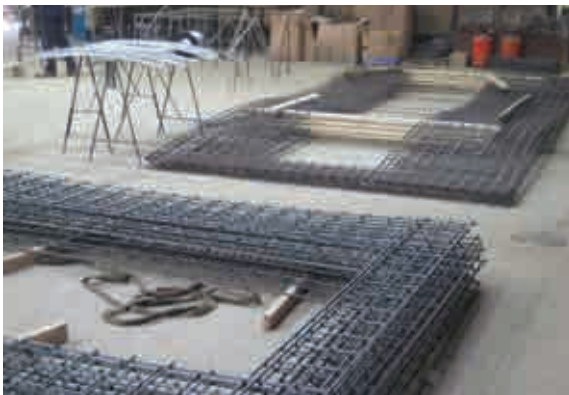
Fig.D1.19. Conformación del armado del panel
