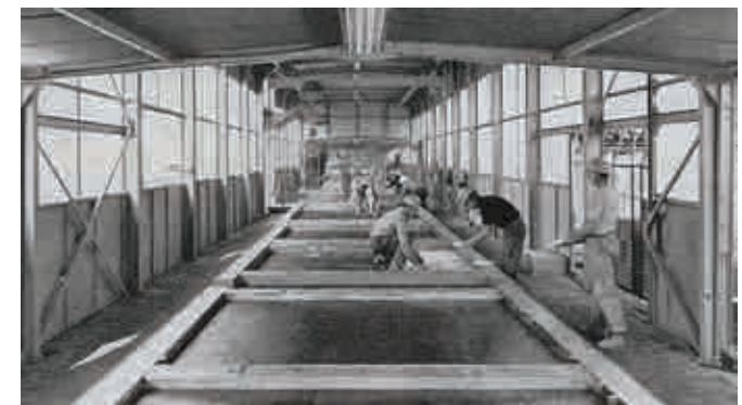
Fig.2.2. Conformación de paneles sobre mesas continuas.
