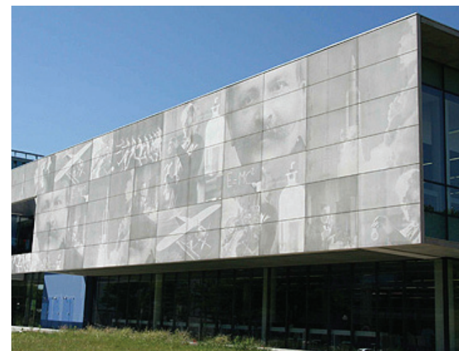
Fig.2.35. Paneles de fachada desarrollados por la empresa Reckli con el sistema 'RECKLI-Formliners'
