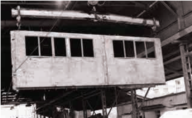
Fig.3.14. Panel de fachada prefabricado con las las ventanas ya montadas (1969)
