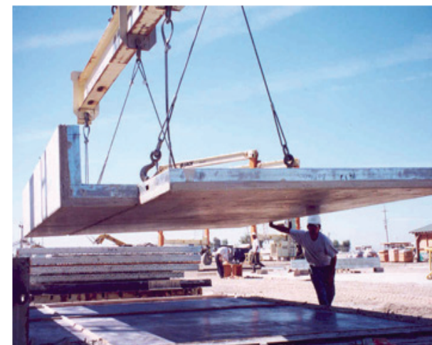
Fig.3.23. Manipulación del panel a través del bastidor de acero. Se observa en el canto del panel la presencia de los perfiles y del hormigón
