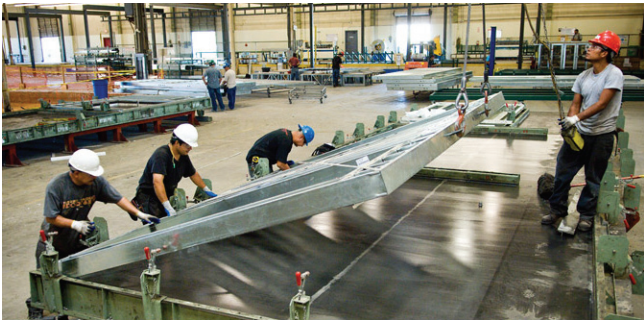
Fig.6.16. Montaje de un bastidor de fachada sobre mesa de hormigonado. Empresa Ecoliteconcrete
