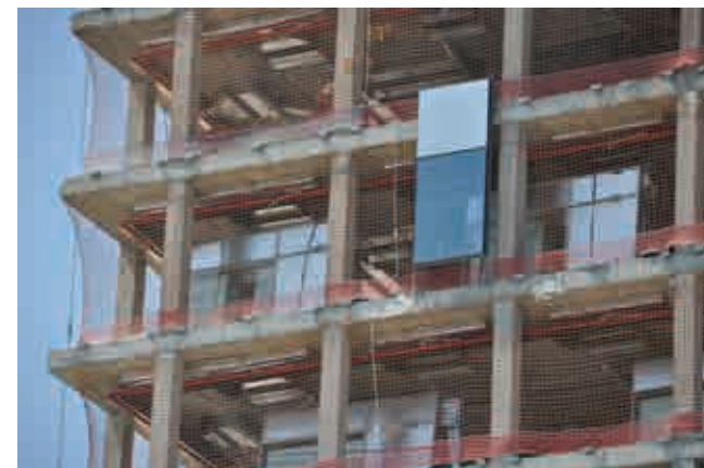
Fig.D3.31- Acopio en planta de los componentes Unitized. Porta Firal de Barcelona. Arq.Oscar Tusquets 2012
