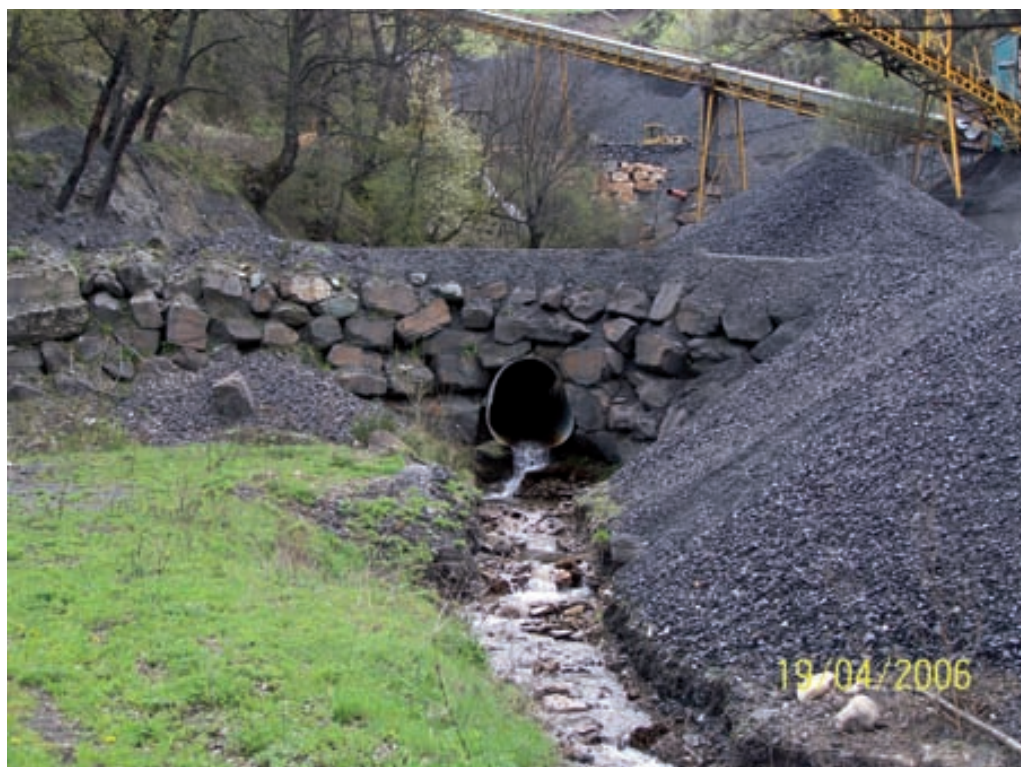
Imagen 12: Escombrera del lavadero de carbón de Villablino
