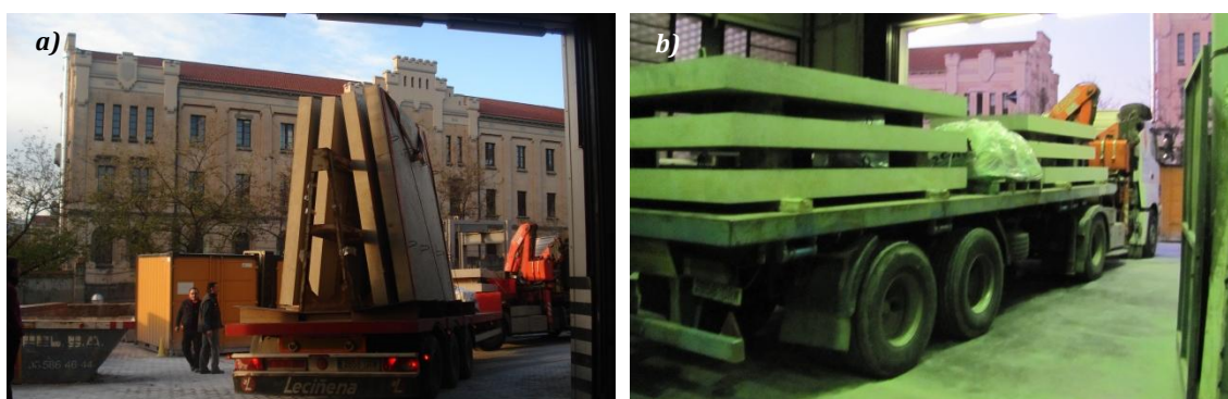
Figura 4.6 – Transporte de las losas de HRF a) viaje 1 y b) viaje 2
