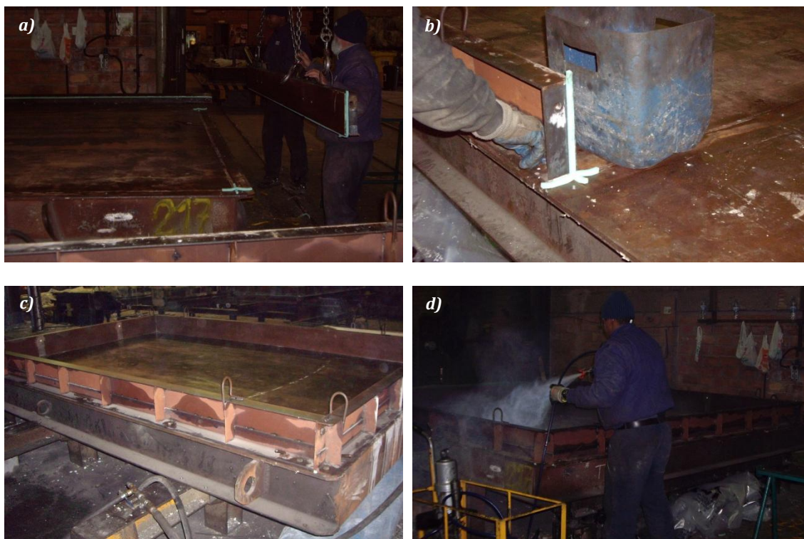
Figura 4.4 – a) Montaje de encofrado; b) detalle espuma para sellar las juntas; c) encofrado losas de 3x3x0,2 m y d) aplicación de producto desencofrante.
