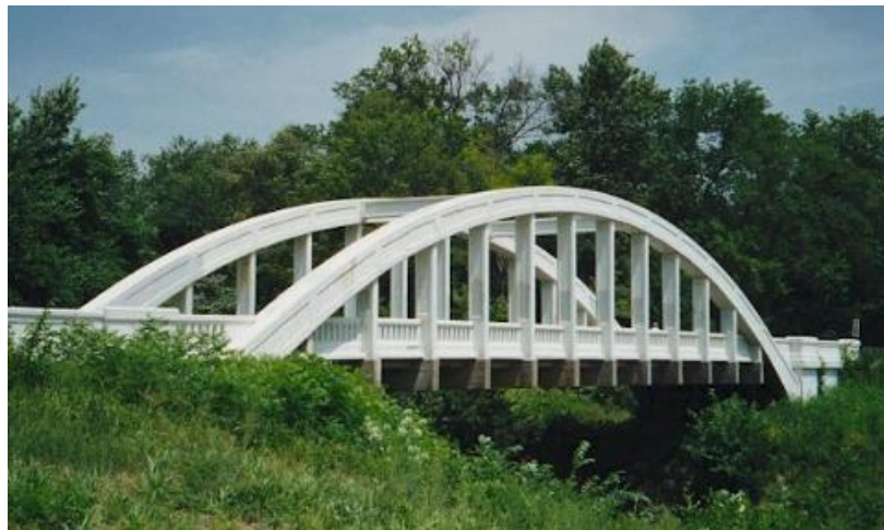
Fig. 5.4 Puentes arco (de tablero intermedio)
