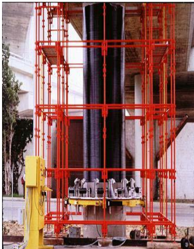
Fig. 2.11 Bobinado automático de fibra de carbono
