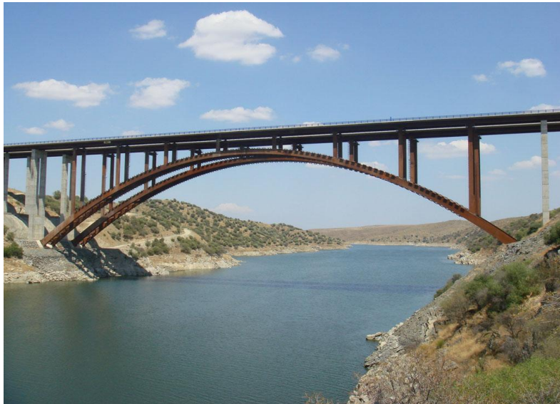
Fig. 5.3 Puentes arco (de tablero superior)
