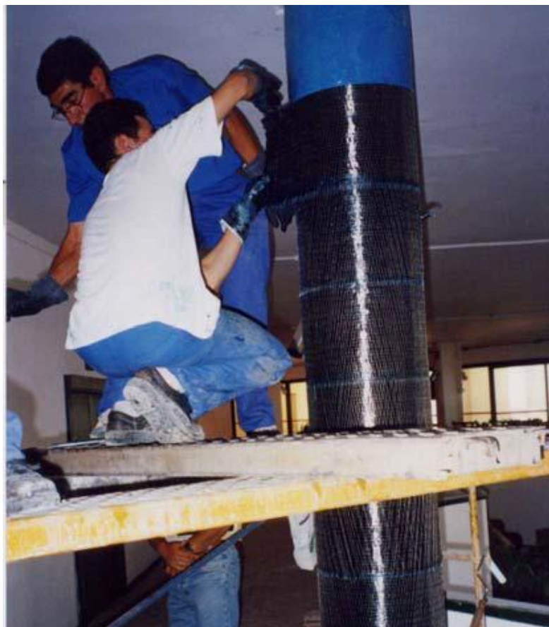
Fig. 2.10 Aplicación de fibra de carbono mediante wrapping
