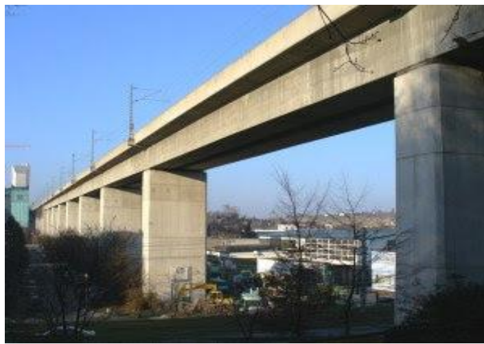
Fig. 5.1. Puentes viga
