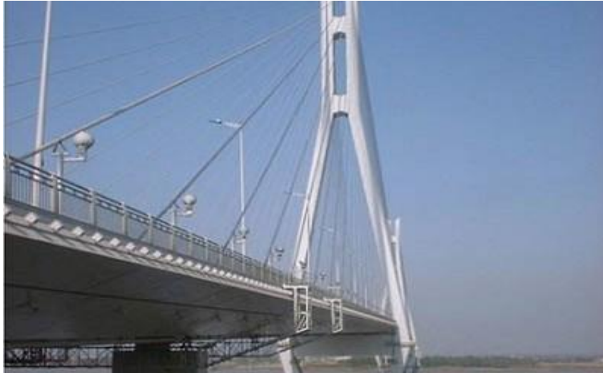
Fig. 5.5 Puente atirantado
