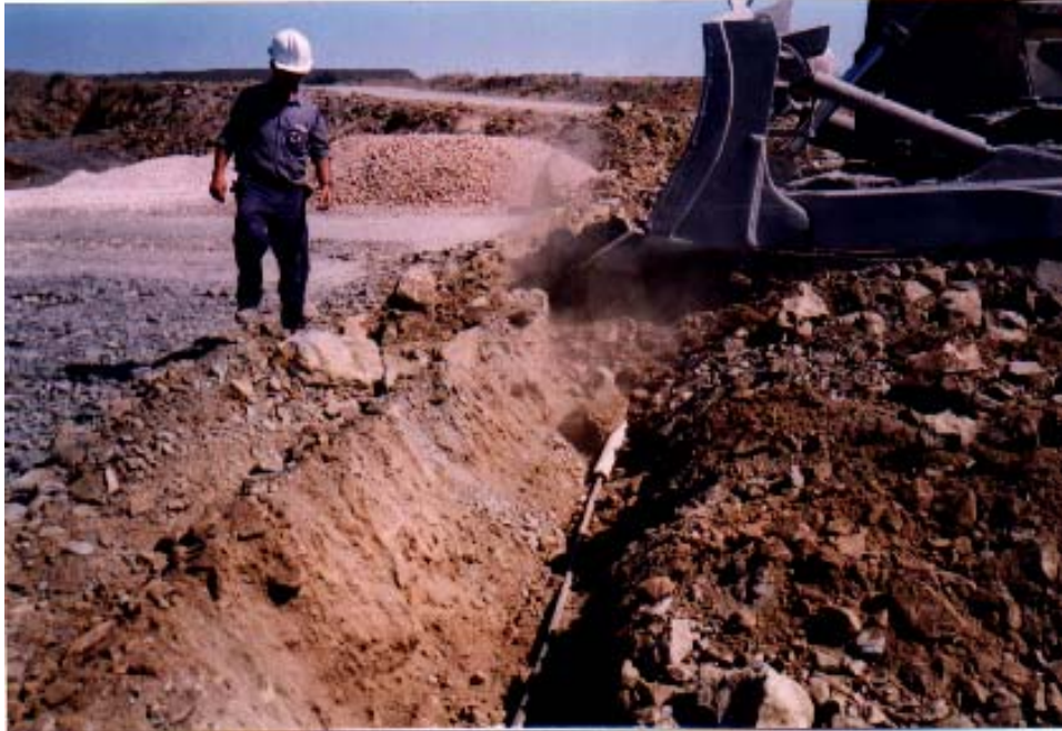
Foto 2.1.2.1.a: Colocación de tubería para conducción de agua de corta hasta el Sistema
