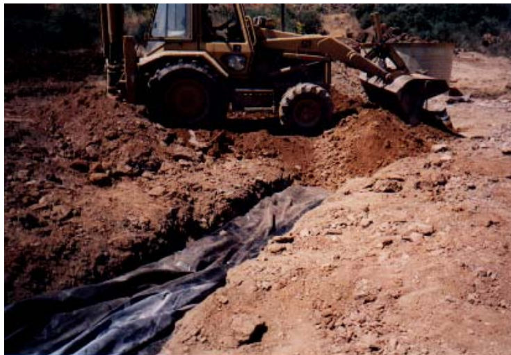
Foto 2.1.2.1.k: ALD en el momento de ser recubierto
