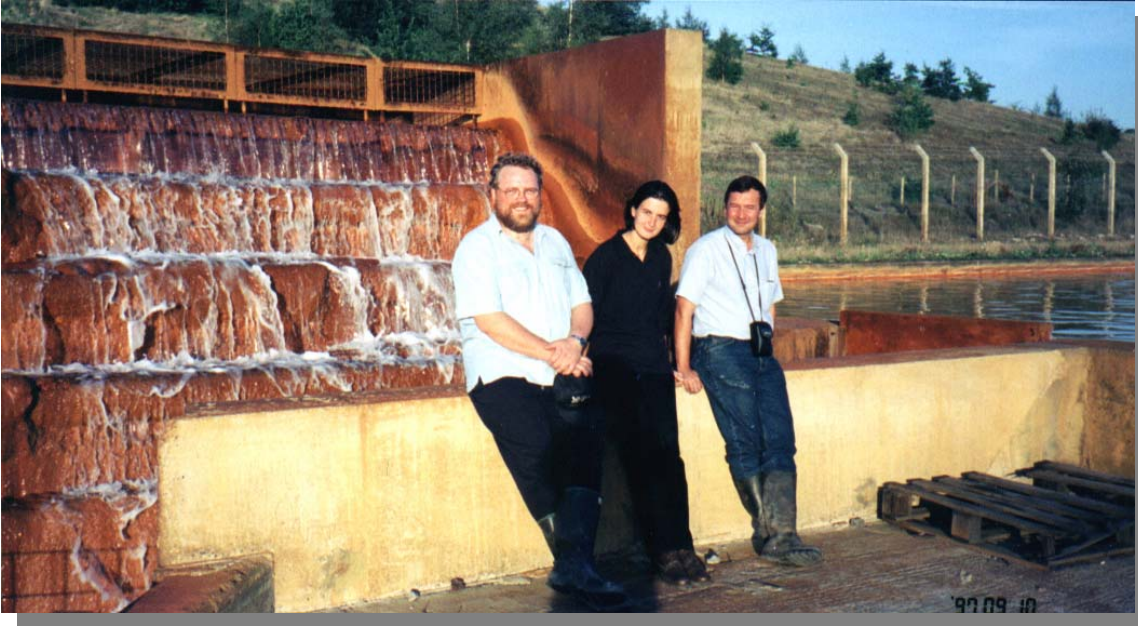
Foto 1.1.3.1.3.c: Paul Younger, Bob Hedin y la autora junto al sistema de cascada de aireación en Woolley. Se aprecian acumulaciones sólidas de “ocre”.
