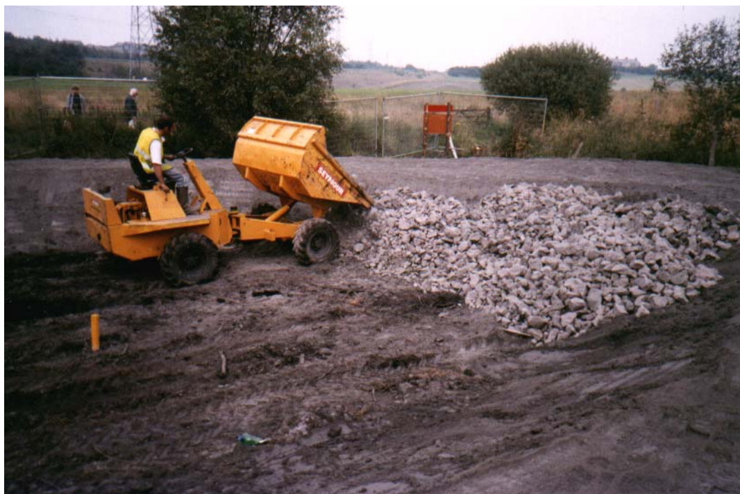
Foto 1.2.2.b: Construcción del humedal. Se aprecia el dique perimetral de ceniza volante y el relleno de caliza en la salida de la segunda celda.
