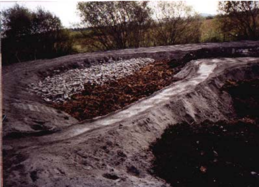
Foto 1.2.2.c: Construcción del humedal. Se aprecian los diques y una isla de ceniza volante. También se puede ver el relleno de compost y estiércol de las balsas.
