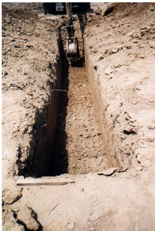
Foto 2.1.2.1.h: Sistema ALD: Construcción del canal
