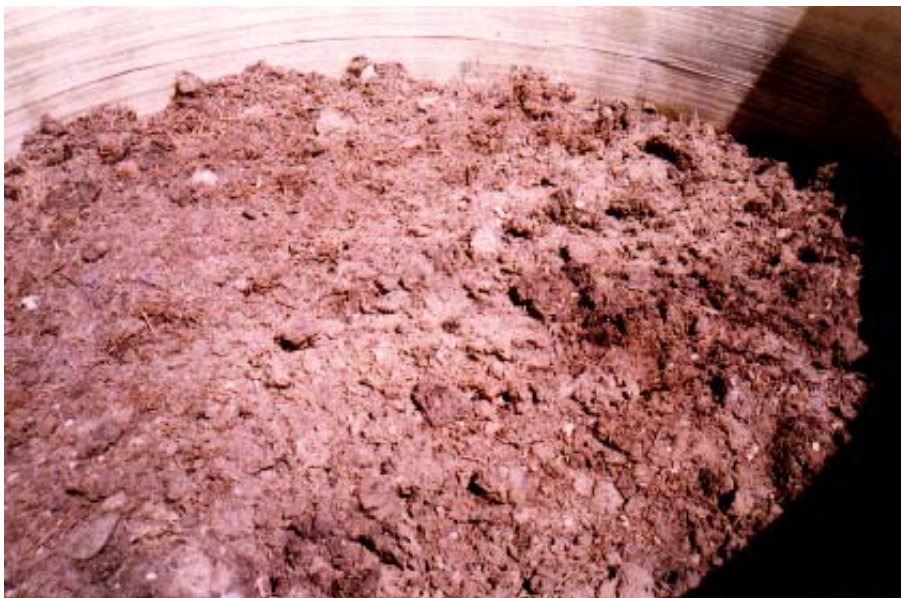
Foto 2.1.2.1.f: Relleno de la capa de sustrato orgánico en el interior del sistema SAPS
