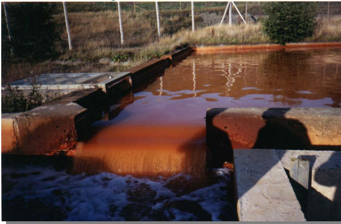
Foto 1.1.3.1.3.a : Descarga ferruginosa a la salida de una balsa de sedimentación en Woolley (Yorkshire)
