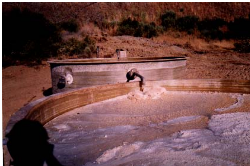
Foto 2.1.2.1.g: Funcionamiento de los sistemas SAPS. Se aprecian espumas de Al en el segundo de ellos
