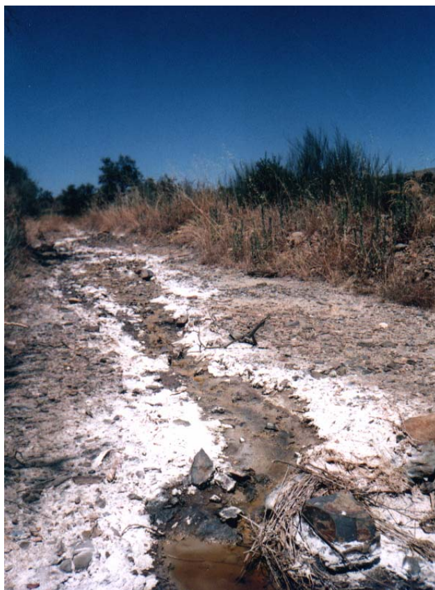
Foto 2.1.1.1.e :Efluente ferruginoso del Sistema 1. Se aprecian eflorescencias de sulfatos en las zonas laterales
