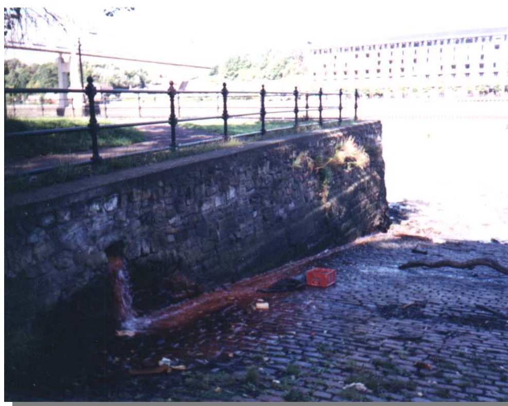
Foto 1.1.3.1.4.2: Descarga de agua de mina al río Tyne en Gateshead (Newcastle)
