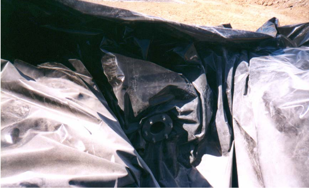
Foto 2.1.2.1.m: Tubería abocardada del efluente
