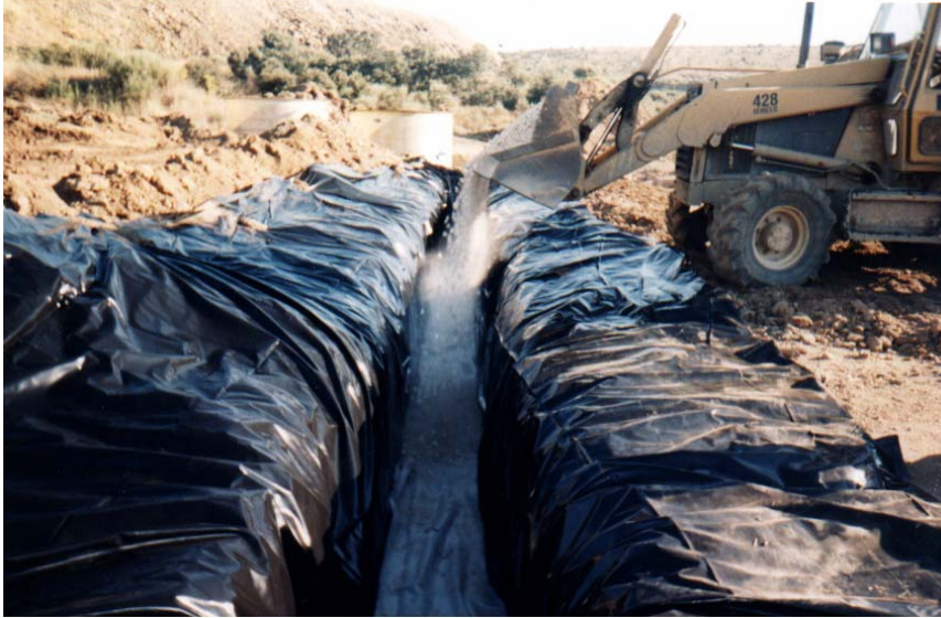
Foto 2.1.2.1.i: Recubierto el canal con una lámina de polietileno, se rellena de grava caliza. El fondo se protege con una lámina de geotextil
