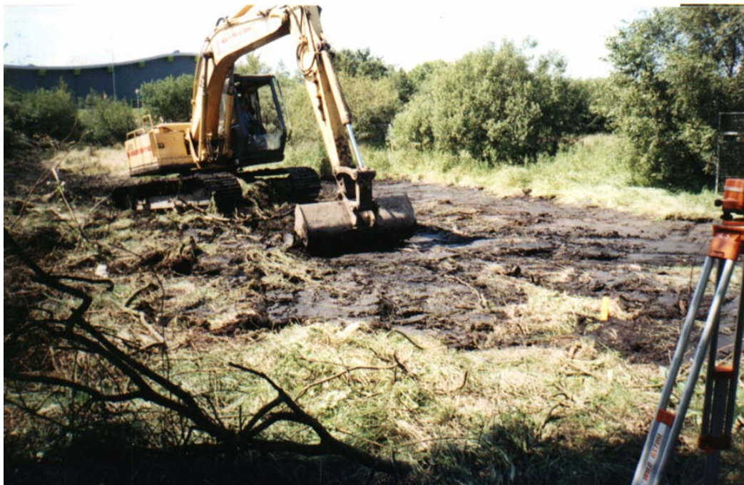
Foto 1.2.2.a: Retirada de los árboles para despejar la zona de ubicación del humedal
