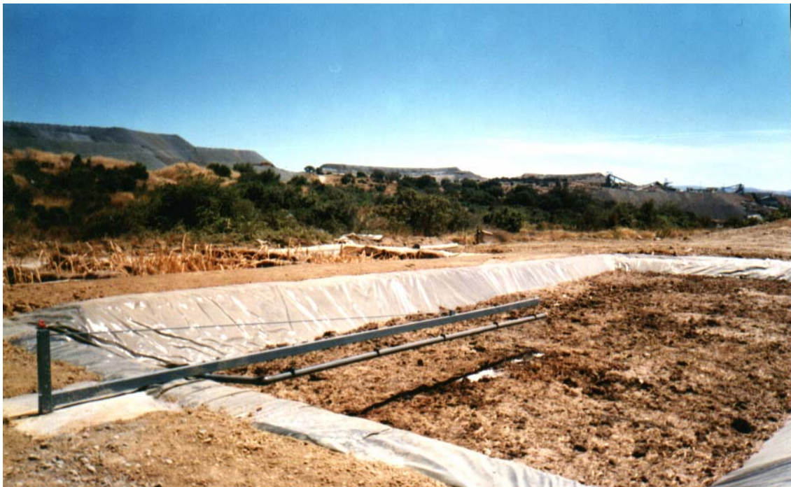
Foto 2.1.2.1.p: Relleno de sustrato orgánico (estiércol de vaca + paja + arena) en el interior de la balsa. Inundación del humedal mediante un dispositivo para la distribución de agua en dirección longitudinal.
