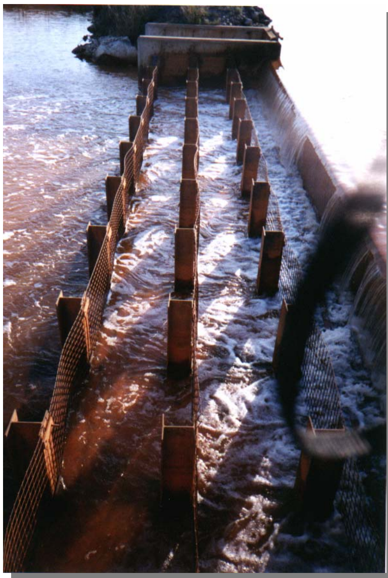
Foto 1.1.3.1.3.e :Equipamiento de filtros para retención de sólidos en suspensión del agua de mina de Wolley (Yorkshire)
