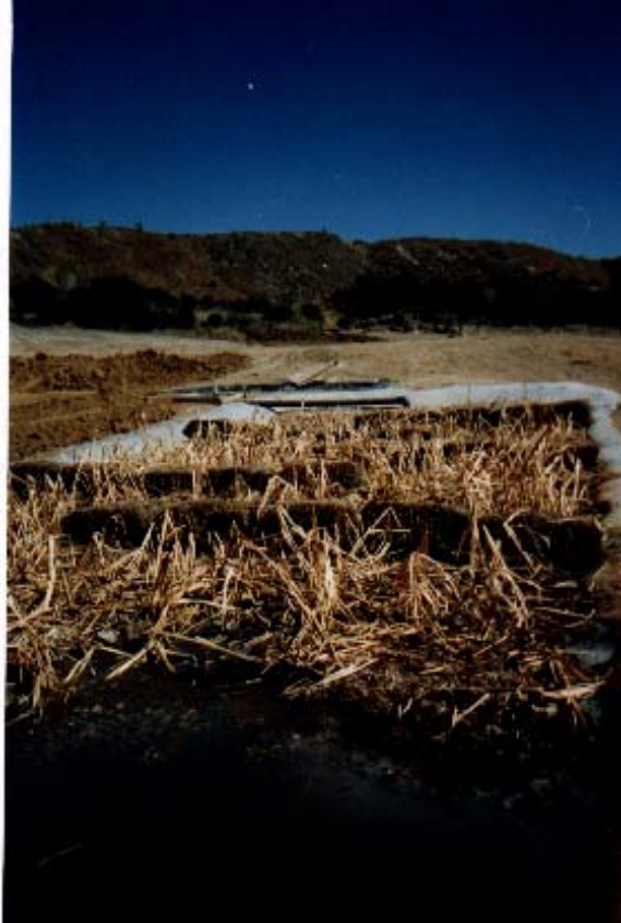
Foto 2.1.1.1.c: Vista del humedal del Sistema 1
