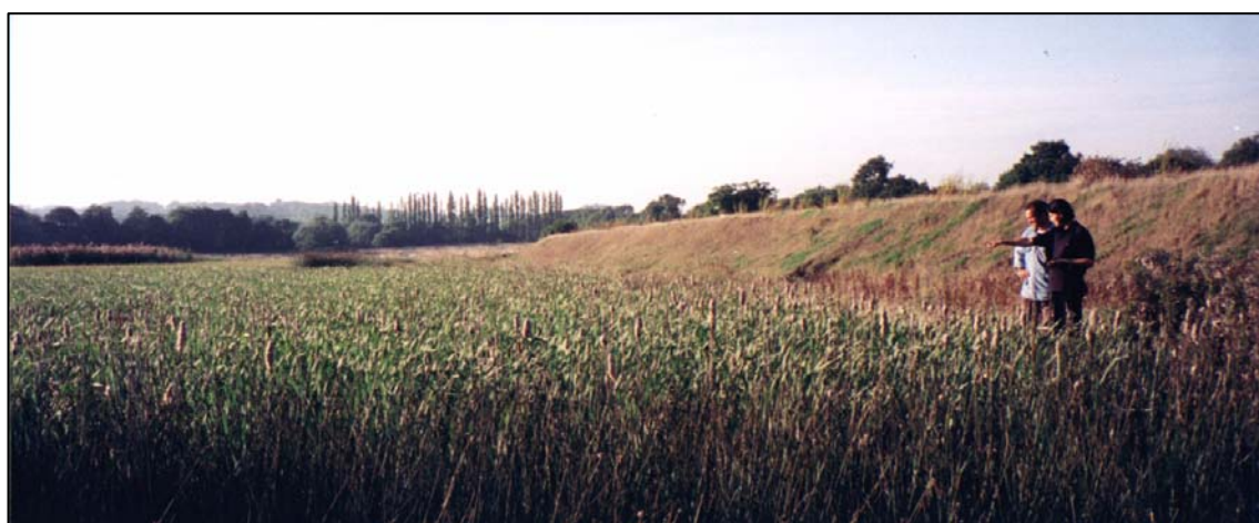
Foto 3.2.2.2.a: Humedal construido para agua de mina en Woolley, Yorkshire (Inglaterra)
