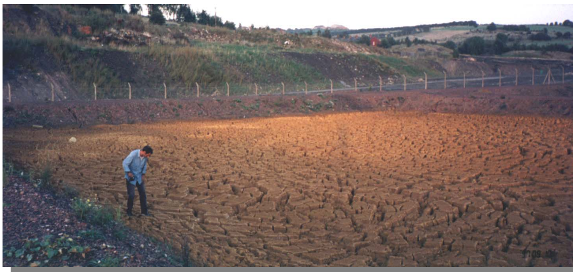
Foto 1.1.3.1.3.b: Depósitos de “ocre” en una balsa de sedimentación en Woolley
