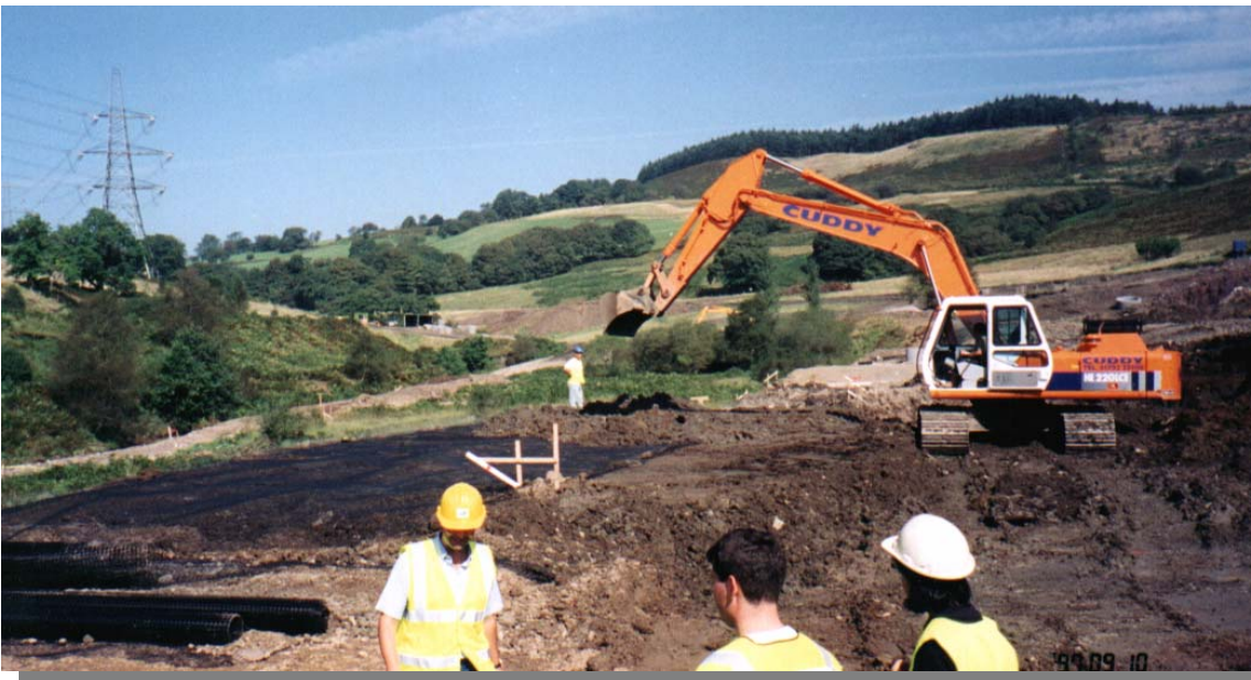
Foto 1.1.3.1.2.1.c: Construcción del humedal de Peleenna (S.Gales) en Septiembre de 1997
