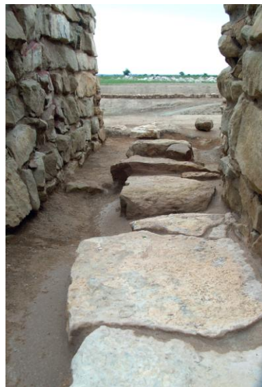
Fig. 196: Vista est de la poterna occidental de Vilars (Arbeca, Les Garrigues).
