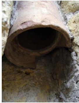
Fig. 44: Detall de l'encaix d'una peça ceràmica d'Herculà.
