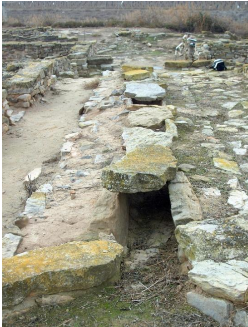
Fig. 144: Vista oest de la claveguera del carrer 5 del Molí d'Espígol.
