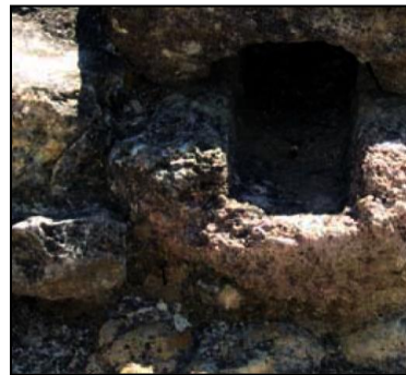
Fig. 41: Detall del bloc destinat a rebre una canalització vertical.
