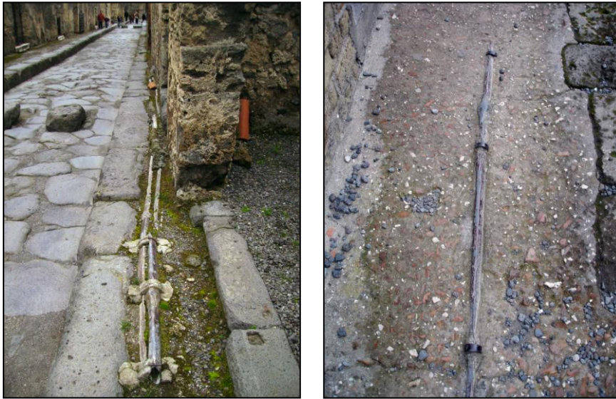
Fig. 38: Canals de distribució d'aigua de coure de Pompeia.
