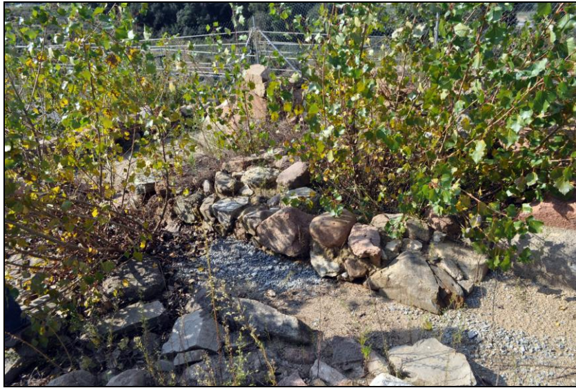
Fig. 29: Vista est de la canal d'adducció de Can Suari (Llinars del Vallès, Vallès Oriental)
