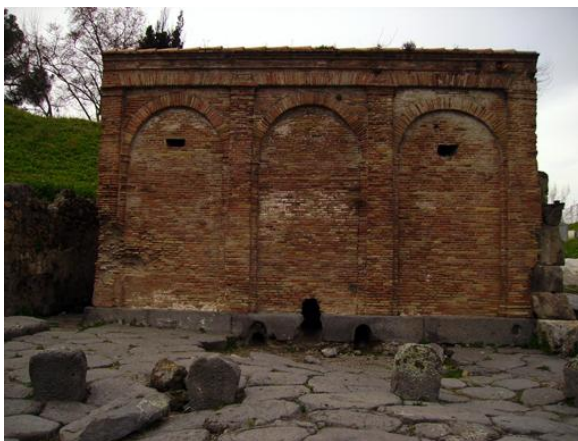
Fig. 93: Torre d'aigua de la ciutat de Pompeia amb les tres sortides de distribució d'aigua.
