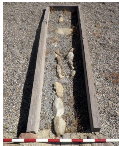
Fig. 158: Vista sud-est de la claveguera (estructura 1) del Camp de les Lloses.
