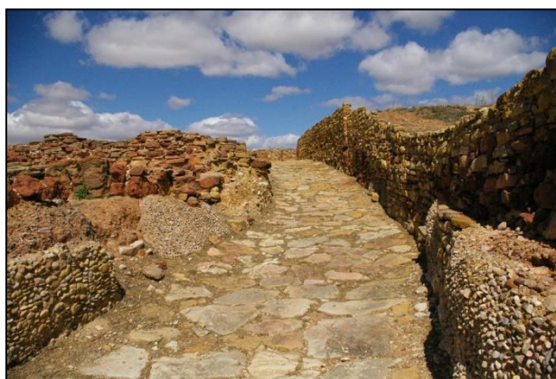
Fig. 173.- Vista del carrer descobert amb més longitud.
