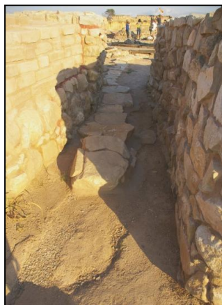
Fig. 105.- Vista des de l'exterior de la porta oest restaurada.
