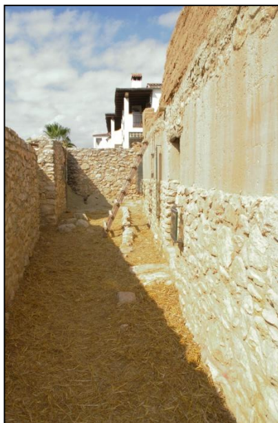
Fig. 65.- Vista del carrer CB, reconstruït, des de l'est, on s'aprecia al final a la dreta la claveguera i a l'esquerra la vorera.
