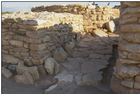
Fig. 107.- Vista des de l'exterior de l'assentament de la porta nord restaurada.
