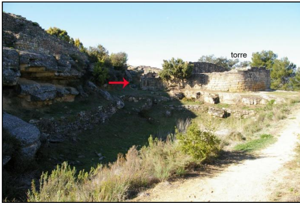
Fig. 166.- Vista de la zona d'accés a la terrassa inferior, davant la cisterna i al fons la torre semicircular.
