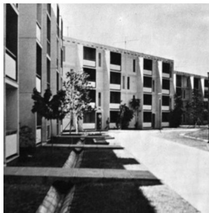
f. 4.4 “Viviendas industrializada con sistemas prefabricados K.P.D.”
