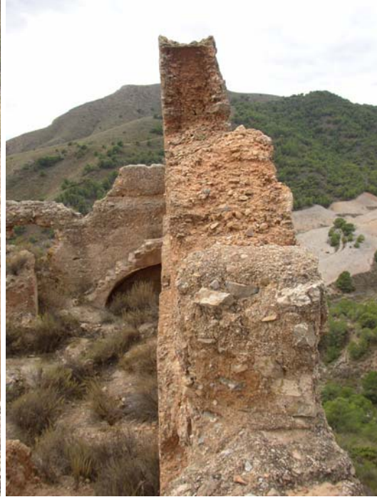
Lám. 97: detalle del muro de tapial y escalera
