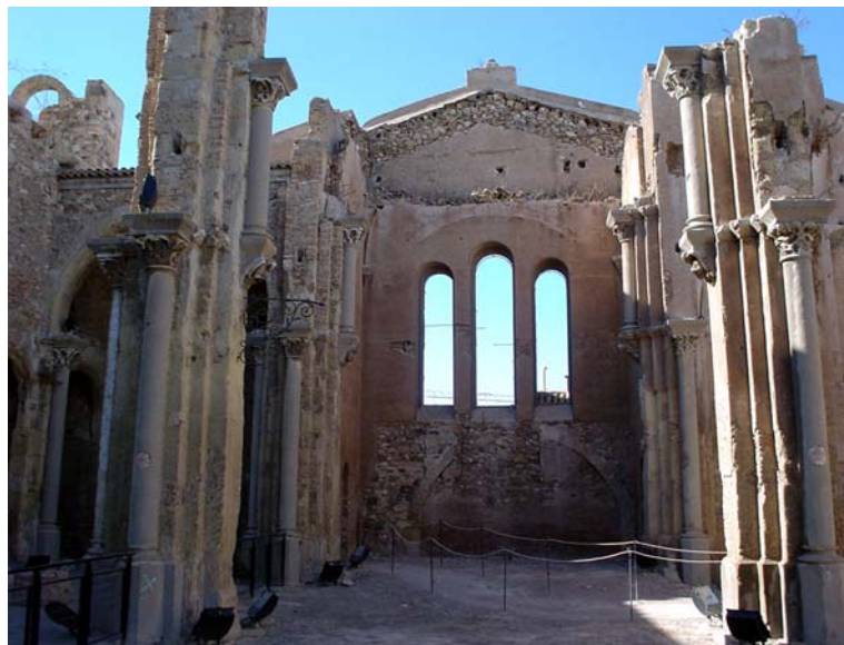
Lám. 197: nave central hacia Poniente. Estado actual
