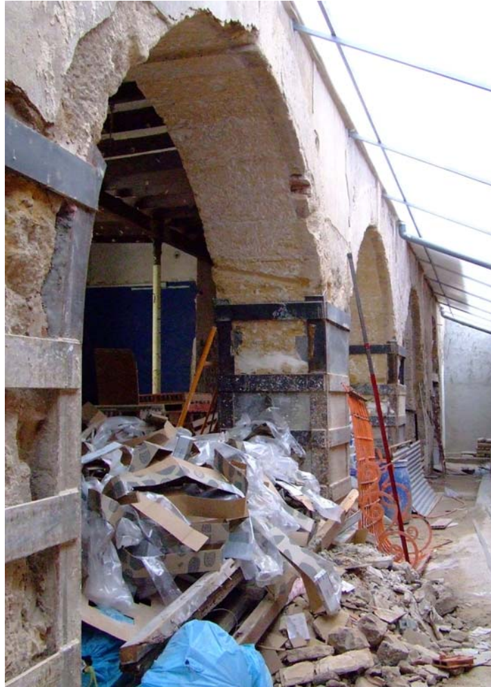
Lám. 355: arquería durante las obras de rehabilitación
