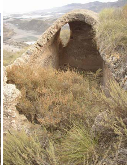
Lám. 113: interior del aljibe
