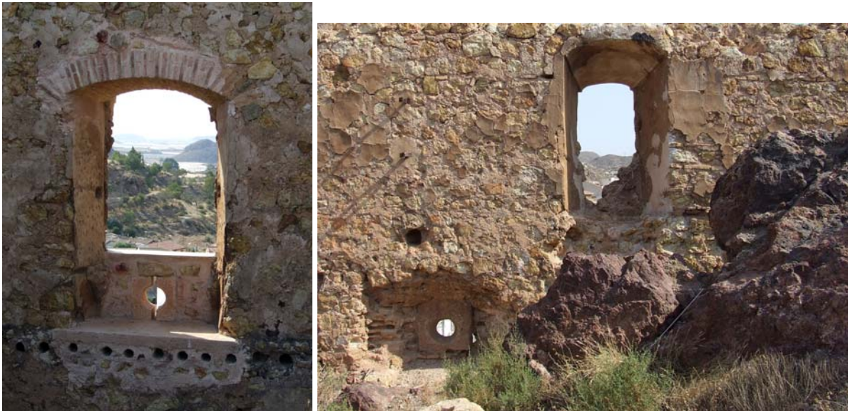
Láms. 252 y 253: detalle de las troneras para las piezas pequeñas, situadas bajo las ventanas y en los niveles inferiores del piso
