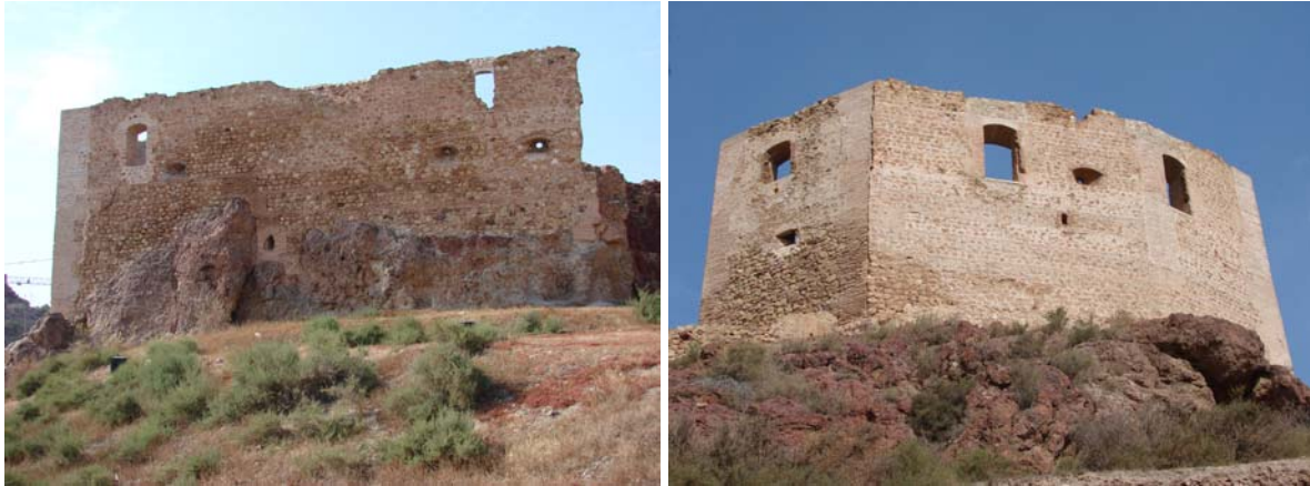
Láms. 237-238: recinto superior. Fachadas este y oeste
