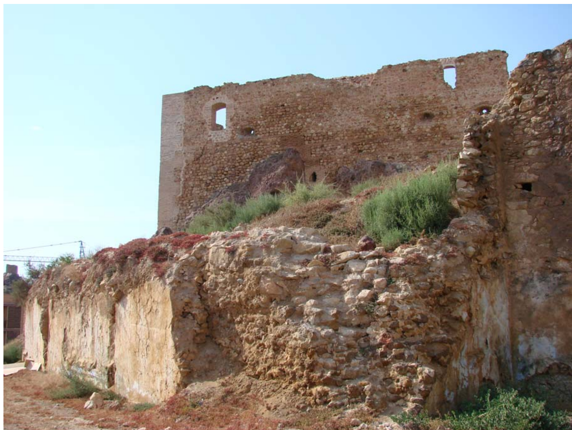
Lám. 243: Detalle de la construcción del recinto inferior
