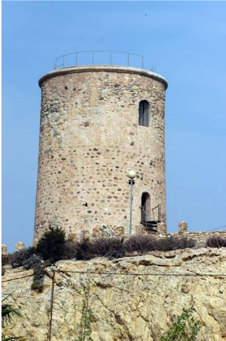
Lám. 378: torre de las Salinas, en el Puerto de Mazarrón. Probablemente la citada como ya construida por Antonelli y Gonzaga
