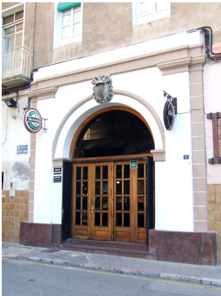
Lám. 347: Lamentable estado actual
