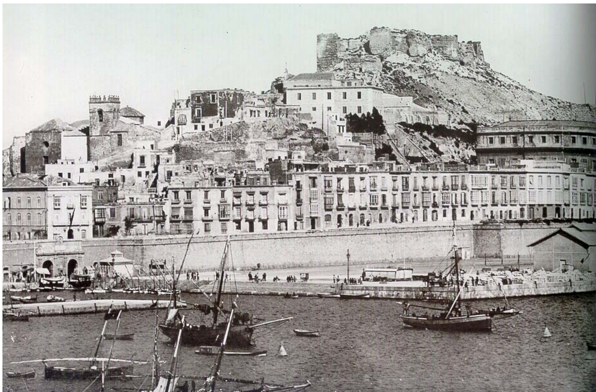
Lám. 229: Las antiguas torres de tapial de la fortaleza de Cartagena eran poco apropiadas para el montaje de piezas artilleras
