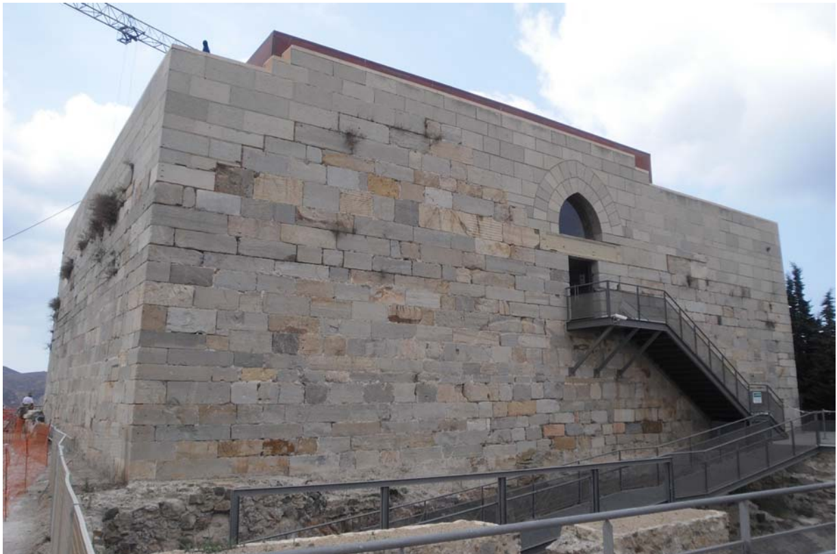
Lám. 165: fachada norte. Aspecto actual
