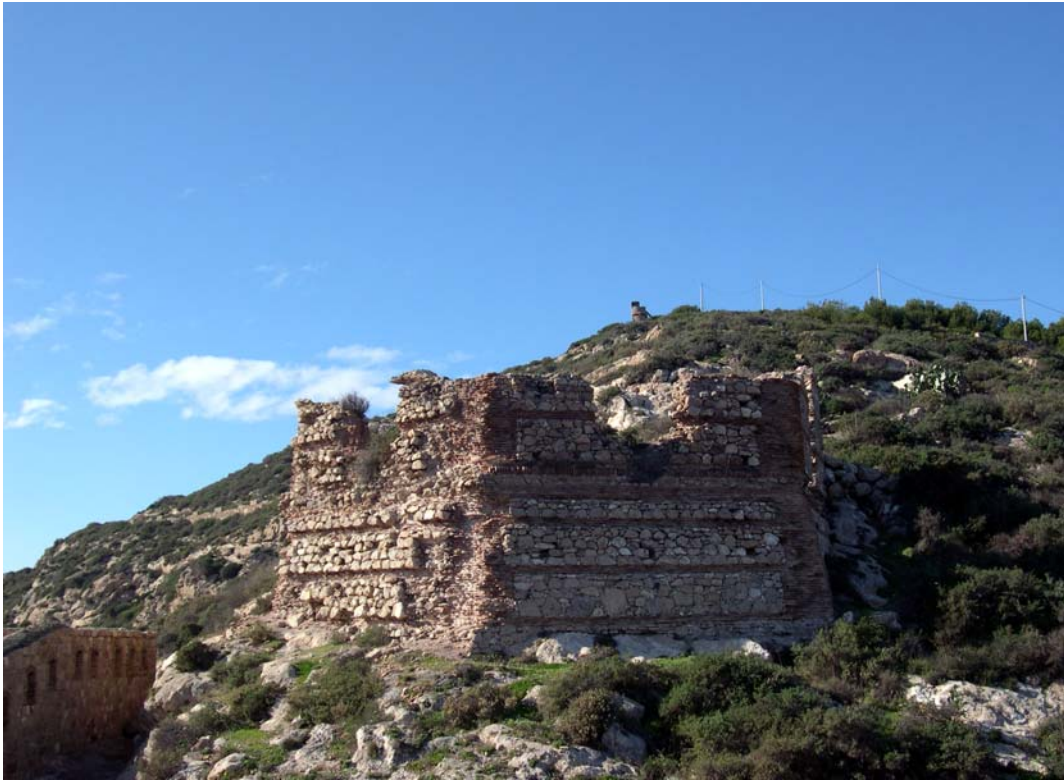
Lám. 380: ruinas de la torre de Navidad en la actualidad
