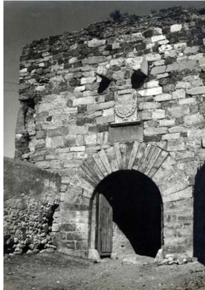
Lám. 157: puerta de la Villa en su emplazamiento actual
