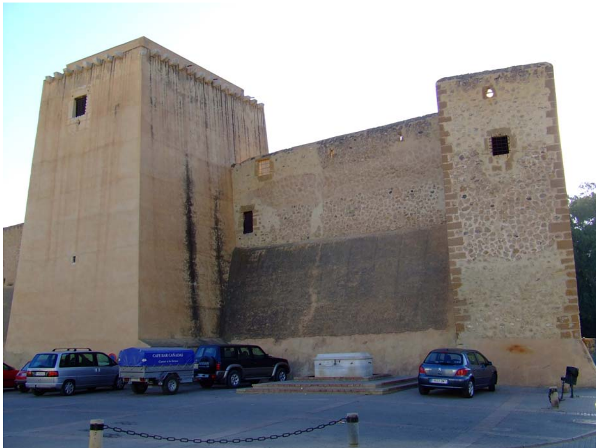
Lám. 247: Cuevas de Almanzora. Recinto exterior. Torre de homenaje y de esquina
