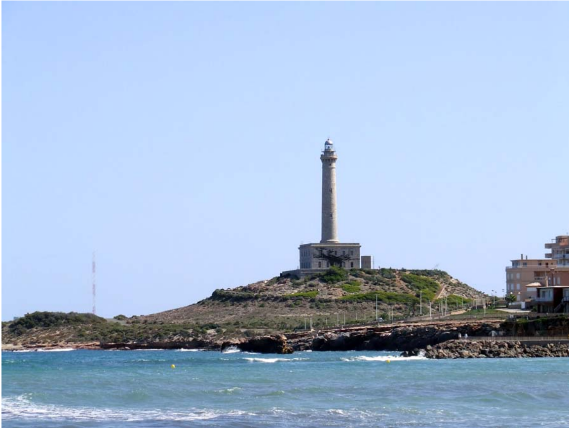
Lám. 389: emplazamiento de la torre de Cabo de Palos, hoy ocupado por el faro
