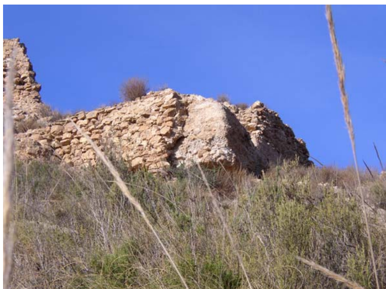
Lám. 117: forrado del tapial con mampostería
