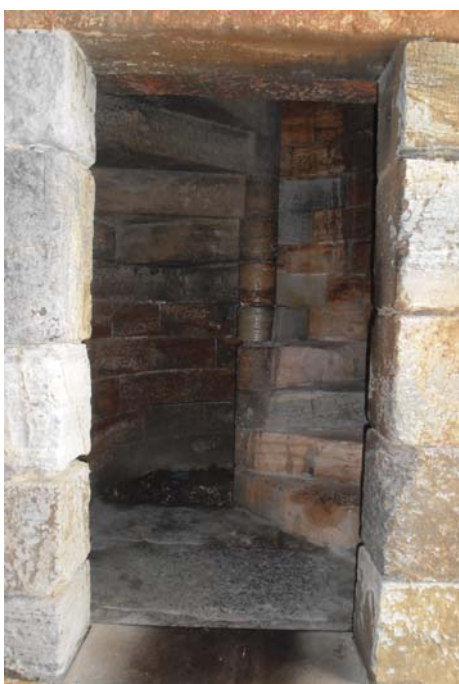
Lám. 179: acceso a la escalera de caracol desde el interior. Aspecto actual
