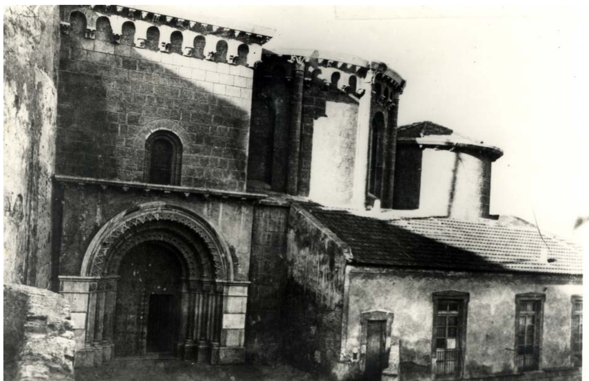
Lám. 195: fachada oriental tras la restauración de Beltrí, a inicios del XX
