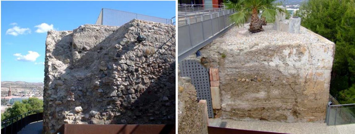
Láms. 78 y 79: torreones de tapial forrado de mampostería y tapial calicastroado al norte del recinto superior
