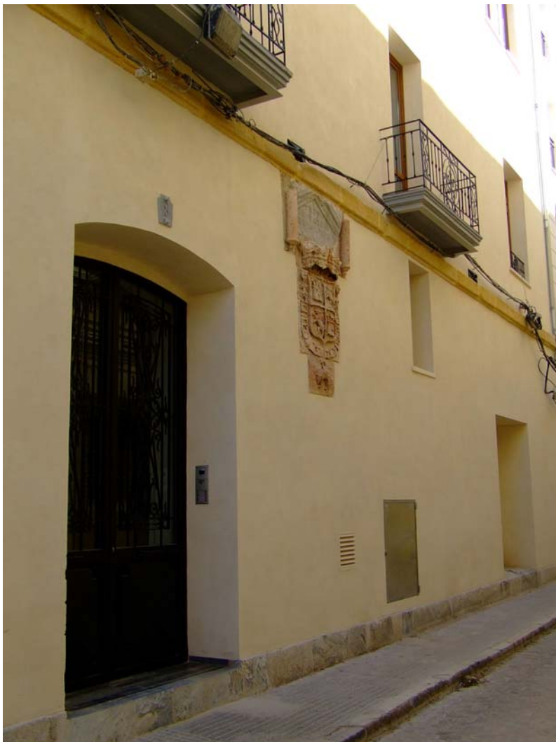
Lám. 352: fachada de la calle Intendencia tras las obras de rehabilitación
