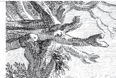
[4] Detalle del empate de la columna y el entablamento
