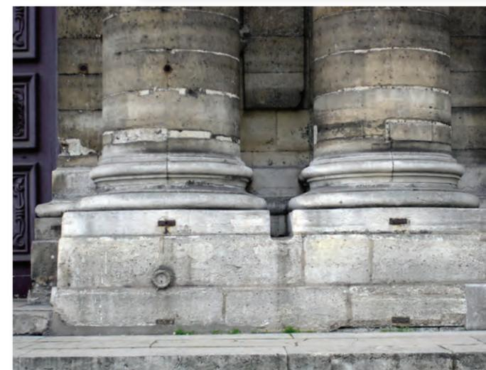
«Defecto: consiste en levantar las columnas sobre pedestales en lugar de apoyarlas directamente en el pavimento. Siendo las columnas, por decirlo así, las piernas del edificio, es absurdo darle otras piernas».<sup>13</sup>
