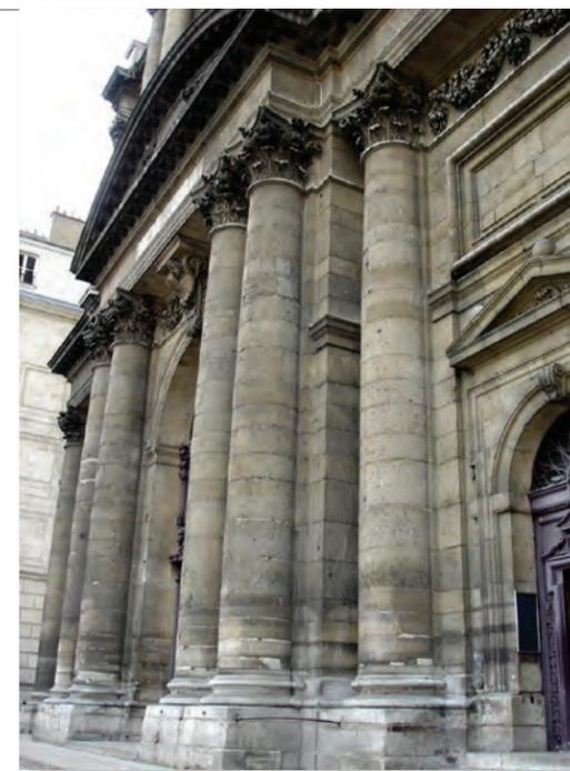
«Defecto: cuando las columnas, en lugar de encontrarse exentas, forman parte de un muro».<sup>12</sup>
