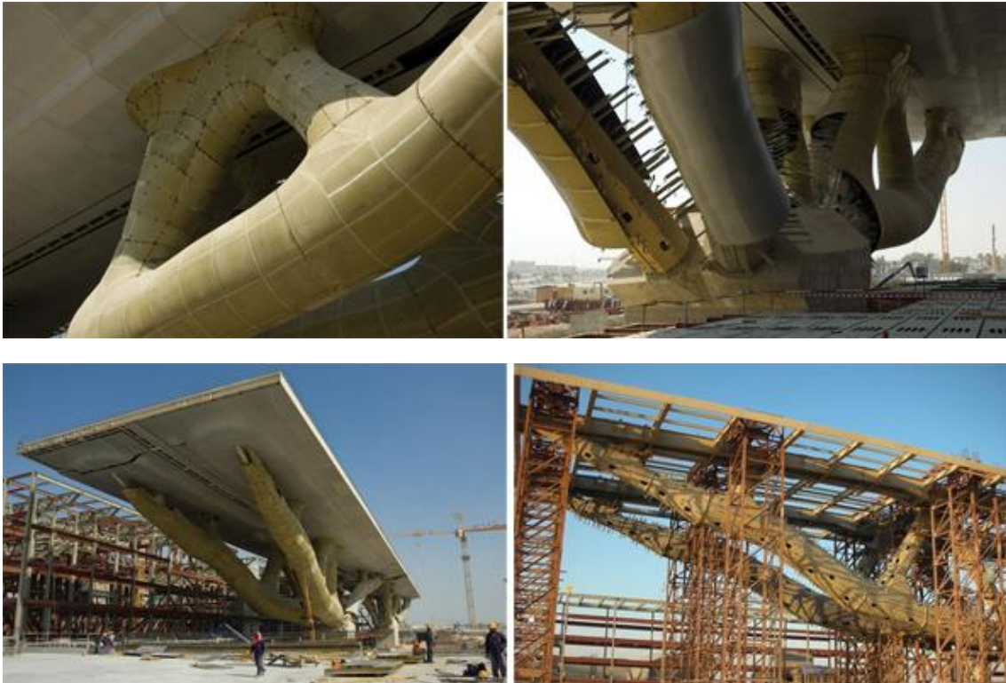
Figura 54. El nuevo centro de convenciones de Qatar fue diseñado por Arata Isozaki quien utilizó el método ESO para diseñar una estructura con forma de raíz para la fachada como protección al clima del desierto y como símbolo de crecimiento y fortaleza del país. http://cubeme.com/blog/2010/02/08/education-city-convention-centre-qatar-by-yamasaki-architects/ . [19/08/10].
