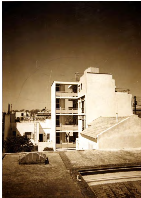
III.3.9-10 Contrafachada con escalera de servicio y pasarelas conectoras. El volumen cilíndrico deformado de la escalera es encerrado por la grilla ortogonal de las pasarelas. FHA G045, G046.
