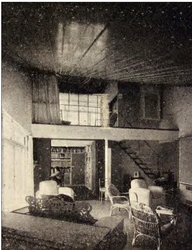
III.4.23 Vista interior del 9° y 10° piso.
