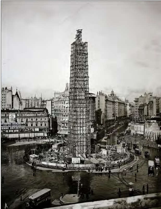
I.6.1 El Obelisco en construcción. Buenos Aires, abril de 1936.
