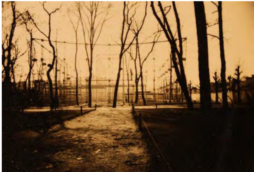
I.3.6-18 El Pavillon de les Temps Nouveaux en proceso de desmontaje fotografiado por Jorge Ferrari Hardoy. París, 1937. FHA G111.
