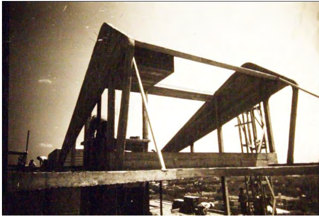
III.4.19-22 Estructura de hormigón armado del volumen que cubre los dos últimos pisos. FHA G031e.
