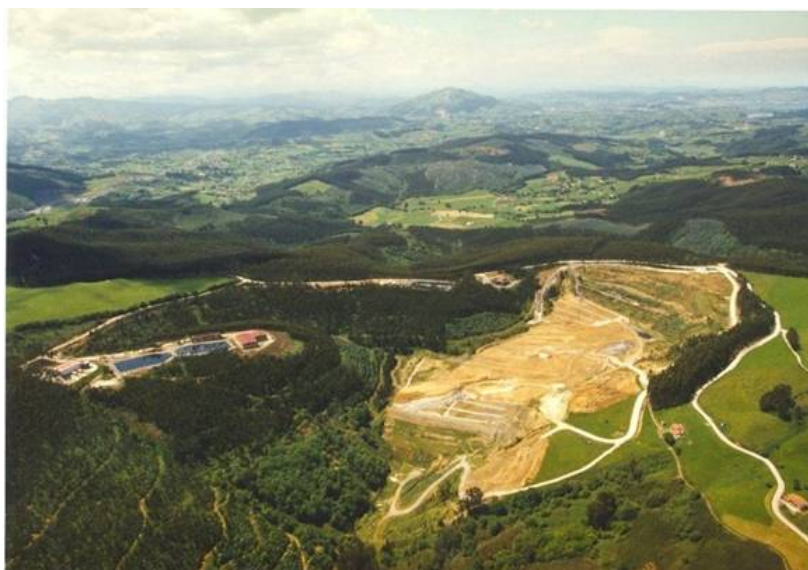
Figura 1.2 Vista aérea del vertedero de Meruelo (Cantabria)
