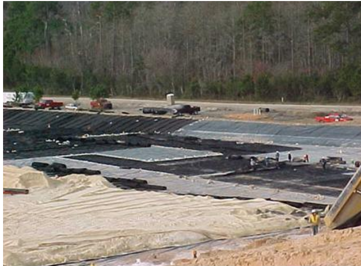
Figura 1.6 Colocación de geomembranas y geotextiles en la base de un vertedero
