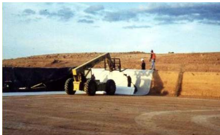
Figura 1.5 Colocación de láminas de GCL en la base de un vertedero
