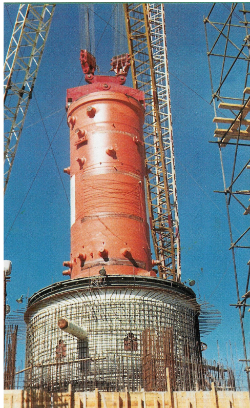
Figura 3.24 Perspectiva de la vasija en el momento de su colocación
