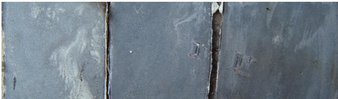
Figura IV.18. Coloraciones obtenidas con las distintas mezclas preparadas aplicadas como capa de contacto.
