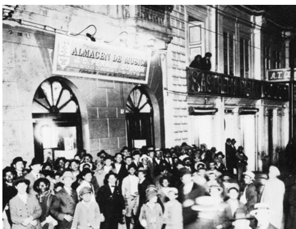
FIG 4-14: Almacén JDFG en la ciudad de Quito, ca. 1925-1930.
