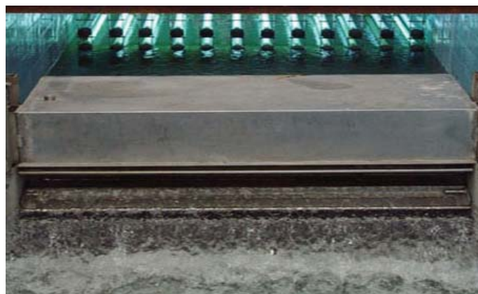
imagenes de la gestión de aguas pluviales de Kronsberg separación de aguas grises recuperación por radiación ultravioleta
