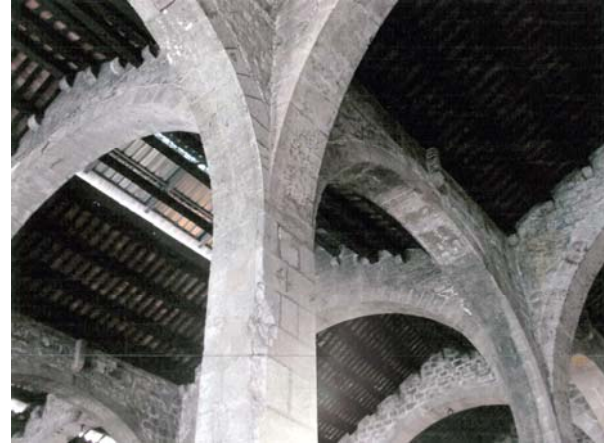
La travada entre les dues arcades permet la construcció i es la garant de la identitat de l'edifici de les Drassanes de Barcelona (Arxiu Terradas Arqtes.).
