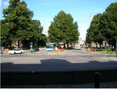
Fig. 8.127. Carretera de dos carriles delante de la estación
