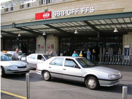
Fig. 8.160. Parada de taxis en la entrada de la estación
