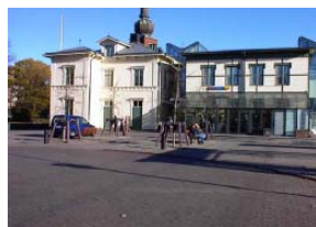
Fig. 8.123. Vista lateral de la estación y su ampliación
