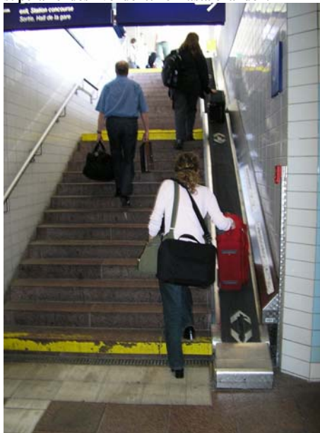
Fig. 8.81. Cinta transportadora de equipajes para superar el desnivel del túnel hasta el andén.
