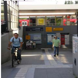
Fig. 8.80. Rampa que lleva a los andenes sin que tener que pasar por el vestíbulo
