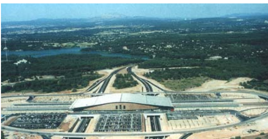
Fig. 8.4. Edificio de la estación
