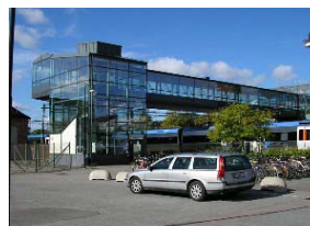
Fig. 8.124. Acceso al puente desde el "otro lado"
