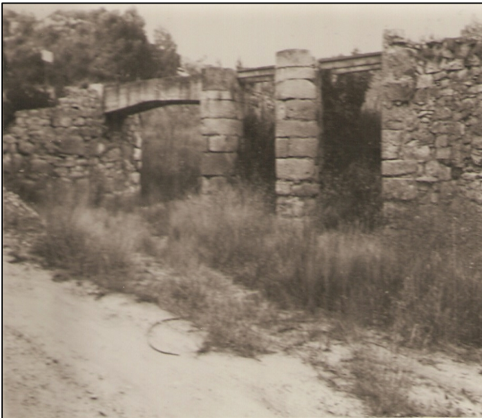
Tram del traçat del tramvia Canota, que unia el grup miner de Seròs amb l'embarcador ubicat a l'Ebre. És tracta d'un dels ponts que es podien observar durant el seu recorregut de més de 4 quilòmetres.
