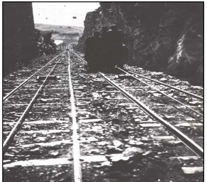
Pla inclinat de la mina Virgen del Pilar (1945) amb un sistema de doble via automotor, que permetia l'ascens de les vagonetes buides gràcies a la inèrcia generada pel descens dels vagons plens de carbó (Salmerón i Bosch, C.; Trenes del Ebro ).
