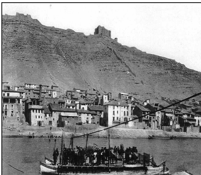
Pas de barca ubicat a Mequinensa, que permetia creuar el riu Ebre gràcies a l'ajut de dos llauts que estaven units per una plataforma que s'ajudava d'uns cables aeris.
