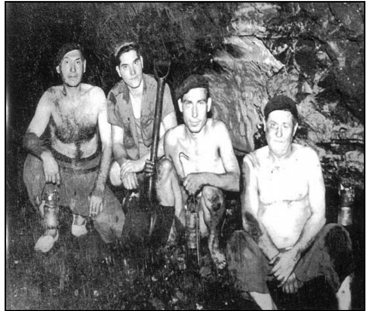
Grup de miners treballant a la galeria, equipats amb pales i ambllum de carbur. Es pot apreciar que treballaven amb el tors descobert i alguns d'ells sense cap tipus de calçat.
