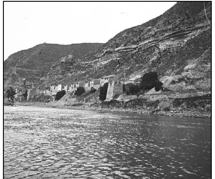
Exterior de la mina Fradera (Vallcarca), situada al terme municipal d'Almatret, i un dels principals productors de la conca minera des de la Primera Guerra Mundial gràcies a la fàbrica de ciment que José Fradera tenia a la població de Vallcarca (Fons Salvany, 1921).
