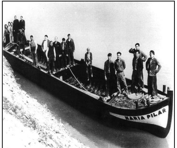
El llaüt Maria Pilar amarrat a la vora de l'Ebre, estampa en què es poden apreciar les diferents parts d'aquestes embarcacions que transportaven el lignit fins a l'estació de Faió i els pobles riberencs.
