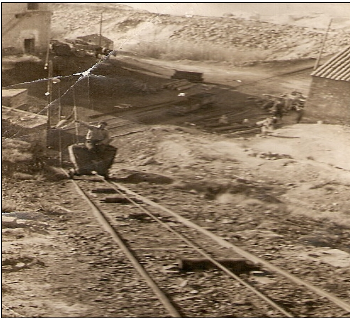
Pla inclinat de la mina Guadalupe (Granja d'Escarp), gràcies al qual es podia salvar el fort pendent existent des de la bocamina fins a l'embarcador situat al Segre. Aquesta concessió va començar a ser explotada per Ignasi Girona a partir de l'últim quart de segle XIX.
