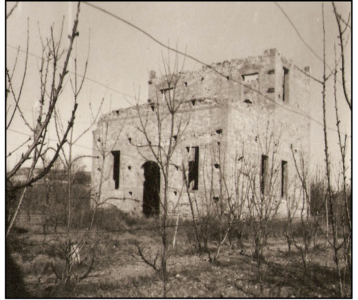
Antic edifici dedicat a la destil·lació dels lignits de la conca Ebre/Segre, construït a la població de Massalcoreig. Aquesta fàbrica de quitrà, constituïda després de la Primera Guerra Mundial, però, no va prosperar.
