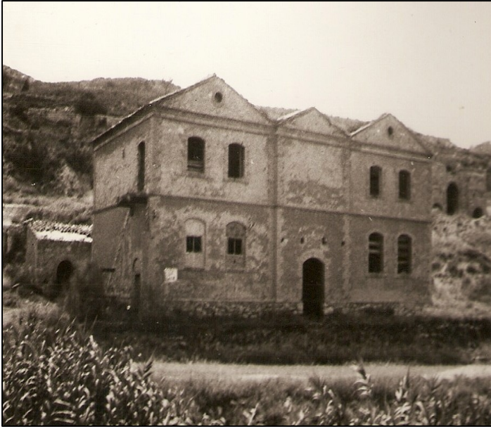
Antiga fàbrica de ciment pertanyent a Ignasi Girona, situada a la Granja d'Escarp i primer complex industrial que es va establir en aquesta conca minera. Al fons, a la part dreta es poden veure part dels forns utilitzats per a l'obtenció de ciment.
