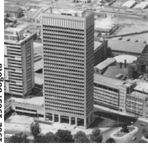
Edificio oficinas. Conjunto Bavaria 1962-1965. Bogotá
