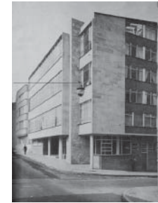
Edificio de apartamentos 1949. Bogotá
