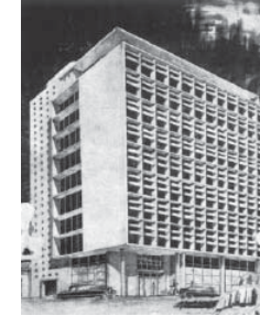
Edificio de renta. 1950. Barranquilla
