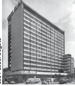
Edificio Seguros Bolivar 1954-1956. Bogotá
