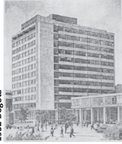
Edificio Colón 1952 Bogotá
