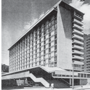
Edificio Residencias Tequendama Sur. Cuerpo alto superpuesto/unido
