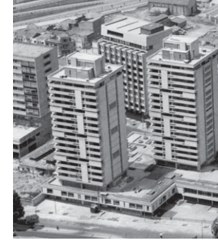
Conjunto Bavaria - Torres de vivienda Cuerpo alto superpuesto/separado
