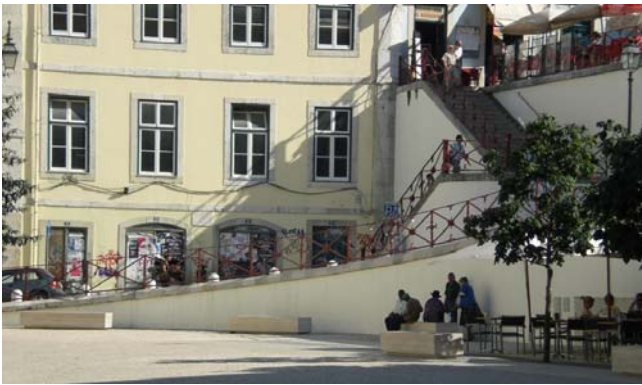
Las escaleras hacia la colina, desde el Largo da Estação
