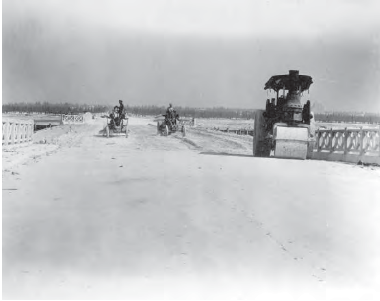
Construyendo la Venetian Causeway en 1925. Necesitamos estudiar que modelos funcionaron económicamente en el pasado para no cometer los mismos errores.
