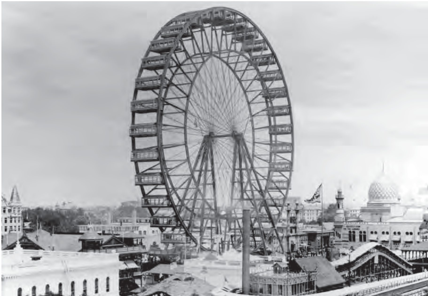
La "Ferris Wheel", la primera noria instalada con motivo de la Exposición Universal de 1893 en Chicago. Constituye la primera construcción basada en estrategias de venta. Tenía 80 m. de altura, 36 cestas-vagones, y una capacidad total de más de 2.000 pasajeros.
