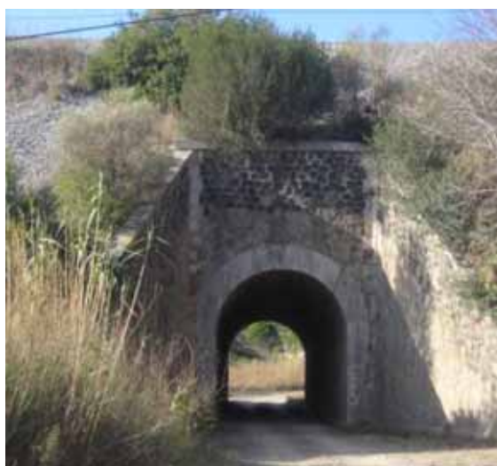
Fotos B26 i B27.- Boques d'entrada (esquerra) i de sortida (dreta) del túnel sota el tren, per on circula el torrent i les persones i vehicles (4 m d'ample i 5 m d'alçada màxima; secció: 18,2 m 2 ). (foto PMR, 2008).
