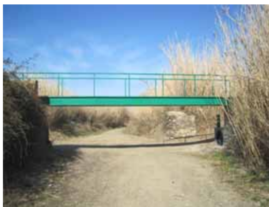
Foto S30.- "Passera nova" d'accés als horts quan hi ha aigua a la riera ( punt S8 ) (9 m d'ample i 2 m d'alt; secció 18 m 2 ). (foto PMR, febrer 2010)
