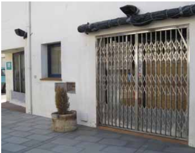
Foto Y19.- Façana de l'hotel Cal Mariner durant el període de vacances, amb proteccions a l'aigua darrere la reixa. (foto PMR, febrer 2010)
