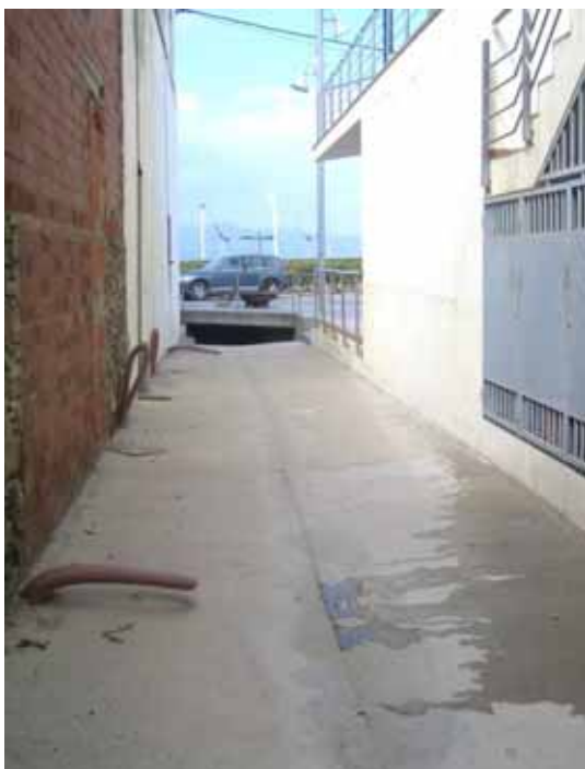
Foto Y4.- Passatge rere Cal Mariner, amb el paviment corbat per permetre una millor circulació de l'aigua; al fons la boca d'entrada del pas soterrat (punt Y4) (foto PMR, febrer 2008)
