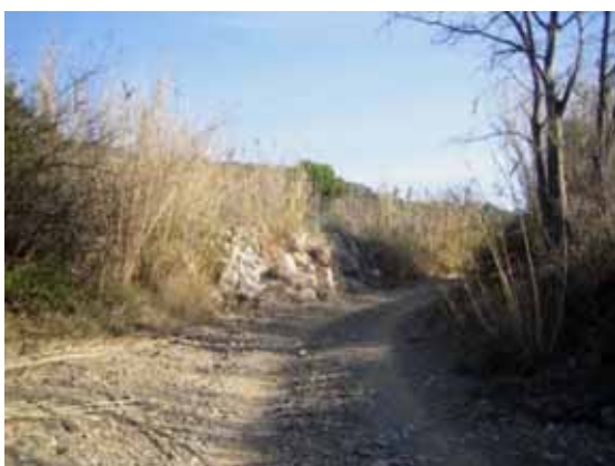
Foto B43.- Camí-llera amb rocalla que protegeix l'esvoranc de la mota de protecció lateral, en una corba per on va desbordar el 1987. (Punt crític B4). (foto PMR, novembre de 2007).
