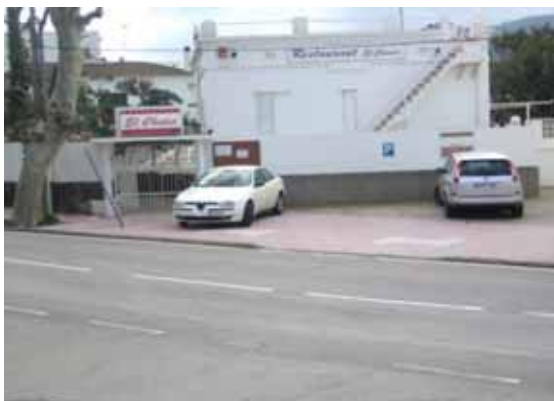
Foto Y17.- Restaurant El Xalet, al tram inundable de la carretera de Cadaqués, i on van a parar les aigües desbordades del rec. (foto PMR, 2008)
