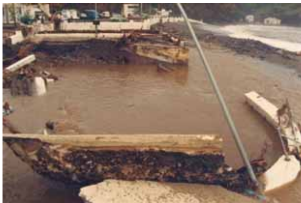
Foto P55.- Esboranc d'enfonsament del darrer tram del soterrament de la Rambla, ja a ran de la platja (Foto M. Roman, 157, 4 d'octubre de 1987)
