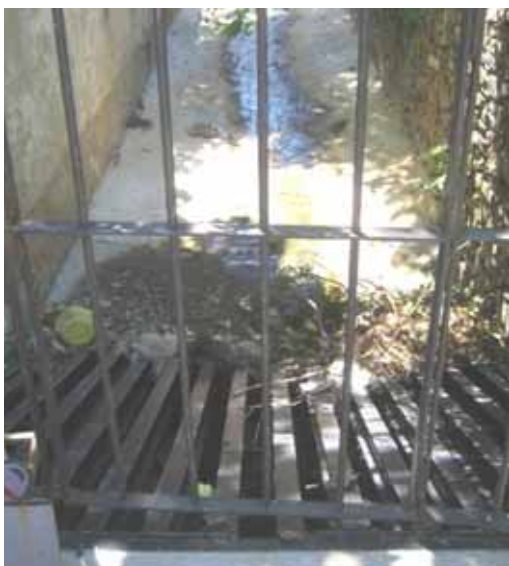
Foto E3.- Rec del Pi, reixa d'entrada al soterrament del torrent sota l'Av. de Barcelona ( punt E2 ). (foto PMR 2009).
