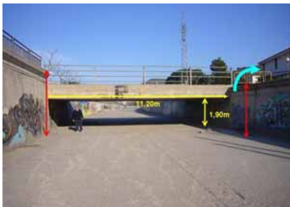
Foto C31.- Pont de la urbanització Sant Miquel, que és un punt conflictiu per desbordament especialment per la riba dreta, tal com s'indica amb la fletxa. (Punt crític C13) (foto PMR, 2008).
