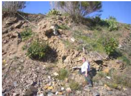
Foto S18.- Acumulació de terres d'abocament defectuosament segellats i que poden ser incorporats per les aigües (Foto M.A.M. març 2009)
