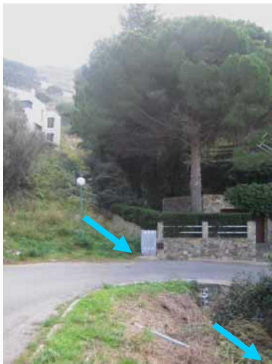
Foto Y15.- Pont del carrer Frederic Marés sobre el rec, a la capçalera (foto PMR, febrer 2008)
