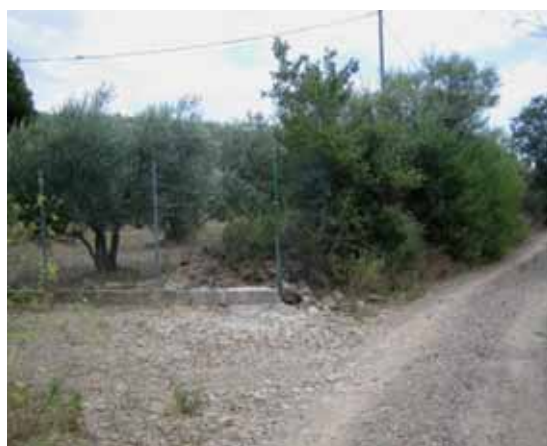
Foto B42.- Interrupció de la mota en un punt d'accés als conreus des del camí-llera (punt B5), per on trenquen les aigües que van pel camí i passen a circular entre les oliveres. ( T_1 ). (foto PMR, agost 2008).
