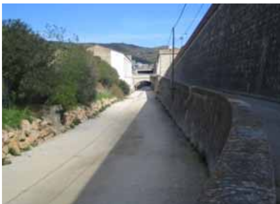
Foto P25.- Tram recte de la canalització de la riera vist aigües avall; a l'esquerra la terrassa ocupada per la depuradora i protegida per escullera i a la dreta el mur d'obra de l'estació. Amplada: 7,50m. (foto PMR, març 2008)
