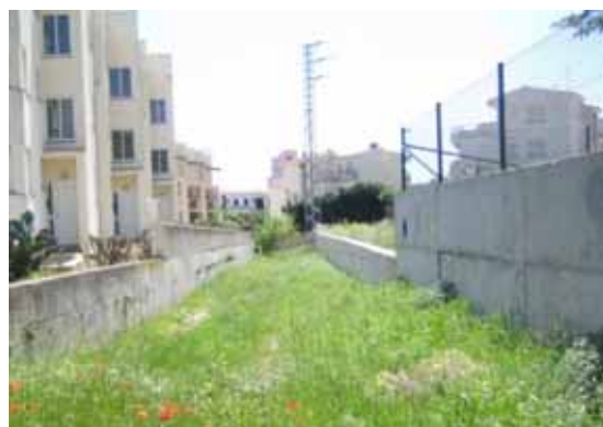
Foto F8.- Torrent nord, tram canalitzat però sense solera, vist des del pont del carrer de Guillem de Berguedà i mirant al mar. (Foto PMR, maig 2009).
