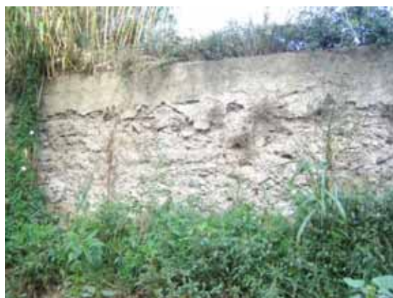
Foto L49.- Mur de protecció de l'erosió de la terrassa T 1 , a la riera de la Valleta, sector dels horts. (Foto PMR, setembre de 2008 9221)
