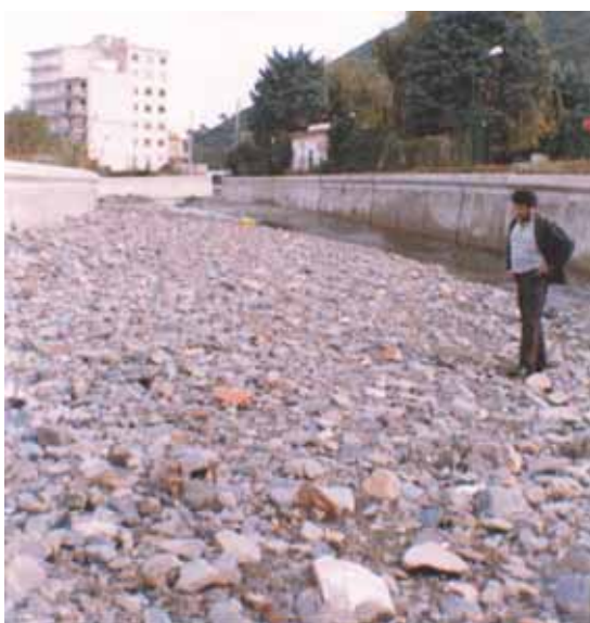
Foto C22.- Vista dels sediments acumulats en el sector final de la canalització, poc després de la rierada del 1993. Notis la mida d'alguns dels còdols, que és de l'ordre de 30 a 50 cm. (foto M. Carrés)
