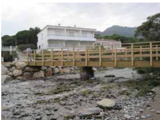
Foto V5.- Desembocadura a la platja i passera del camí de ronda. Alçada: 1,10 m entre llera i passera (punt crític V2). (foto PMR, octubre 2010)
