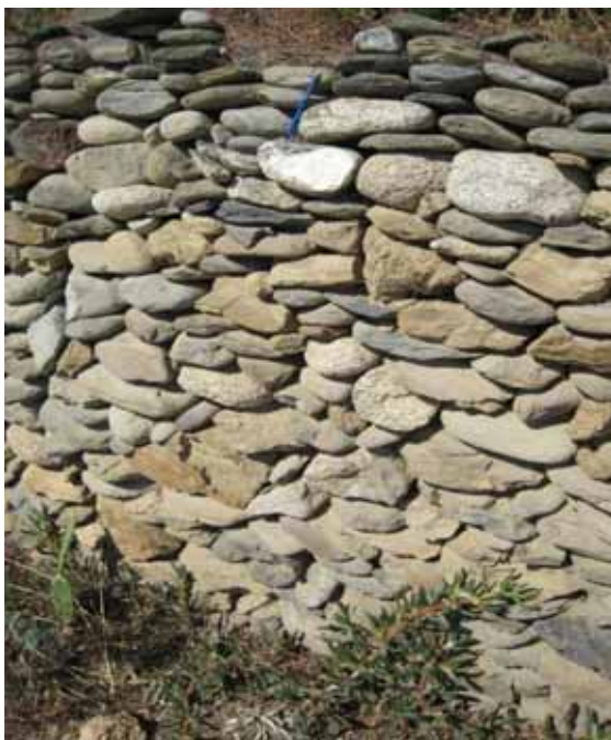
Foto V7.- Detall d'un mur de pedra seca construït a ran del càmping amb els còdols de la terrassa T 1 . Noti's la presència de còdols rodats de naturalesa granítica. (foto PMR, agost 2010)
