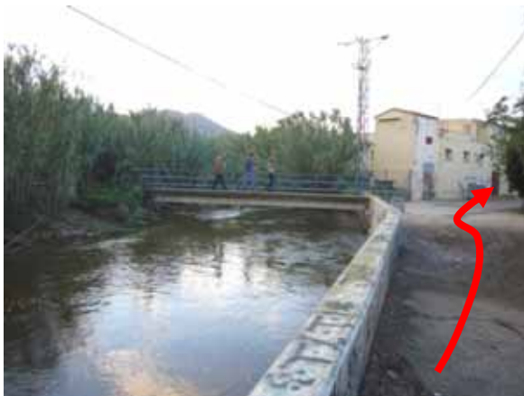
Foto S36.- Vista de la riera creixuda, des del punt de desbordament S10 . Al fons la vegetació que estreny el canal, darrera la passera de la depuradora i l'inici del carrer de la Selva; 13 d'octubre 2010. (foto MAM)
