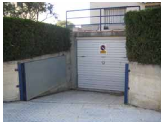
Foto L99.- Comporta d'un sol batent, Av. Mestral. (foto PMR, novembre 2007)
