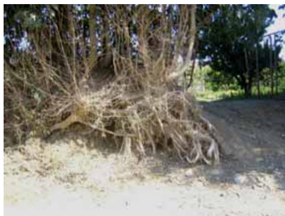
Foto L57.- Erosió de la base d'una mota de terra i vegetació a la riba esquerra del rec de Madres. (foto PMR, agost 2008)
