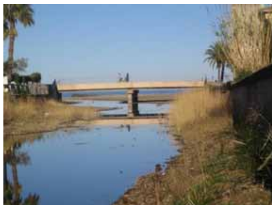
Fotos L36 i L36bis.- Pont de l'Av. Mestral que és insuficient per les grans crescudes ( punt crític L25 ). (foto PMR, novembre 2007)
