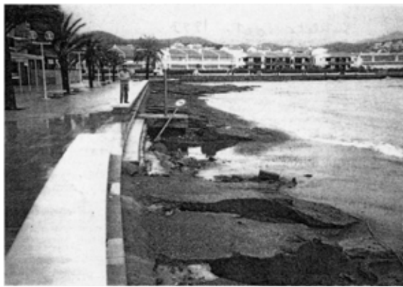
Foto L75.- Passeig Marítim i platja del Port, també el 2 de novembre de 1993. (foto Albert Bonsoms, treta del butlletí nº 57, octubre del 1993).
