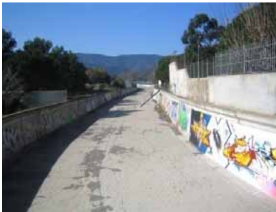
Foto C24.- Aspecte típic de la canalització amb els murs laterals i la base de formigó. (foto PMR, febrer 2008)
