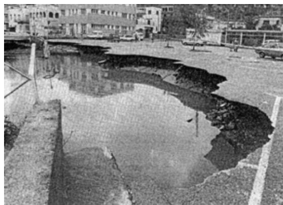
Foto L72 i L73.- Passeig Marítim i platja, el 3 d'octubre de 1987 on es veu a la de l'esquerra el salt de l'aigua de la riera a l'arribada a la platja. A la de la dreta a soscavació del paviment deguda al salt de l'aigua (Fotos Pumareda, tretes del Butlletí nº 33, juliol de 1987, però editat molt posteriorment).
