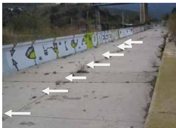
Foto C21.- Vista de la canalització amb indicació d'algunes de les perforacions a la llosa per tal de disminuir la subpressió de l'aigua de l'aquífer subterrani. (foto PMR, juny 2008)
