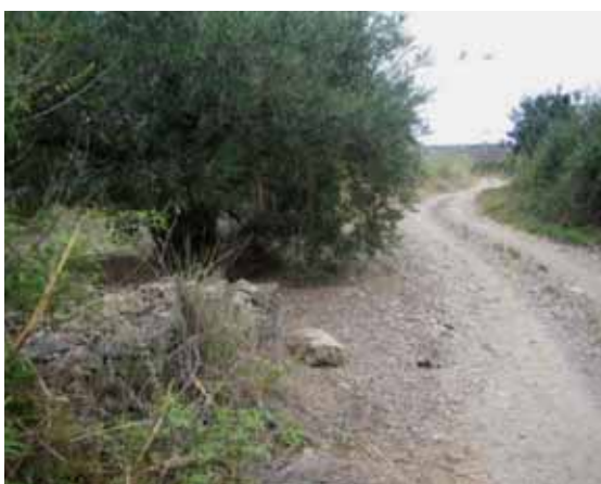
Foto B41.- Tram de contenció amb un mur de pedra seca en lloc de mota (esquerra del camí-llera). Sovint, el tipus de protecció depèn del propietari del conreu protegit. (foto PMR, agost 2008).
