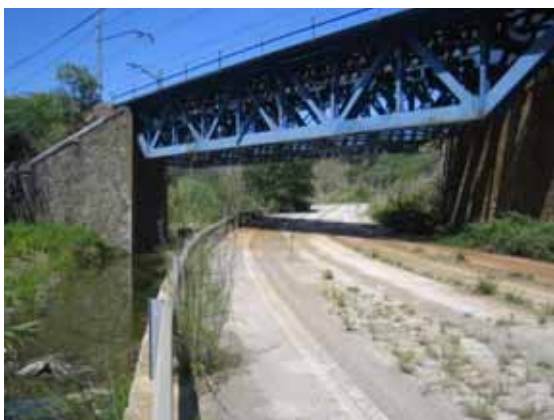
Foto L32.- Pont del tren sobre la riera i l'antic tram de carretera, que redueix la secció de la riera, i que sovint s'inunda ( punt L11 ). (foto PMR, juny 2008)
