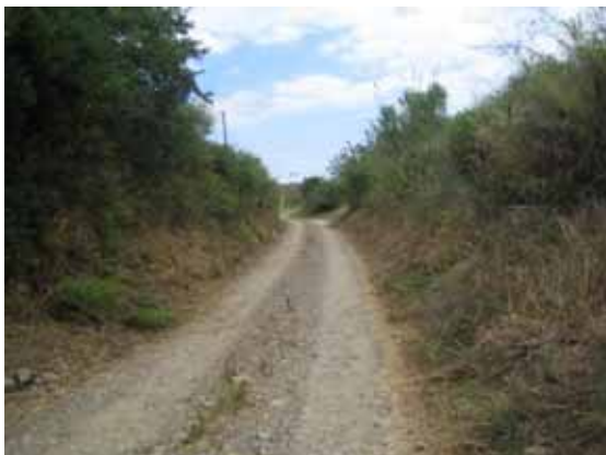
Foto B3.- Tram del camí-llera vorejat per dues motes que el converteixen en una llera semi-canalitzada. (foto PMR, agost 2008).
