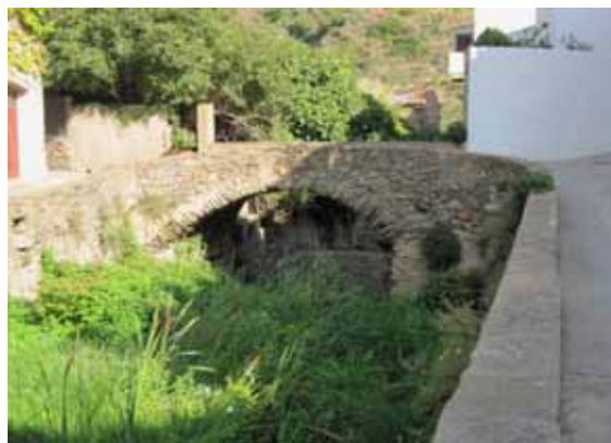
Foto M6.- Pont carrer de la Font, també dit del Corder (5 m d'ample i 3 m d'alçada). (foto PMR, agost 2010)
