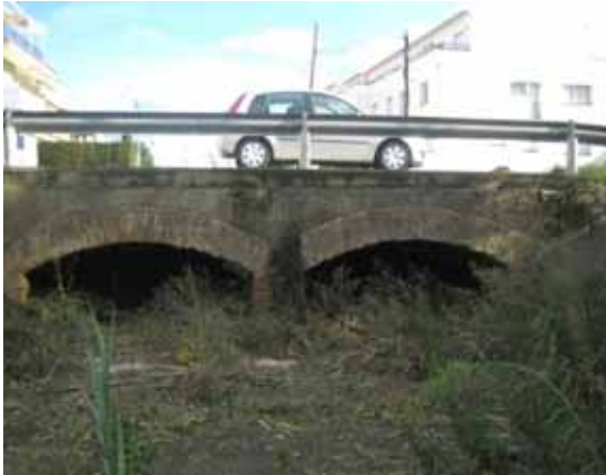
Foto B28.- Boques d'entrada de la riera del Boquer a la canalització de soterrament entre la carretera i el mar (punt crític B7). (foto PMR, 2008)
