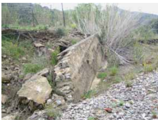
Foto S26.- Mur socavat i bolcat, que feia de protecció lateral de l'erosió de la riera. (foto PMR, Abril 2008)
