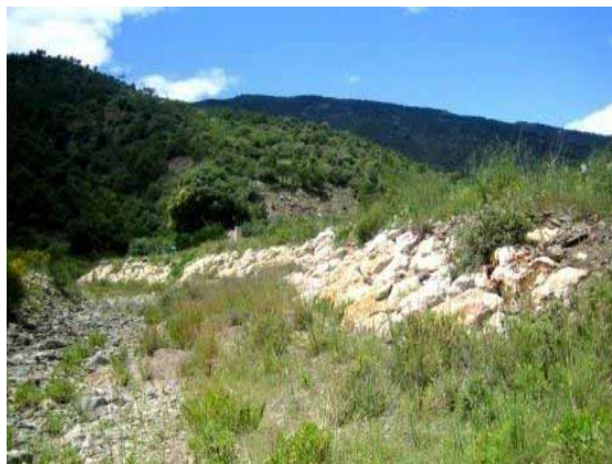
Foto C26.- Escullera de protecció de conreus a la riba esquerra, al sector de la barraca de Tarragona, poc per sota del nucli de Molinàs. (foto PMR, juny 2008).
