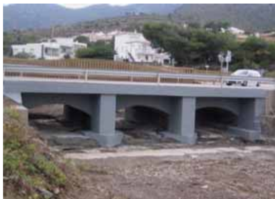
Foto M 15.- Detall del pont de la carretera GiV-612 amb les dues estructures: l'antiga d'arcades i la moderna rectangular d'ampliació de la carretera (foto PMR, novembre 2008)
