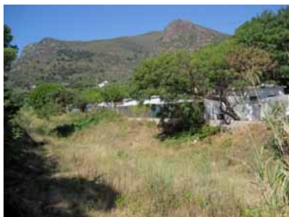
Foto V6.- Llera de la riera i mur de protecció lateral sota el càmping. Desnivell entre T_0 i T_1 de 1,50 a 1,60 m. (foto PMR, agost 2010)
