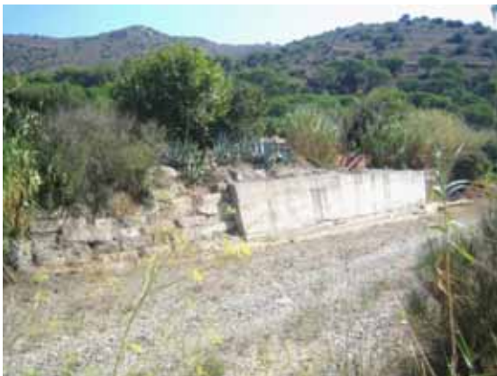
Foto S21.- Protecció lateral diversa: mur de formigó i escullera de blocs d'enderroc. (foto PMR, setembre 2008)
