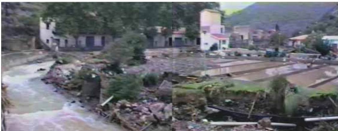
Foto P52.- Vista del sector de la depuradora després de ser escombrat per l'aigua, el 3 d'octubre de 1987 (fotos vlcsnap-43165 i vlcsnap-43372, retallades del vídeo)
