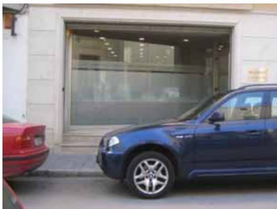
Foto L91.- Graons en un edifici nou al mateix C/ Salmerón. (foto PMR, novembre 2007)
