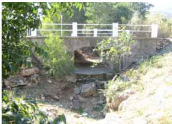
Foto L37.- Pont de la primera entrada a la vila sobre la riera d'en Prim, que redueix la secció ( punt crític L18 ). (foto PMR, agost 2008)
