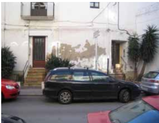
Foto L90.- Protecció per desnivell de 8 graons en un edifici antic del C/ Salmerón. (foto PMR, novembre 2007)
