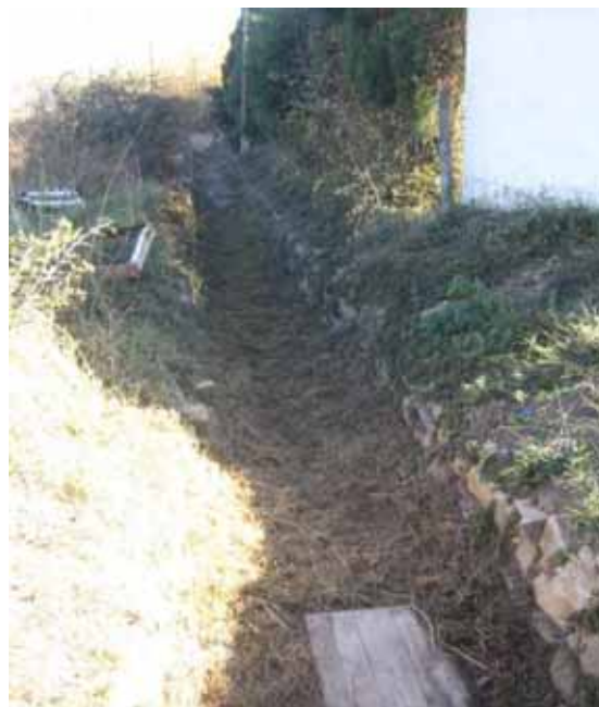
Foto L43.- Exemple de rec de drenatge dels horts. (foto PMR, novembre 2007)
