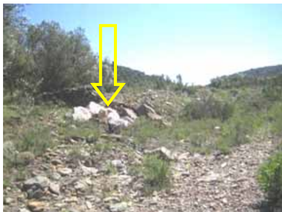
Foto G10.- Punt de trencament de la mota de la riba esquerra el 1987, ara novament protegit per una minsa escullera i per terres; vista des de la llera. (foto PMR, juny 08)
