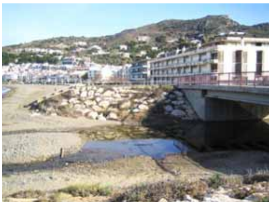
Foto S23.- Escullera a la desembocadura de la riera a ran dels estreps del pont de la GI-612 ( punt S11 ). (foto PMR, gener 2008)
