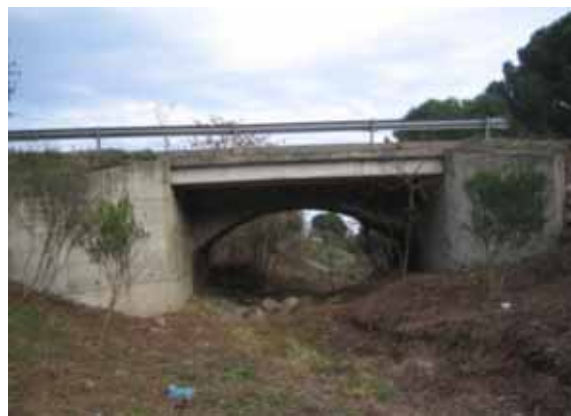
Foto V4.- Vista de conjunt del pont de la carretera; en primer terme la part nova, d'estructura rectangular, corresponent a l'ampliació de l'amplada de la carretera, i en segon terme l'arcada antiga més petita. (foto PMR, novembre 2009)
