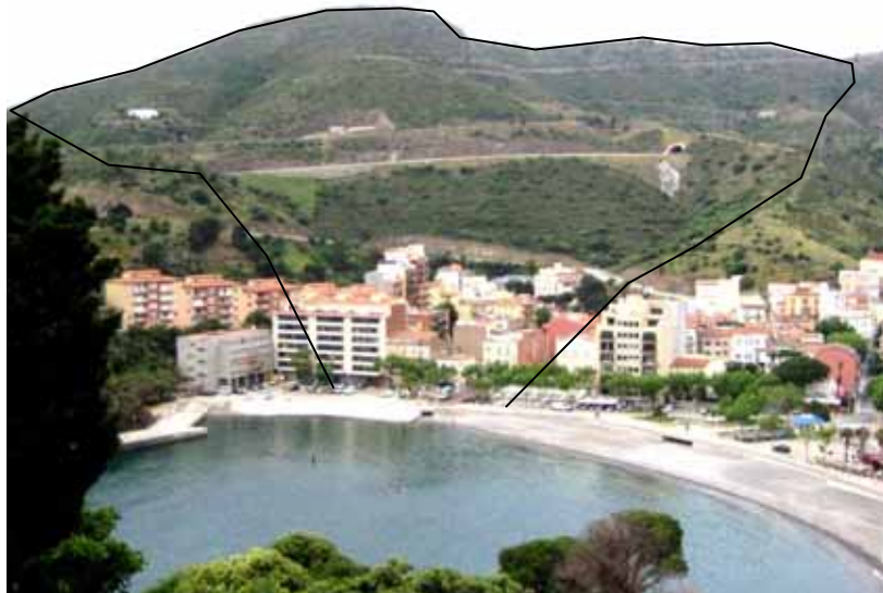
Foto E1.- Vista general de la conca i del seu contorn, des del N. El tram final circula soterrat entre les edificacions. (foto PMR, maig del 2009)
