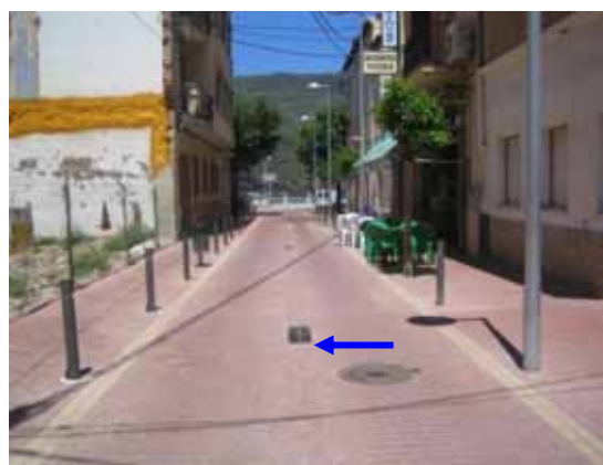
Foto E7.- Embornals al centre de l'Av. Barcelona construïts després del 2006, que permeten tant alliberar la pressió del soterrament com l'entrada d'aigua a la canonada. (foto PMR, 2009)
