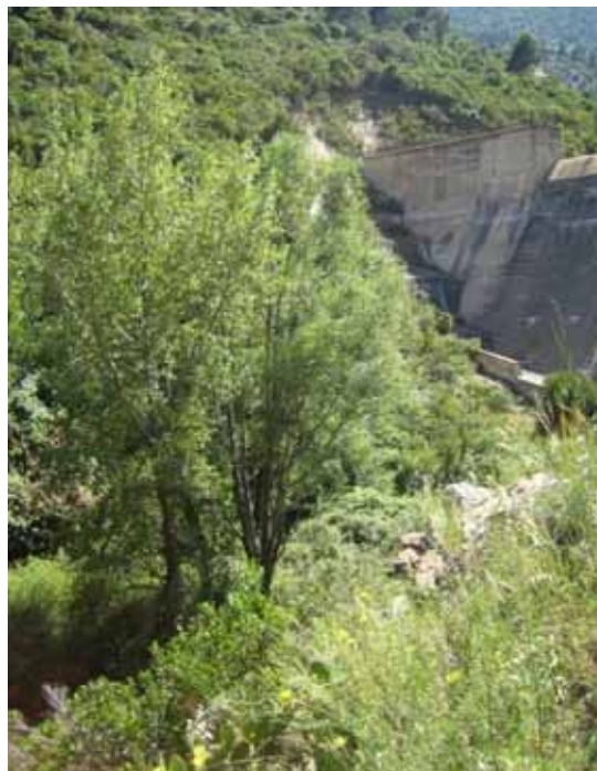
Foto P16.- Arbres a la llera al peu de la paret del pantà, que indiquen l'efecte de control de la presa sobre les crescudes (Foto PMR, maig 2009)
