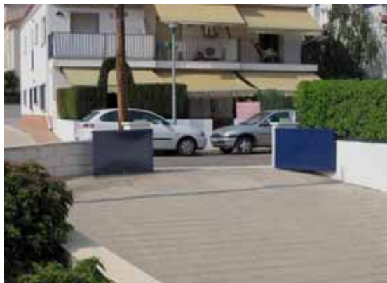
Foto B39.- Comporta de protecció de l'aigua, de 2 batents de color blau, c/ Fages de Climent. (foto PMR, novembre de 2007).
