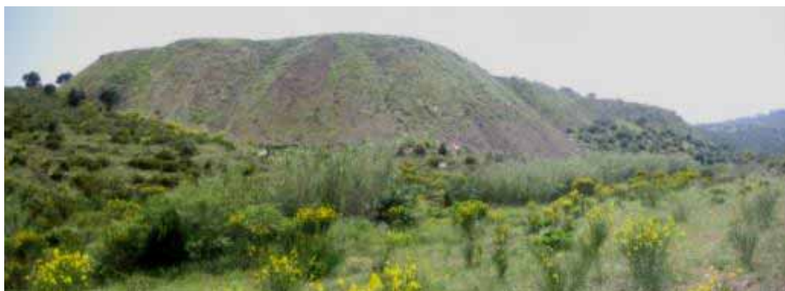
Foto B23.- Abocador des de baix; noti's l'angle del talús, d'uns 40°. (foto PMR, maig de 2009)
