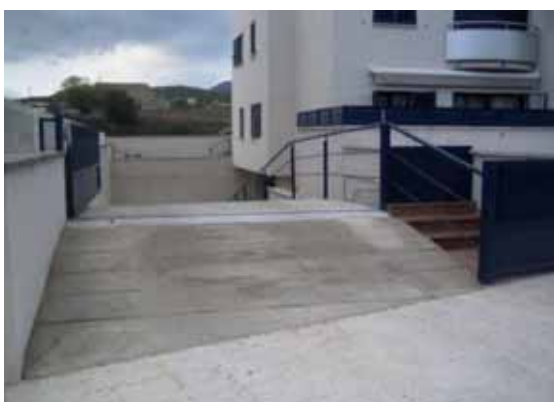
Foto B40.- Cavalló de protecció d'una finca de l'Av. Mestral, acompanyat de graons de pujada i de baixada, així com portes al pas de vehicles i al pas de vianants. (foto PMR, novembre 2007).
