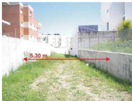
Foto F4.- Tram canalitzat del torrent sud. Aquí l'amplada és de 5.30 m. Al fons a la dreta, murs de 3 m d'alçada per contenir les terres i sobre les que s'edificà (just a la sortida del túnel sud, mirant al mar). (Foto PMR, maig 2009).
