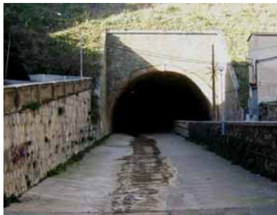
Foto P27.- Boca de sortida del túnel sota la plataforma de l'estació. Alçada del muret de la dreta: 2.10m). (foto PMR, gener 2008).
