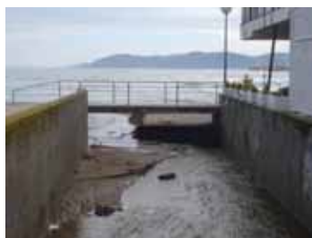
Foto F17.- Passera final oberta per l'aigua. (foto MAM, octubre 2010)
