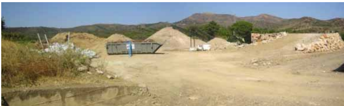
Foto L18.- Planta de reciclatge de runa, ubicada sobre el pla de la terrassa T 1 , a la riba esquerra del rec de Madres. (foto PMR, agost 2008)
