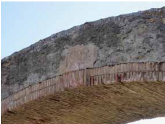
Foto L30.- Pont de la Valleta amb detall de la inscripció "1902" (l'any de construcció de la barana) ( punt L7 ). (foto PMR, agost 2010)
