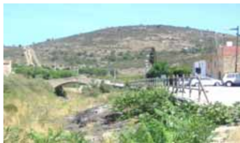
Foto L85.- Punt L6 de desbordament per la riba dreta, al nucli de la Valleta (foto PMR, agost 2008)
