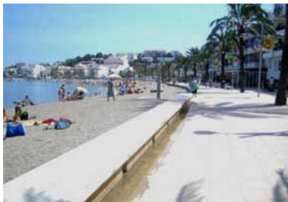
Foto L89.- Passeig del Port de Llançà; notis que l'aigua de la dutxa de platja va cap al passeig que està més baix. Això és un indicador del problema del drenatge del passeig. (foto PMR agost 2008)
