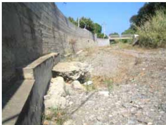
Foto S24.- Mur lateral de protecció, amb reforçament de la base per evitar la socavació. Al fons el pont del càmping del Port de la Selva. (foto PMR, setembre 2008)
