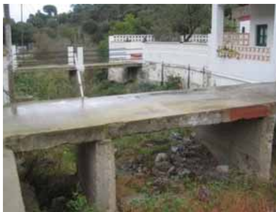
Foto P6.- Les dues passeres de sota de Vil·la Antònia, vistes aigües avall. (foto PMR, novembre 2008) (ample: 8,40m, alt: 1,80m)
