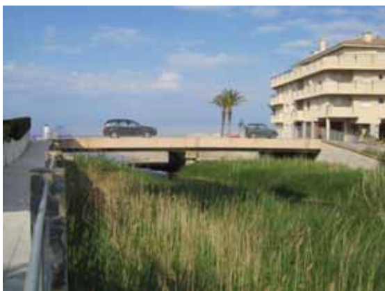
Fotos L36 i L36bis.- Pont de l'Av. Mestral que és insuficient per les grans crescudes ( punt crític L25 ). (foto PMR, novembre 2007)
