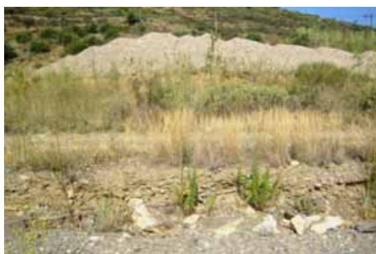
Foto L19.- Acumulació de runa sobre la terrassa T 1 . (foto PMR, agost 2008)
