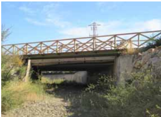
Foto M13.- Pont de la carretera GiV-6121 de la Selva a Port de la Selva (9 m d'ample i 2,80 m d'alt), amb nou pont de fusta per a vianants (2010) (foto PMR, agost 2010)
