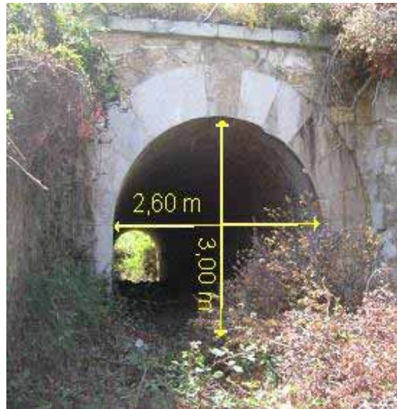
Foto F10.- Túnel del torrent nord sota la via del tren (boca de sortida). (Foto PMR, maig 2009).
