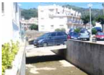
Foto F15.- Riera de Grifeu; tram canalitzat a ran de platja. (foto PMR, juny 2008).
