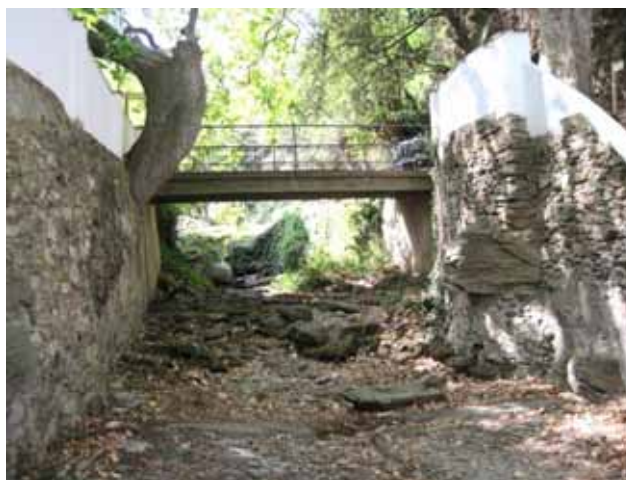
Foto M4.- Passera a nivell de la font del Lledoner (6 m d'ample i 2,30 m d'alt). Noti's la mida d'algun dels blocs de pedra. (foto PMR, agost 2010)
