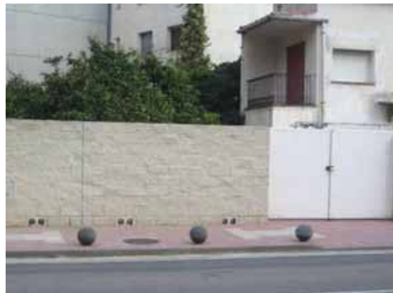
Foto Y12.- Finca que fa la cantonada el carrer Major, per on entra l'aigua, amb la carretera de Cadaqués, per on es produeix la sortida d'aigua després de travessar el jardí. Noti's les perforacions a la tanca que permeten la sortida de les aigües. (foto PMR, febrer 2008)
