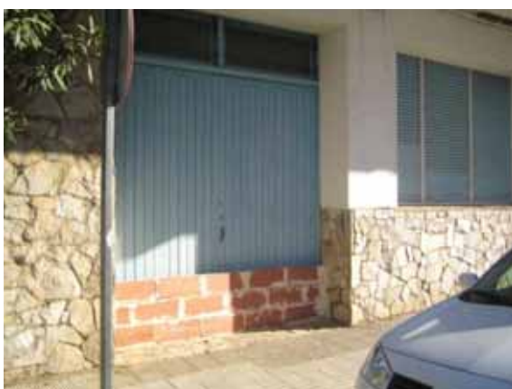
Foto L92.- Protecció amb muret d'envà (Av. Mestral). (foto PMR, novembre 2007)
