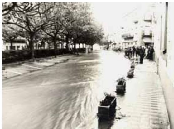
Foto P57.- Rambla, riba dreta, davant de la caserna de G. Civil, a la riuada del 1 de novembre de 1993. (Foto M. Roman, 7, 1 de novembre de 1993)
