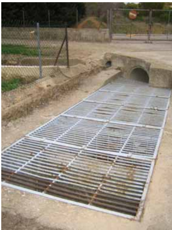
Foto L59.- Un dels embornals d'entrada al rec del Gardissó d'un afluent, al sector de les Esplanes. (punt L23). (foto PMR, gener 2008)
