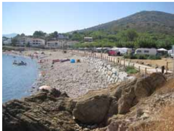
Foto V9.- Platja de la riera de la Vall, amb l'escullera i el mur de contenció sobre el que passa el camí de ronda i l'esplanada del càmping (terrassa T 1 ). (foto PMR, agost 2010)
