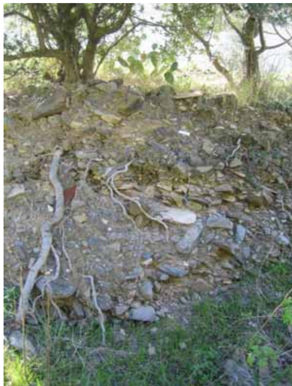
Foto P12.- Detall de la terrassa T_1 , d'un gruix visible de 1.60 m.(foto PMR, març 2008)
