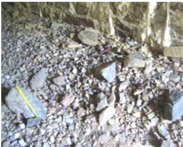
Foto F1.- Interior del túnel nord, amb còdols grossos. (Foto PMR, maig 2009).
