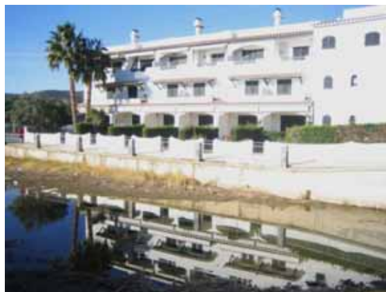
Foto L51.- Murs d'obra que protegeixen la terrassa T_1 sobre la que es situen els Apartaments Doñana, a ran de desembocadura de la riera de la Valleta (Av. Mestral). (foto PMR, novembre 2007)
