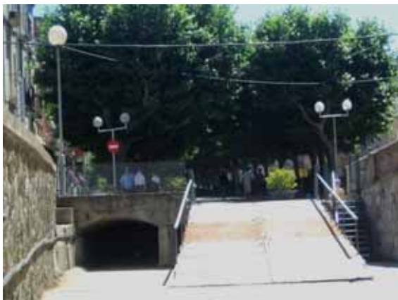
Foto P29.- La mateixa boca del soterrament de la foto P28 a l'estiu. Observi's la rampa destinada a accés a l'aparcament dins de la canalització, que inhabilita dues de les tres boques d'entrada facilitant el perill de desbordament que afectaria la Rambla. (foto PMR, juny 2008)
