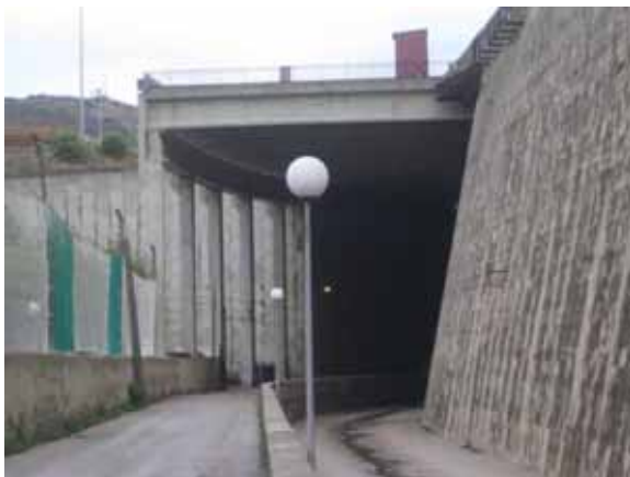
Foto P26.- Boca d'entrada al túnel sota la plataforma de l'estació; a la dreta la canalització i a l'esquerra, més elevat, el camí al pantà, separats per un muret. (foto PMR, nov. 2008).
