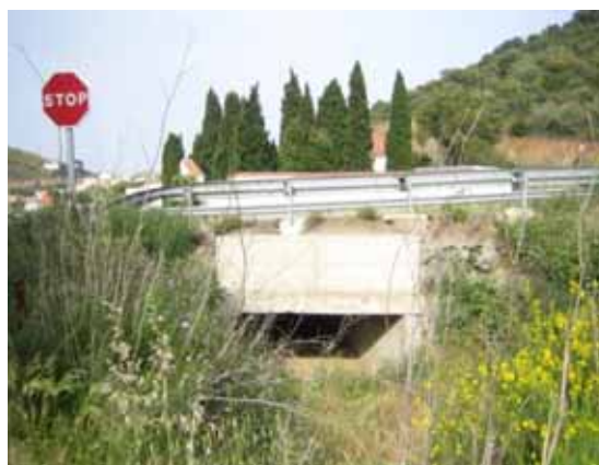
Foto C28.-, Boca d'entrada del Rec de la Fonollera sota la carretera; al fons el cementiri. (foto PMR)
