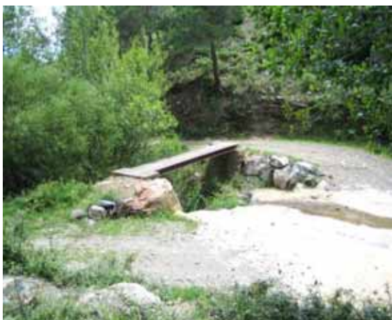
Foto C29.- Passera formada per un simple tauló, al tram de capçalera, a Molinàs. (foto PMR)
