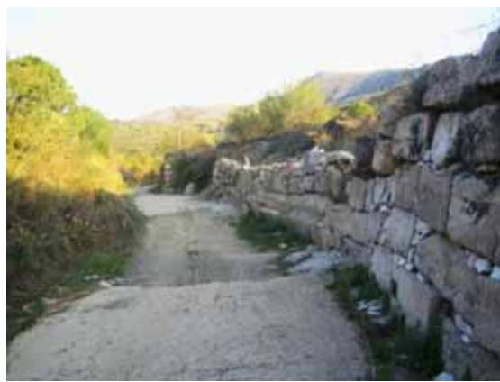
Foto L55.- Escullera al marge dret del camí-llera del rec de Madres. (foto PMR, setembre 2008)
