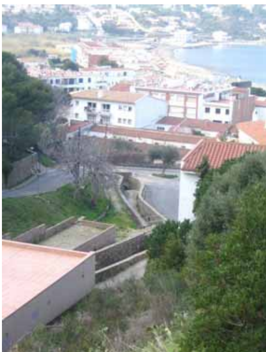
Foto Y7.- Tram mig canalitzat al final del qual hi ha el punt de desbordament Y1 (foto PMR, febrer 2008)
