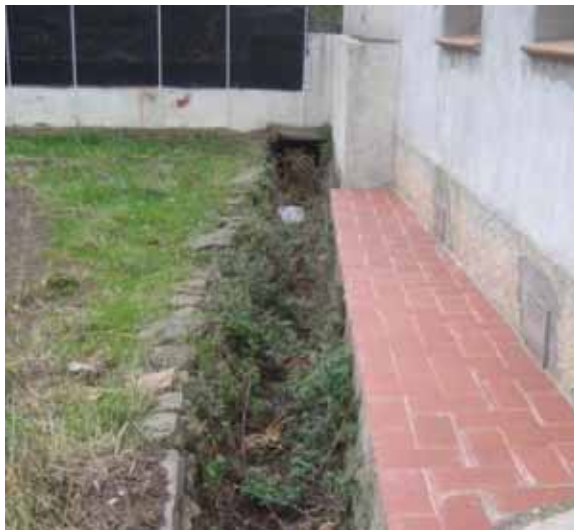
Foto C18.- Restes d'una antiga agulla de drenatge amb la riba esquerra original i la dreta modificada per la vorera de l'edifici. (Sector històric C19.) (foto PMR)
