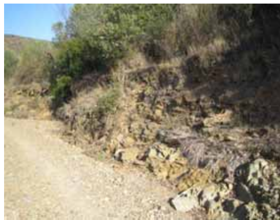
Foto B10.- Aflorament de substrat en el sector de capçalera, a ran de la llera ocupada per la terrassa T 0 . (foto PMR, novembre de 2007).
