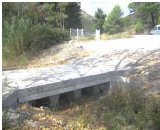
Foto L86.- Punt L10 , a la porta del restaurant de Miralles; notis la petitesa dels 3 tubs per al pas de l'aigua, que no resol el pas en moments de crescuda. (foto PMR, agost 2008)
