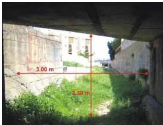
Foto F13.- Pont del torrent sud al carrer Guillem de Berguedà (vista aigües avall). (Foto PMR, maig 2009).
