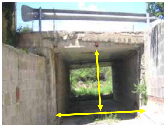
Foto F14.- Pont del torrent nord al carrer Guillem de Berguedà, (mirant aigües amunt). (Foto PMR, maig 2009).
