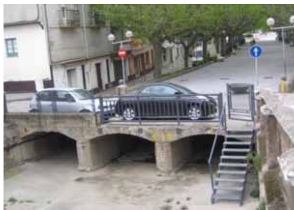
Foto P4.- Vista del tram inferior de la riera, amb la boca d'entrada del tram soterrat sobre el que s'ha construït la Rambla de Catalunya, (foto PMR, 14 d'abril de 2009)
