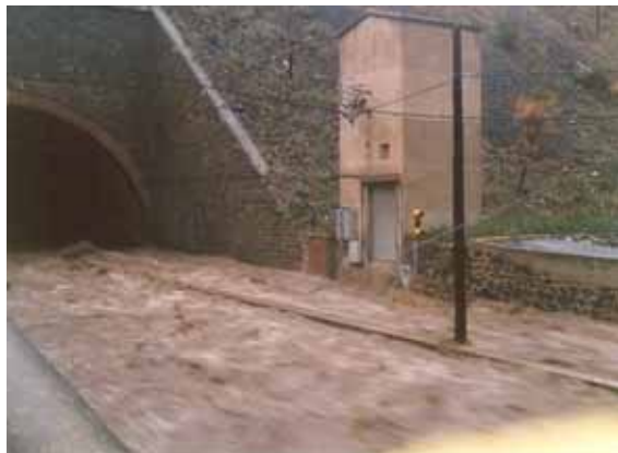
Foto P37.- Boca de sortida del túnel de sota de l'estació; en primer terme la canalització (2.10 m de làmina d'aigua i 9,50 m d'ample) i a la dreta el carrer (1.00 m de làmina d'aigua i 5,50 m d'ample) (Foto M. Roman, S-13, 3 d'octubre de 1987).
