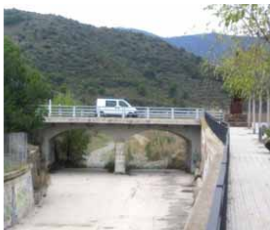
Foto C30.- Pont de la carretera sobre la riera, just a l'inici de la canalització, i que pot provocar problemes d'embús i desbordament. (foto PMR)
