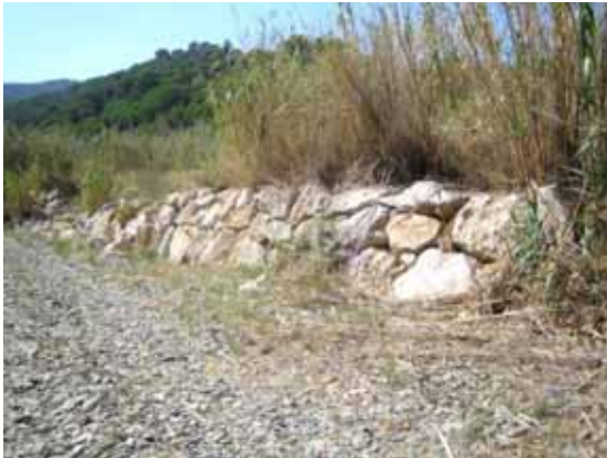
Foto S19.- Escullera a la riba esquerra, tram ben conservat i resistent. (foto PMR, setembre 2008)
