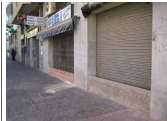
Foto L100.- Combinació d'envà i fusta al mateix edifici, C/ Castellar. (foto PMR, novembre 2007)
