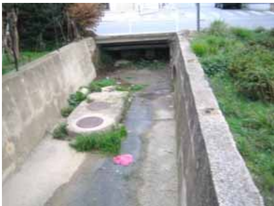
Foto L61.- Sortida del soterrament després de la confluència dels recs del Gardissó i de la Bateria, a l'Av. Pau Casals. (foto PMR, gener 2008)
