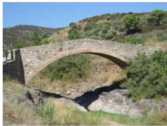
Foto L29.- Pont de la Valleta amb els estreps recolzats en roca; alçada des del centre de l'arc fins al centre de la llera 5,5 m i ample de la base de l'arc 11 m ( punt L7 ). (foto PMR, agost 2010)
