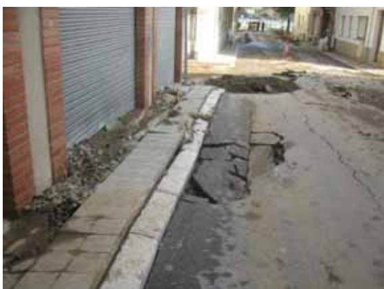
Foto E6.- Un altre aspecte de la deformació dels paviments i restes de grava sedimentades pel mateix aiguat, a ran de les persianes dels baixos de l'Av. Barcelona nº 6. (foto cedida per ajuntament).
