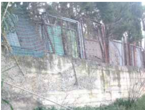
Foto L50.- Riera de la Valleta, mur de canalització i protecció dels horts ( T_1 ), coronat per tanca de ferros. (foto PMR, 2008)
