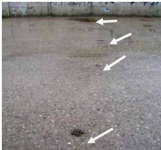
Foto C20.- Perforacions a les lloses de la base de la canalització per tal de disminuir la subpressió de l'aigua de l'aquífer subterrani. (Sector històric C19.) (foto PMR, juny 2008)
