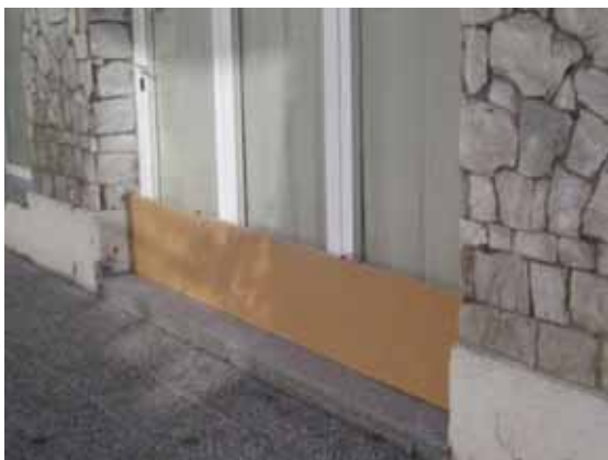
Foto L96.- Post de fusta de posar i treure, C/ Castellar. (foto PMR, novembre 2007)
