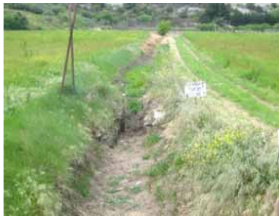
Foto B8.- Rec del Lliris a ran de la carretera N-260, amb estructura per a comporta de rec per inundació (foto PMR, abril 2008)
