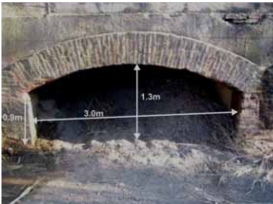
Foto B30.- Riera del Boquer, boca nord dreta del tram soterrat just per sota de la carretera N-260; obturada en aquest moment. (secció: 3,5 m 2 ) (foto PMR, novembre de 2007).
