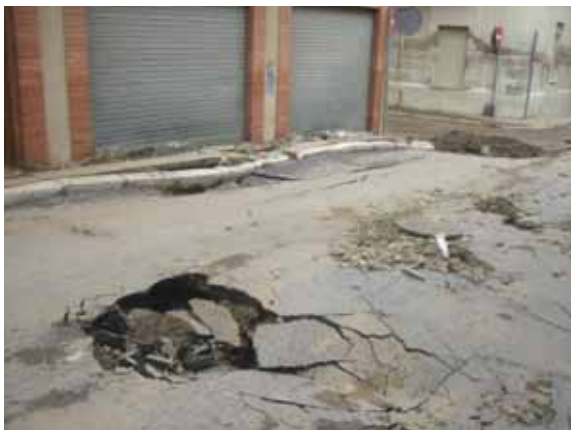
Foto E4.- Deformació i trencament dels paviments per rebentada de la canalització soterrada a l'aiguat del 2006, a l'Av. Barcelona nº 6 i cruïlla del C/ Méndez Núñez. (foto cedida per ajuntament).
