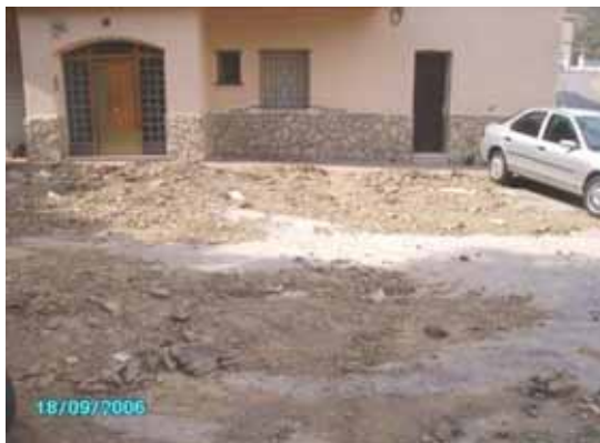
E8.- Estat de l'Av. de Barcelona nº 31, després del pas de les aigües, quan les terres acumulades havien estat ja parcialment tretes. (foto cedida per ajuntament).
