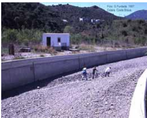
Foto C45.- Sediments sobre la llosa de la canalització (després de la riuada del 13 de novembre de 1997) (Sector històric C19) (foto G. Furdada)
