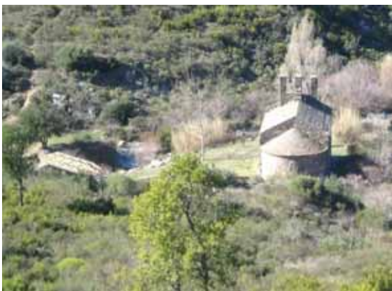
Foto L28.- Pont de fusta a l'ermita de St. Silvestre ( punt L1 ). (foto PMR, febrer 2008) 053
