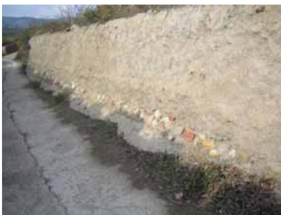
Foto L58.- Reforç de la base d'un mur de protecció, que havia estat erosionat per l'aigua; rec de Madres. (foto PMR)
