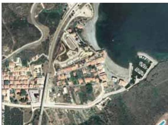
Foto C34 .- Vista aèria d'un tram de la canalització i de la desembocadura dins del port. (foto ICC)
