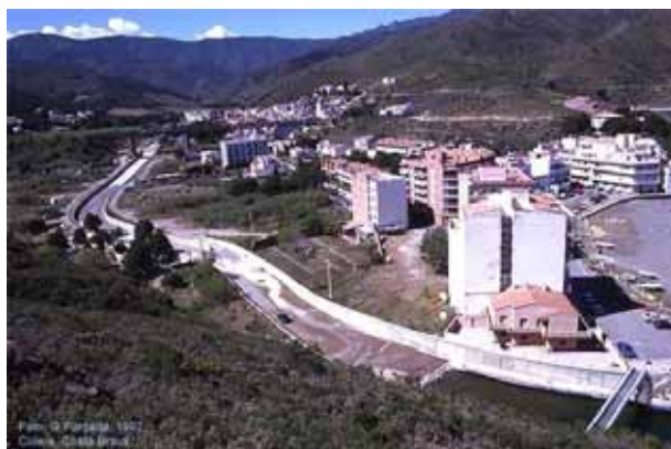
Foto C46.- Tram final de la riera de Molinàs, amb acumulació de sediments en llargs trams, des de la corba fins al port, després de l'aiguat del 13 de novembre de 1997. (Sector històric C19 i crític C20) (foto G. Furdada)
