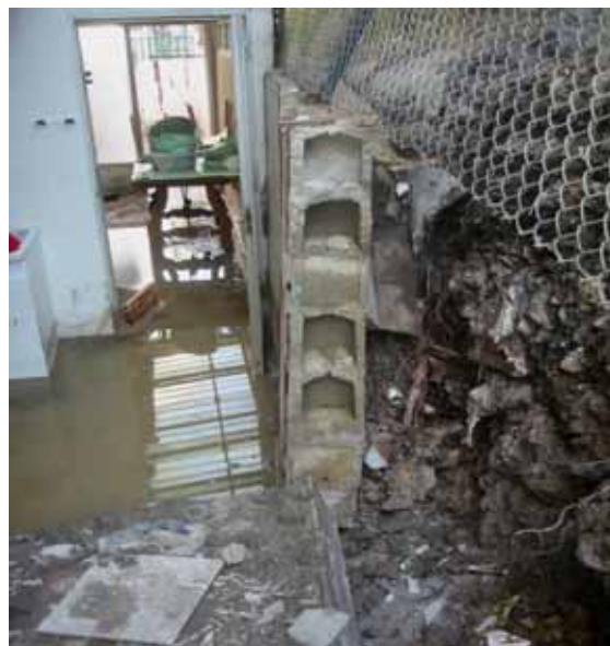
Foto E11.- Detall d'acumulació de blocs i grava darrere d'un mur d'uns 1,80 m d'alt bolcat per l'empenta; notis que, en el tram encara dempeus, la grava sobrepassa l'alçada del mur (foto cedida per ajuntament).
