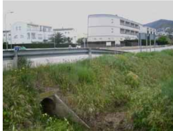
Foto B29.- Boca d'entrada del rec dels Lliris a la canalització sota la carretera (punt B8). (foto PMR, abril 2008).
