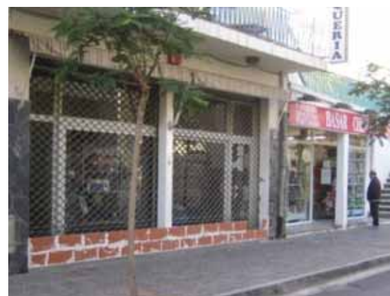
Foto L93.- Muret de 2 fileres (una sola davant la porta, per facilitar el pas i tancar ràpidament quan cal), C/ Castellar. (foto PMR, novembre 2007)
