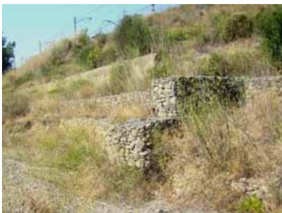
Foto L46.- Gabions i mur de protecció de l'erosió del terraplè del tren. (foto PMR, agost 2008) 9107
