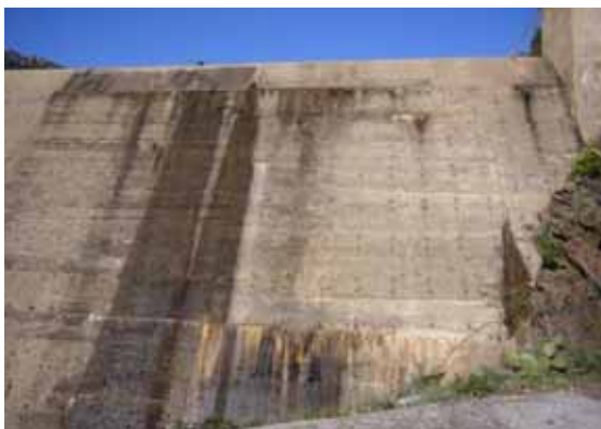
Foto P24.- Pantà, ple i vessant per les juntes (foto Marques, 20 de març de 2009)
