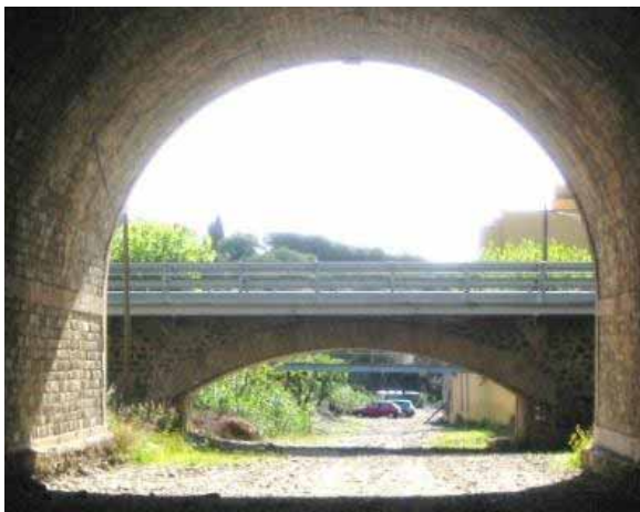
Foto G7.- Vista aigües avall del tram final de la riera: en primer terme el túnel del tren, després el pont de la carretera N-260 i al final la passera del càmping. Notis la evident reducció de la secció que implica el pont de la carretera. (foto PMR, abril 08)
