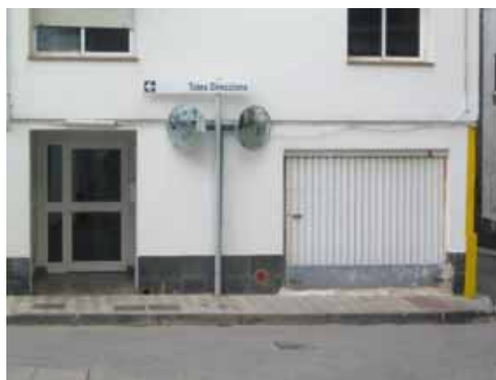
Foto Y10.- Habitatge del carrer Major, on van a topiar les aigües del rec quan desborden al punt Y1. Noti's la protecció amb post existent a la porta del garatge (foto PMR, Febrer 2008)
