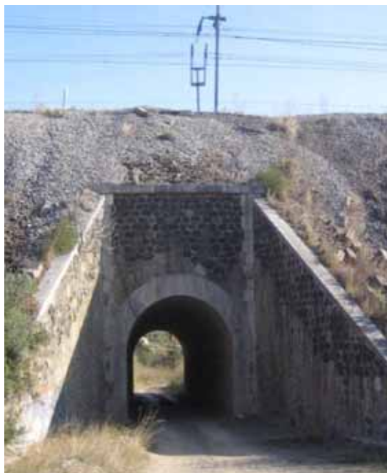
Foto GG15.- Exemple del terraplè del ferrocarril, d'uns 12 m de gruix. (foto PMR, novembre de 2007).
