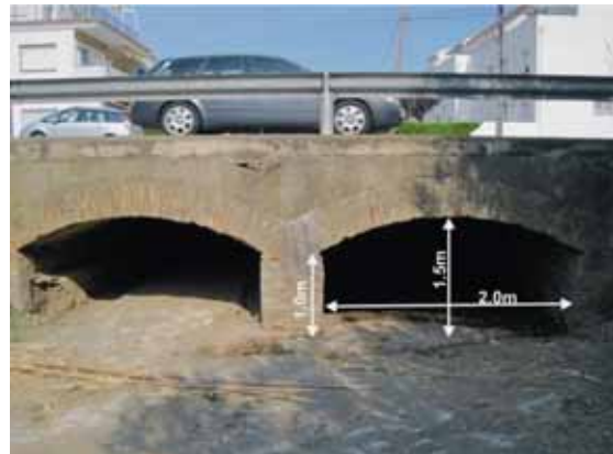
Foto B31.- Riera del Boquer, Boques d'entrada del soterrament al carrer de Fages de Climent, acabades de netejar (Foto PMR, juliol 2010)
