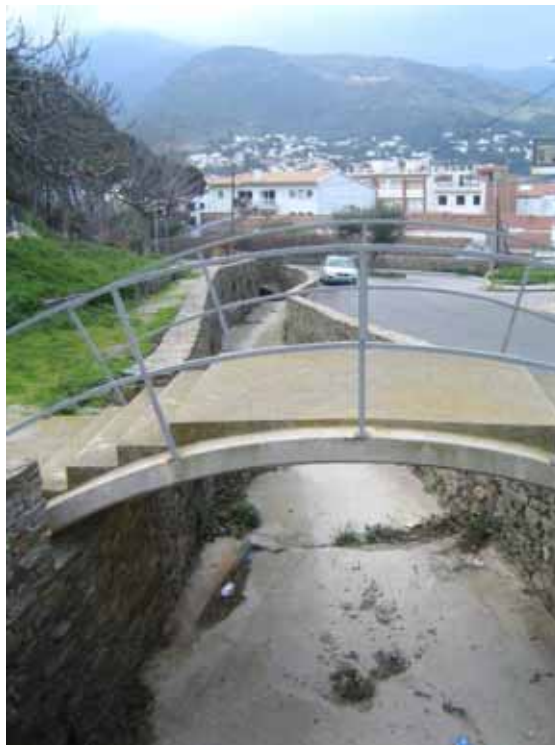
Foto Y16.-Canalització en el tram mig amb el "Pont rodo" (peatonal) (foto PMR, febrer 2008)
