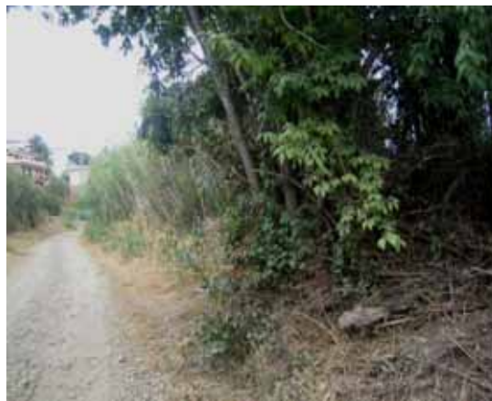
Foto B20.- Mota a la riba dreta del camí-llera, en el tram inferior, just passat el túnel del ferrocarril, a nivell del punt crític B-6. (foto PMR, agost 2008).
