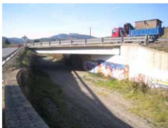
Foto L35.- Pont de la carretera N-260. (foto PMR, novembre de 2007)
