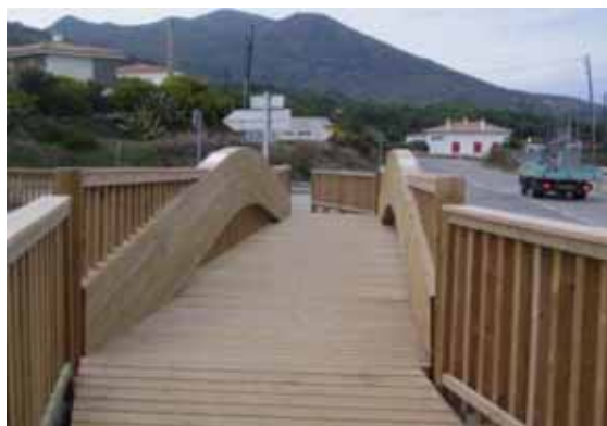
Foto M 16.- Pont peatonal de fusta, adossat al pont de la carretera GiV-612 de Llançà al Port de la Selva (foto PMR, novembre 08)
