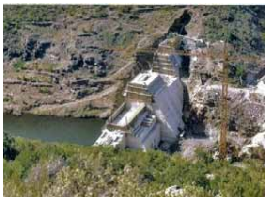
Foto P21.- Pantà en construcció, el 1967, (foto d'autor desconegut, obtinguda al Google map)
