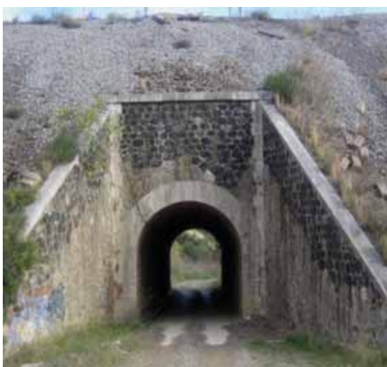
Fotos B26 i B27.- Boques d'entrada (esquerra) i de sortida (dreta) del túnel sota el tren, per on circula el torrent i les persones i vehicles (4 m d'ample i 5 m d'alçada màxima; secció: 18,2 m 2 ). (foto PMR, 2008).
