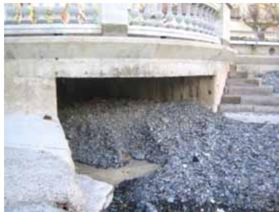
Foto E15.- La mateixa bocana actualment, amb acumulacions de grava. (foto PMR gener del 2008)
