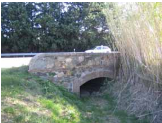
Foto L38.- Pas del rec de Setcases sota la carretera, on es redueix la secció (foto PMR, febrer 2010)
