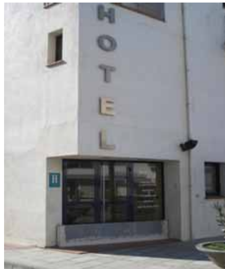
Foto Y20.- Protecció als baixos de l'hotel Mariner a l'hivern (foto PMR, febrer 2010)
