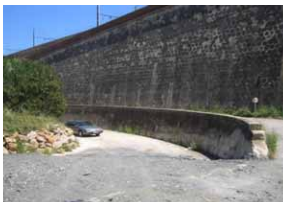
Foto P31.- Detall de la mateixa rampa, vista aigües avall. (foto PMR juny 2008).
