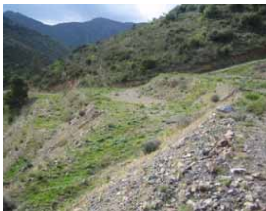
Foto P14.- Detall de la part central de l'abocador, amb la successió de plans separats per talussos de 50 a 60°. (foto PMR, març 2008)
