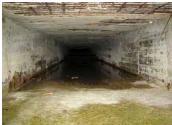
Foto B33.- Detall de l'interior d'una de les bocanes de sortida al mar; poc més amunt ja està totalment colmatada. (foto PMR, abril 2008).
