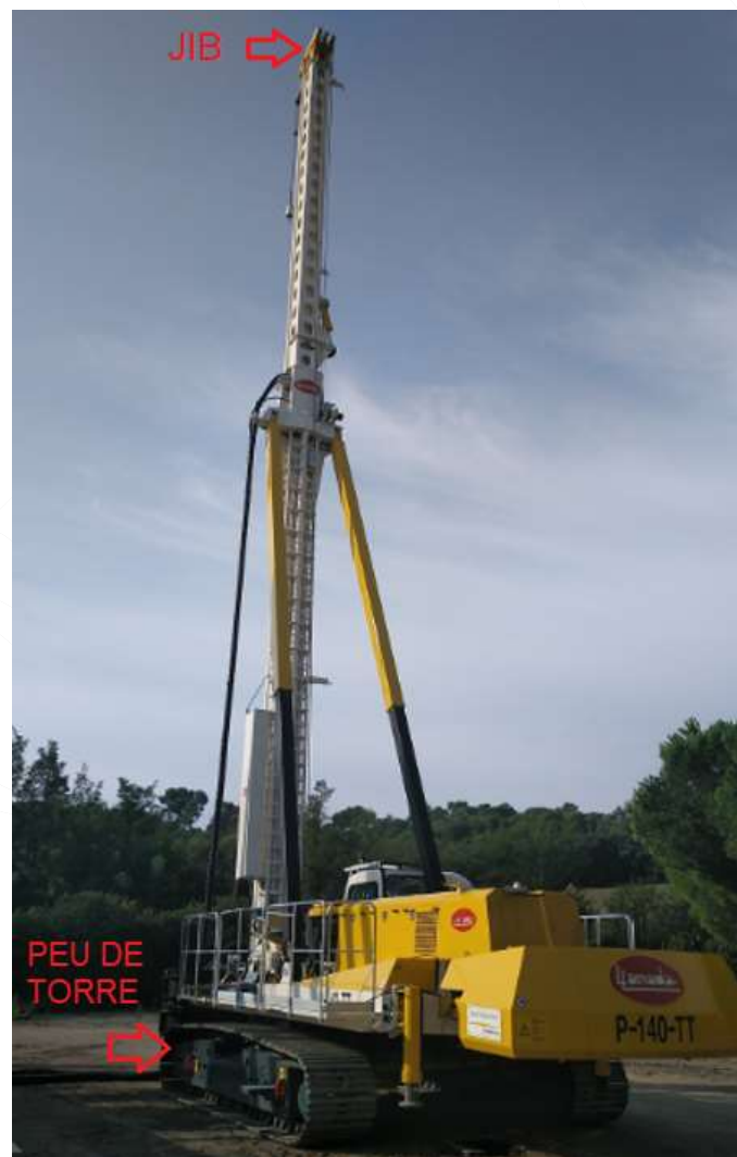
Figura 8-3: Màquina d'execució de pilots LLAMADA P140
