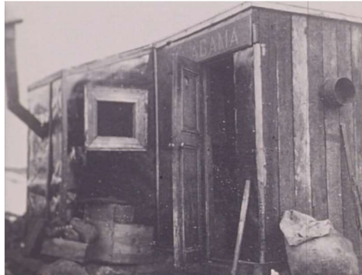
Fotografía del refugio construido con restos del naufragio del Alabama
