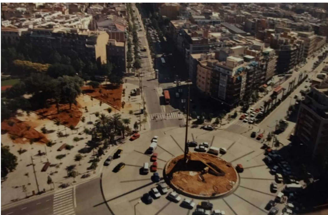
Imatges de la plaça Lluçmajor durant la instal·lació del pedestal de Piñón i Viaplana. S.d. (autor desconegut, AMDNB)
