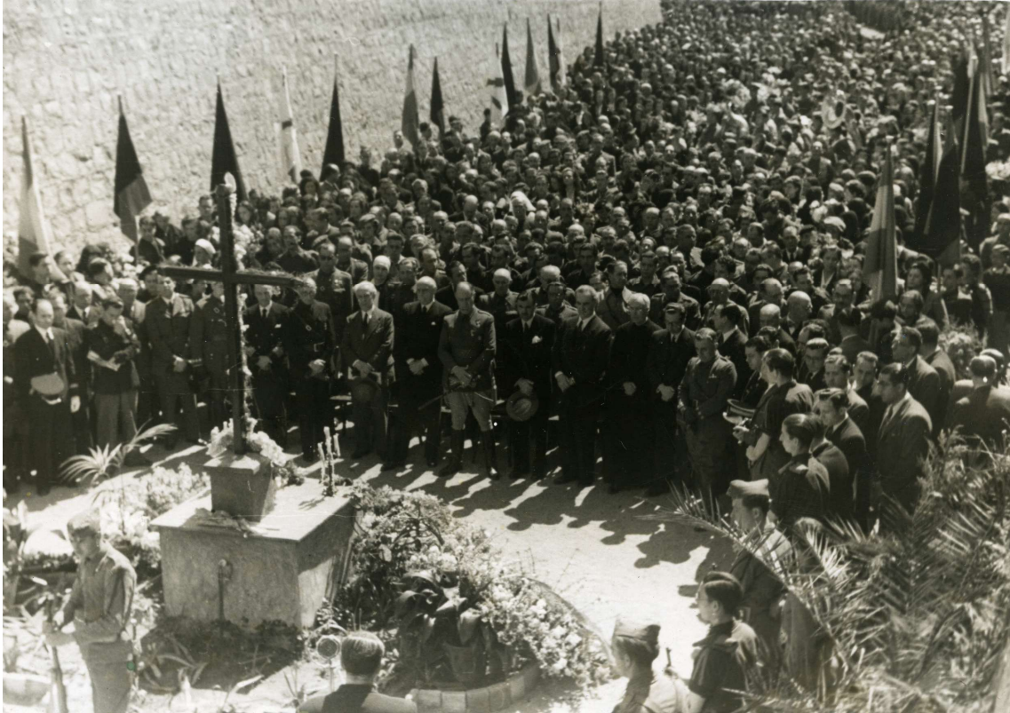
Inauguració del monument provisional als “caídos” el 16 d’abril de 1939 (Pérez de Rozas, AFB)
