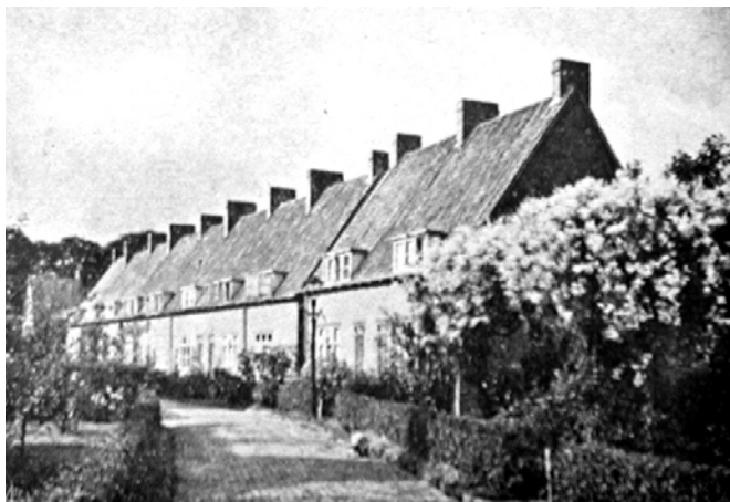
fig. 1.76 – Habitações para operários na cidade jardim de Tuindorp Vreewuk, em Roterdão. Francisco Keil do Amaral, O Problema da Habitação . Porto: Livraria Latina, 1945, s/pág.
