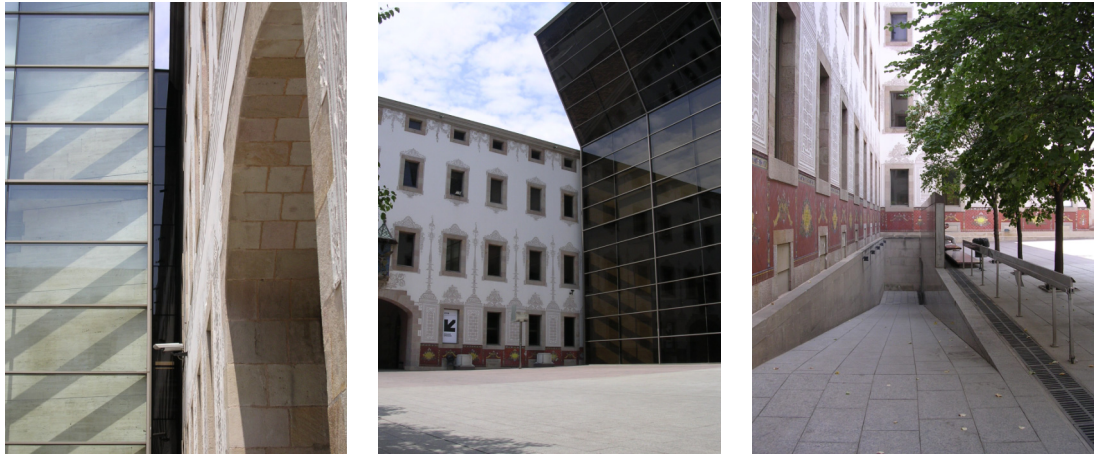
Fig. 28, 29 y 30. Centro de Cultura Contemporánea de Barcelona. Pormenores del patio principal, donde se puede ver el contraste entre la intervención contemporánea y edificio recuperado.
