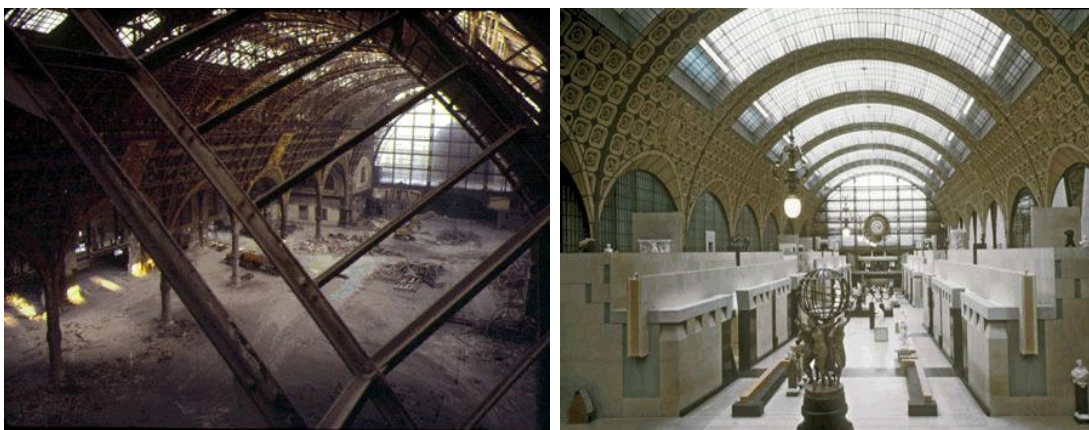
Fig. 12 y 13. Interior de la Estación de Orsay en París. Vemos el estado en que se encontraba antes de la intervención que lo convirtió en el Museo de Orsay. La intervención ocupa el espacio de forma muy diferente y crea nuevos elementos, que se agregan a los originales. Pero podemos reconocer la estructura original. El [Re]uso Creativo no puede ni pretende poner en causa el “alma” o la “esencia” del edificio.
