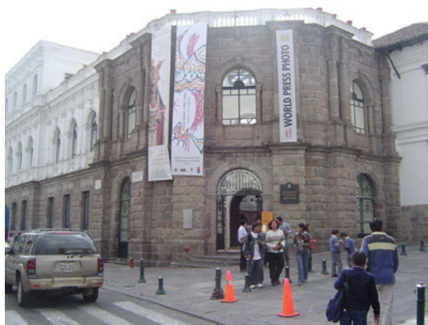
Figuras 25. Centro Cultural Metropolitano de Quito. Vista del exterior del edificio donde se puede apreciar las principales características del edificio existente..
