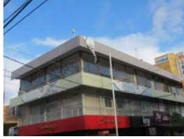
Edificio esquina de calle Colón y avenida Escobedo
