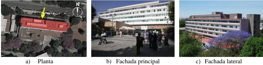
Figura 4-82. Vistas generales del Hospital de Gineco Obstetricia 3
