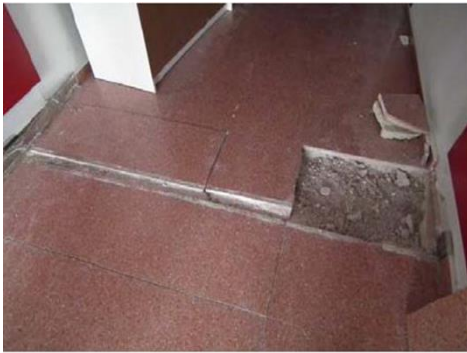
a) Daño estructural. Desplazamiento de la junta
