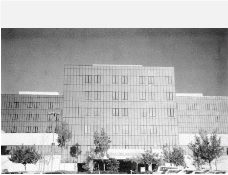
a) Daño estructural. No se evidenció daño
