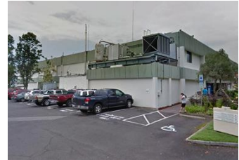
c) Fachada lateral
