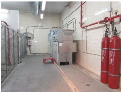
a) Acometida eléctrica
