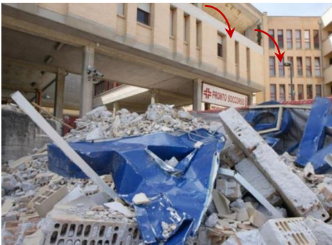
a) Daño en elementos arquitectónicos. Colapso de la envolvente
