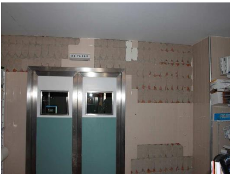
a) Daño en elementos arquitectónicos. Desprendimiento de acabados
