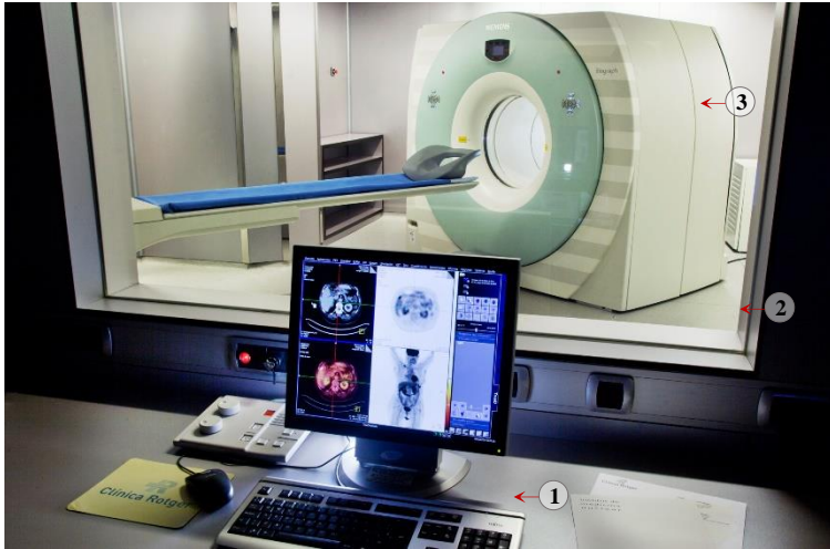
1. Puestos de control de equipos; 2. Ventana plomada; 3. Interior de la sala de tratamiento
