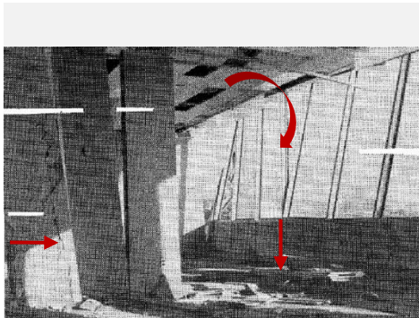
a) Daño en elementos arquitectónicos. Daño completo en las dos plantas bajas
