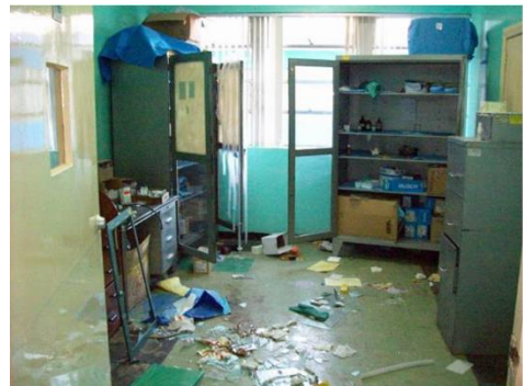
Figura 4-36. Daños no estructurales en el caso 7
