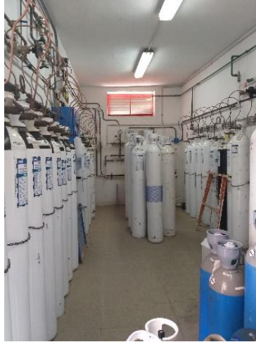
Figura 2-35. Baterías de botellas de reserva
