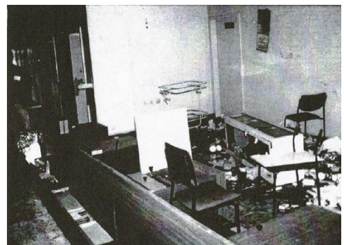
d) Daño en contenidos. Caída de material (estanterías, archivadores, etc.)
