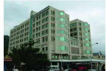
c) Fachada lateral
