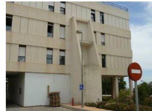
c) Fachada lateral
