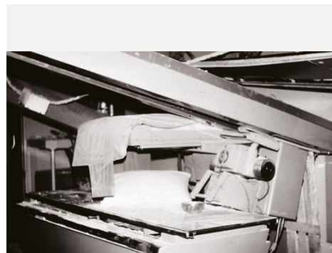
c) Daño en equipamiento médico. Caída del equipo de radiología
