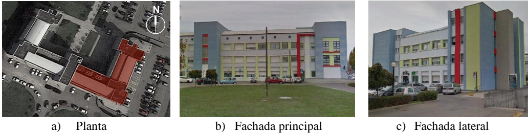
Figura 4-57. Vistas generales del Hospital Santa María Bianca (edificio de servicios generales)
