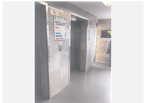
b) Daño en instalaciones. Sin daño aparente
