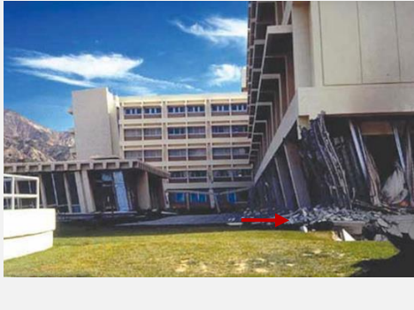
a) Daño estructural. Deformación en las 2 plantas bajas (planta blanda)
