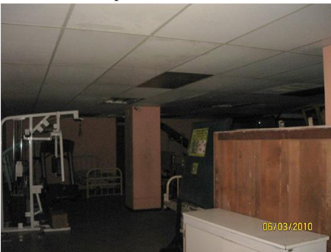
c) Daño en equipamiento médico. Deslizamiento de equipos
