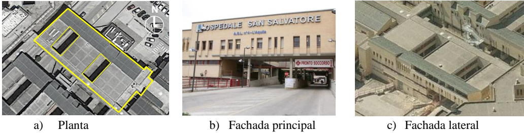
Figura 4-37. Vistas generales del Hospital San Salvatore
