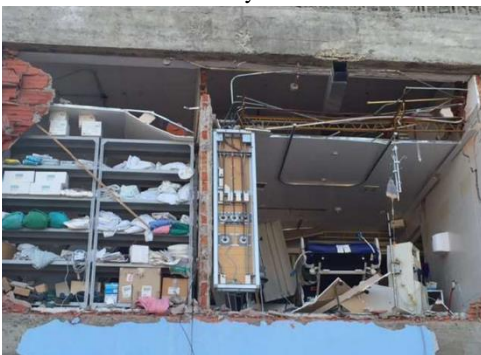
c) Daño en equipamiento médico. Daño en unidades de atención hospitalaria
