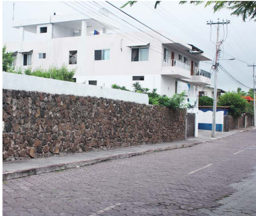
Figura 86: Fotografía de un muro de cerramiento en los terrenos de borde, tomada por el autor en el año 2020.
