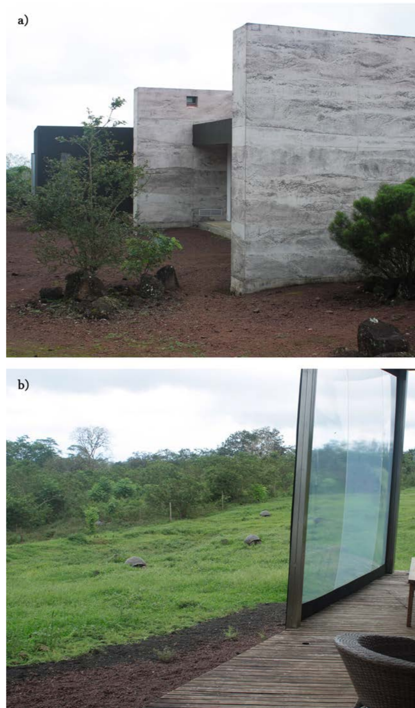
Figura 148: Fotografía de la casa hacienda Montemar. a) Vista del exterior de la casa, mostrando la relación entre el material de la casa y el contexto; b) vista desde la terraza, a lo lejos se pueden apreciar las tortugas gigantes moviéndose en el paisaje. Fotos tomadas por el autor en el año 2014 y 2020.
