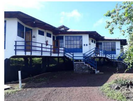
La edificación a pesar de estar levantada del suelo, posee un aspecto de permanencia y sujeción al contexto. El color y textura de las escaleras en piedra la conectan con el suelo
