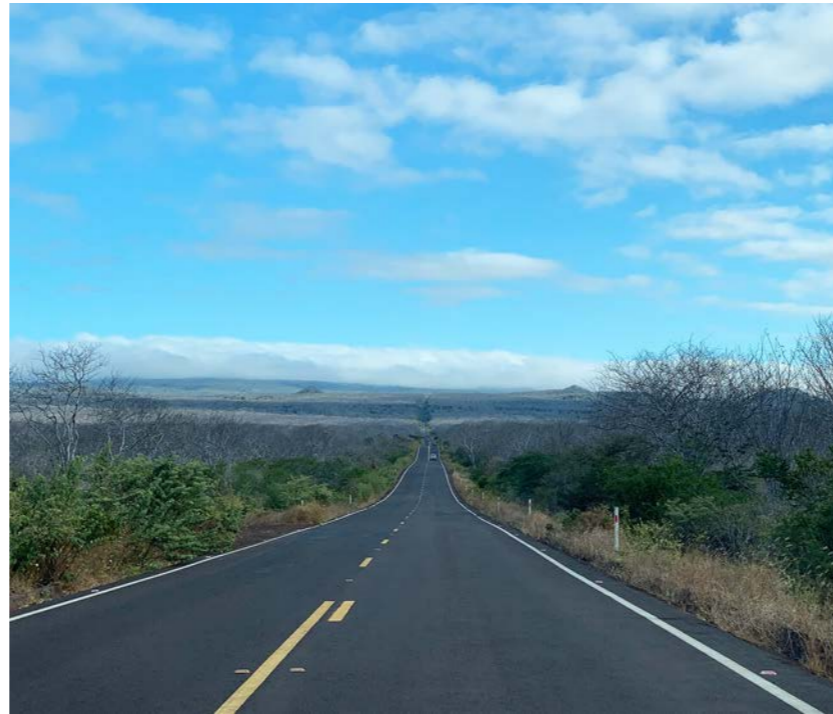
Figura 117: Fotografía de la carretera a Baltra mostrando la diferencia de vegetación entre el borde de la carretera y el resto de la isla. Tomada por el autor el año 2020.
