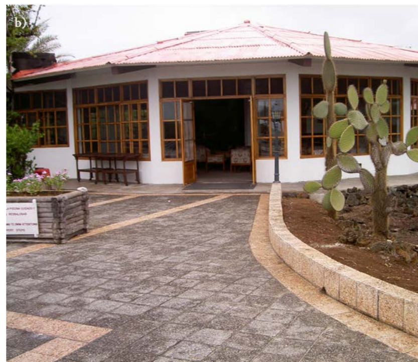
Figura 58: Fotografías del módulo principal y el restaurante del Hotel Delfín. a) vista desde la playa; b) vista de la entrada al módulo de restaurante, cortesía del Arquitecto Alfredo Rivadeneira en el año 2019.
