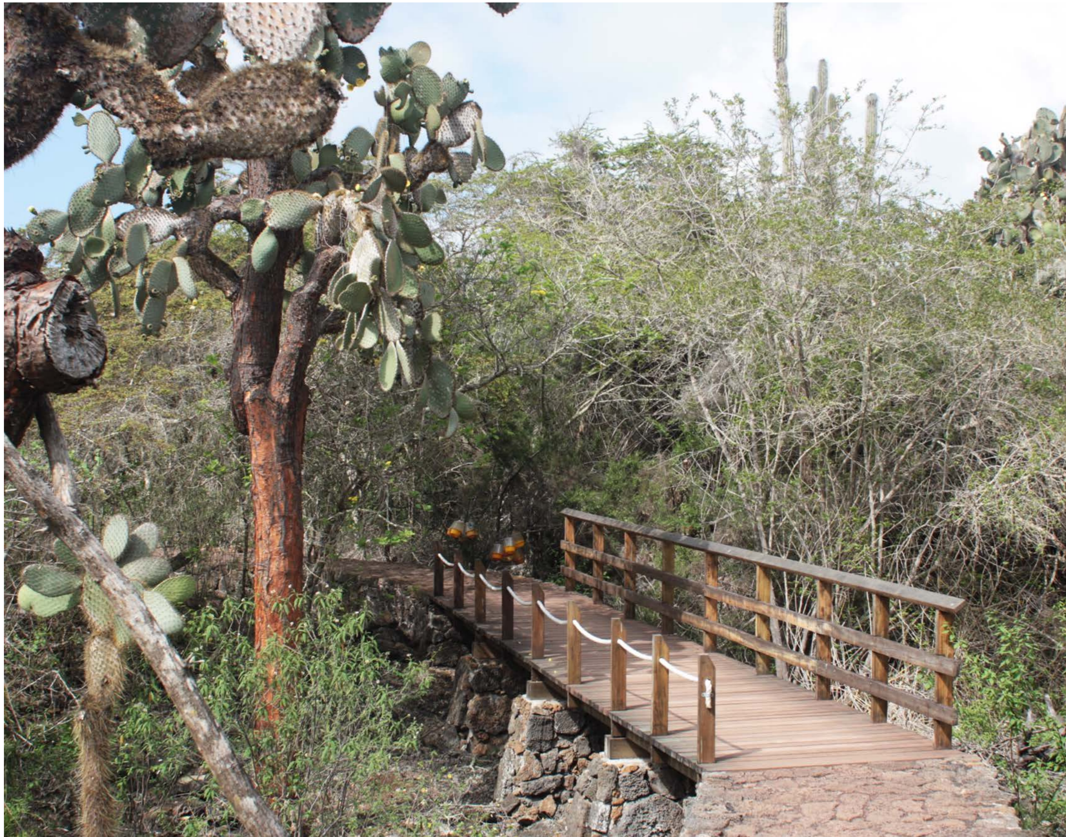
Figura 145: Fotografía de la caminería de la Ruta de la Tortuga, mostrando la base de piedra lava que sostiene la estructura de madera. Tomada por el autor en el año 2020.
